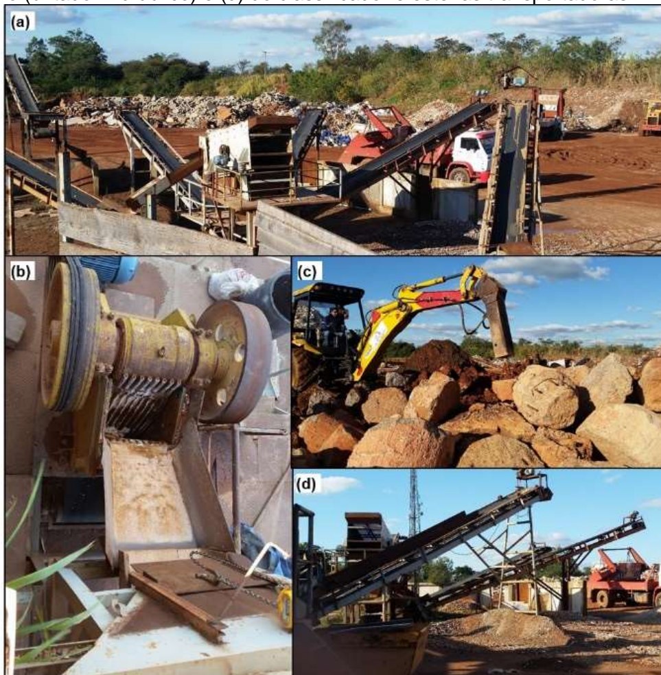
Figura 16 – Fotografias da usina recicladora privada de Campinas – SP: (a) vista geral da área de transbordo; (b) do britador principal (britador de mandíbulas); (c) do britador secundário (britador hidráulico) e (d) do classificador e esteiras transportadoras.
