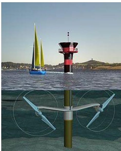
Figura 12 – Usina de Correntes Marítimas da SeaGen
