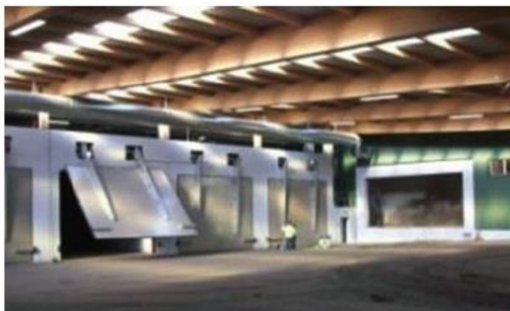
Figura 10: Sistema de abertura dos túneis de metanização.
