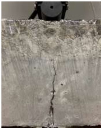
Figura 32 – Trincas que aparecem durante a realização do ensaio
