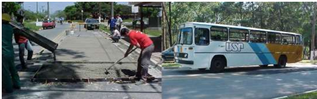
Figura 9 – Concretagem da pista experimental de whitetopping e a pista em operação
