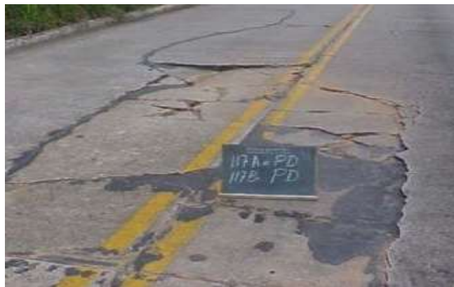
Figura 7 – Placas divididas no pavimento rígido
