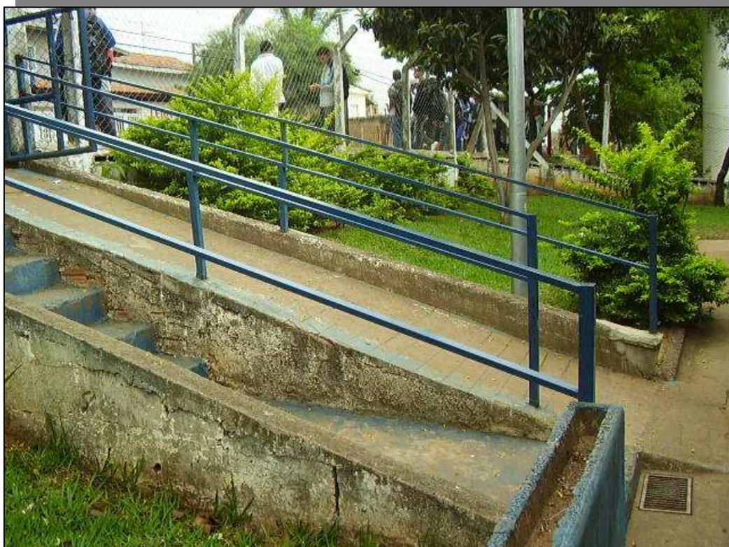
**Figura 65.** Rampa para acesso a pessoas portadoras de necessidades especiais.
