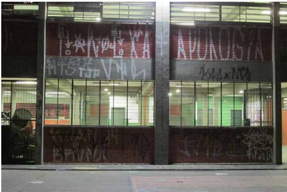
Figura 3. Vista de uma das paredes da escola.
