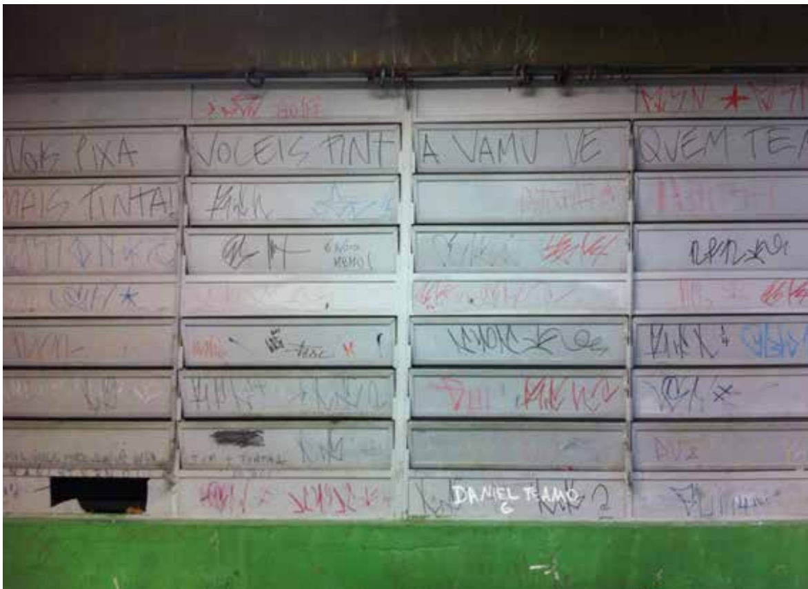
Figura 7. Janela da sala de aula
