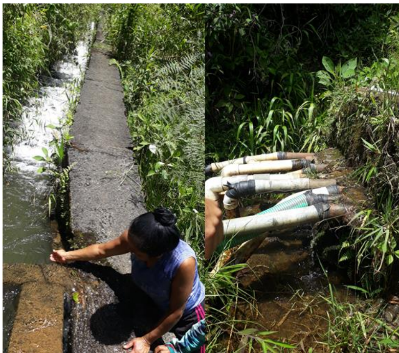
Figura 33 - Extravasor da EPM e captação de água pelos moradores, a meia encosta.
