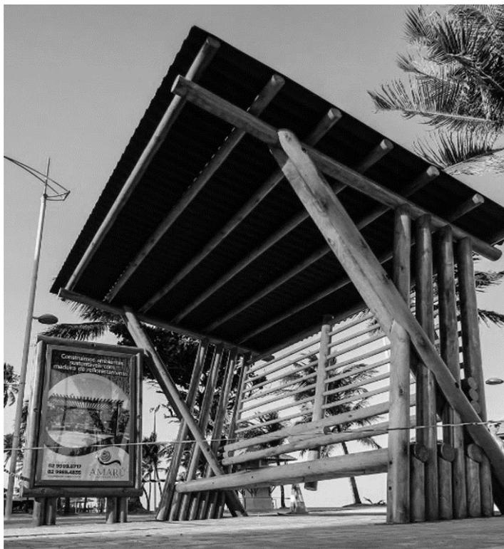
Figura 68: Parada de ônibus com estrutura em bambu. Fonte: <http://www.maceio.al.gov.br>. Foto: Pei Fon Secom Maceió
