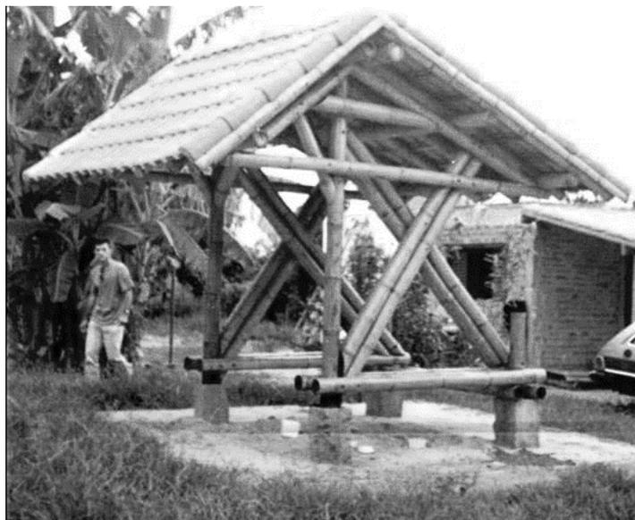
Figura 69: Quiosque com estrutura em bambu construído na UNESP - Botucatu, SP. Foto: Foto M. Pereira e Beraldo, 2008
