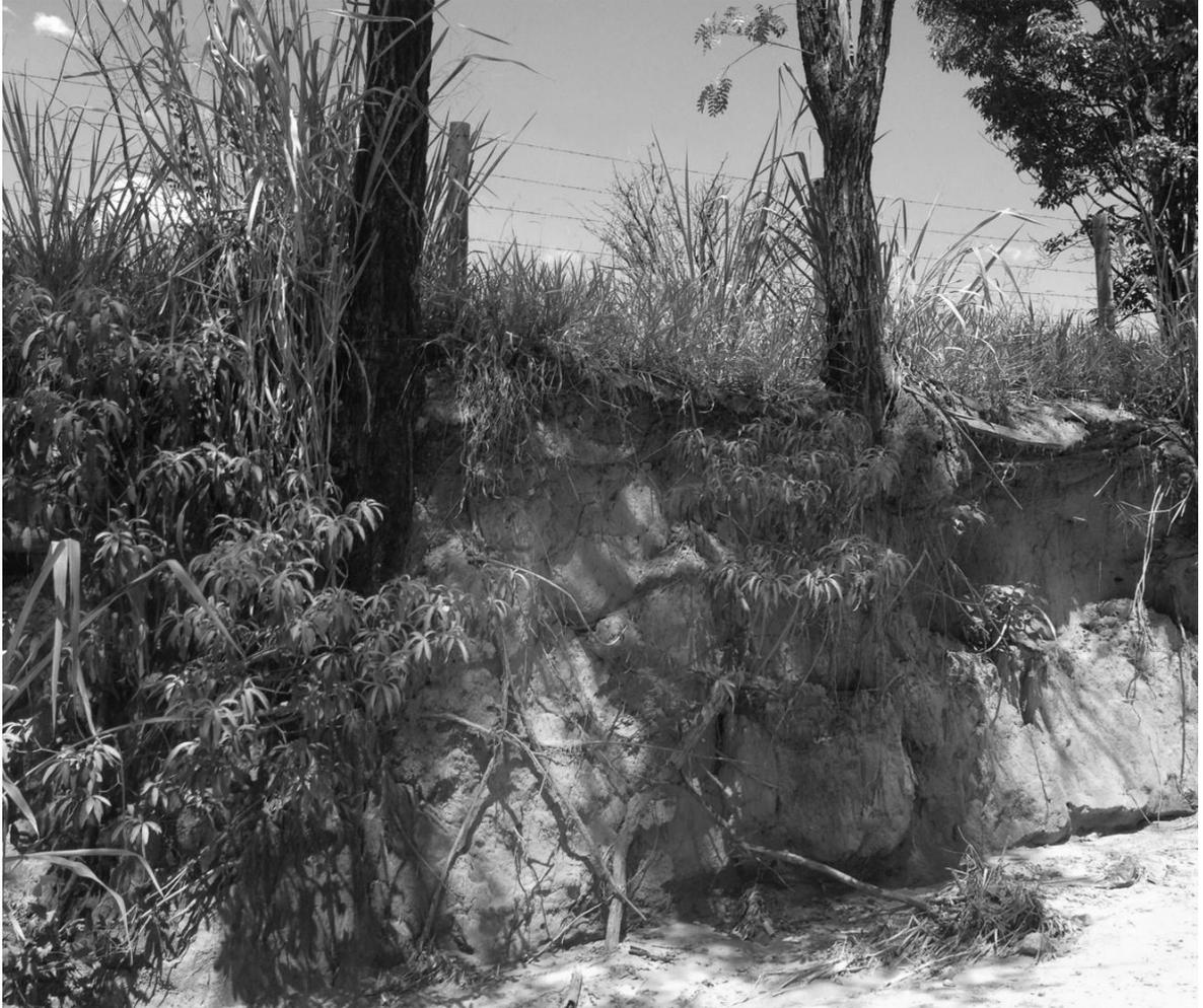
*Figura 13- Exemplo de vias com barrancos formados pela manutenção realizada pela Subprefeitura, com máquinas de terraplanagem.*
