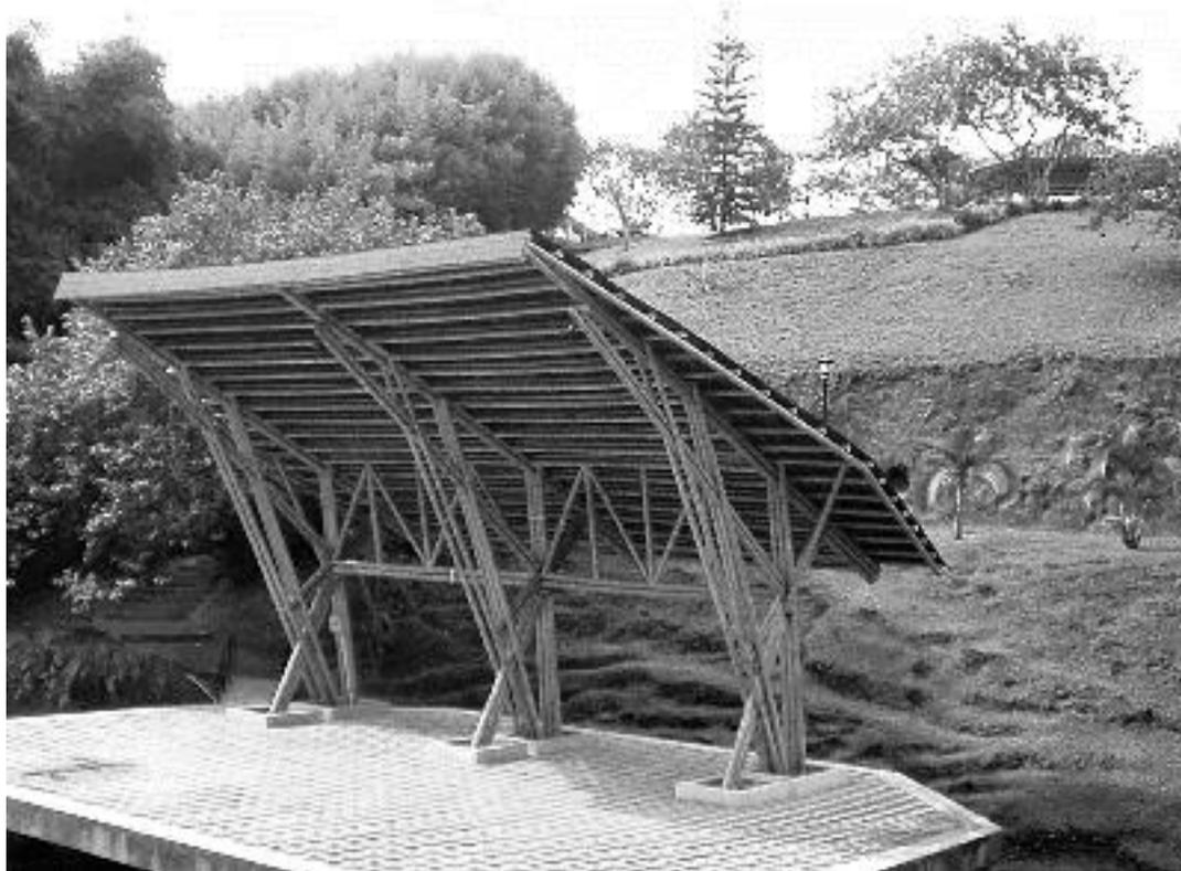
Figura 70: Parada de ônibus com estrutura em bambu. Colômbia. Foto M. Pereira e Beraldo, 2008
