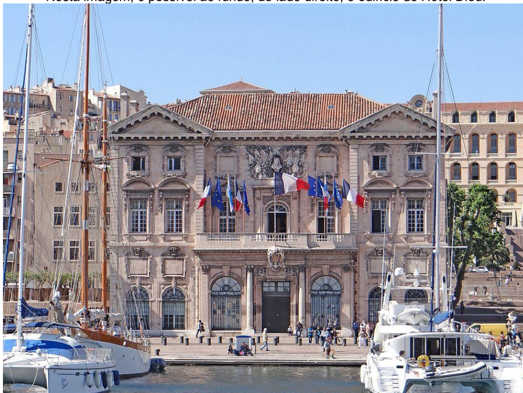
Figura 15: O Hôtel de Ville de Marselha na atualidade sem os edifícios que o ladeavam, pois foram dinamitados em 1943, durante a ocupação do exército alemão na II Guerra Mundial. Nesta imagem, é possível ao fundo, do lado direito, o edifício do Hôtel Dieu.
