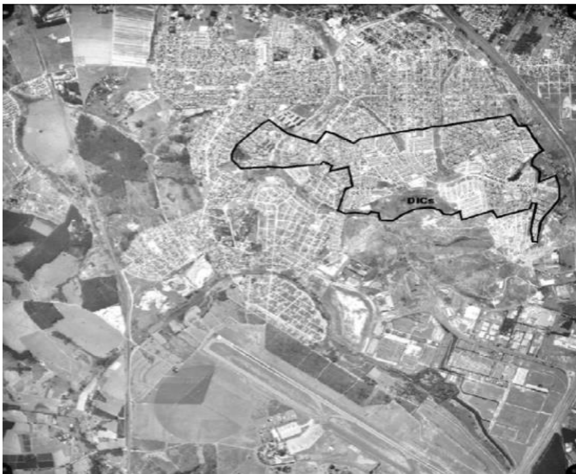
Figura 32. Imagem aérea dos DIC's e do VCP (1994)
