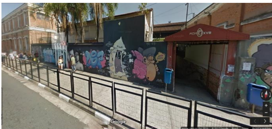
Figura 25. Túnel de Pedestres com acesso à Estação Ferroviária
