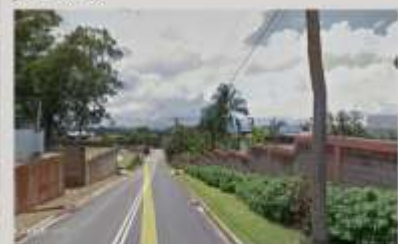
Foto 2: Testada principal do núcleo com muro de fechamento e ausência de passeio para pedestres.
