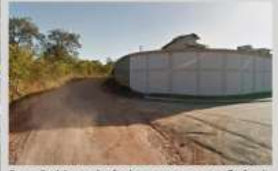
Foto 2: Muro de fechamento na confluência das Ruas Paulo VI e João Batista von Zuben, não havendo nesta passeio para pedestres.
