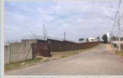
Foto 2: Muro de fechamento do núcleo Alameda Itatuba, sem calçada delimitada nem passeio para pedestres.
