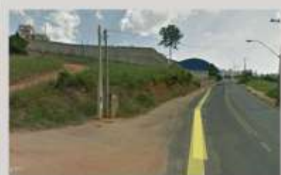
Foto 2: Vista do muro de fechamento pela Rua João Bissoto Filho, em confrontação de 10m que não possui passeio para pedestres.
