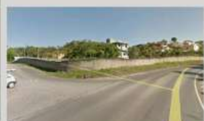
Foto 2: Muro de fechamento na Estrada do Jequitibá, sem passeio para Opedestres.
