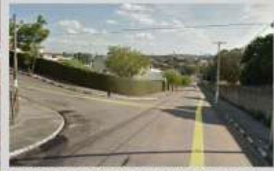
Foto 2: Muro de fechamento do núcleo à esq. com passeio de pedestres pavimentado. À direita, muro do hotel Fonte Sta Tereza.
