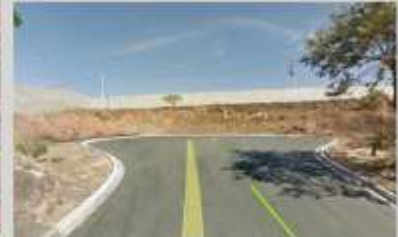
Foto 2: Muro do núcleo em Rua do Jd. São Luiz terminada em cul-de-sac impedindo a continuidade dela.
