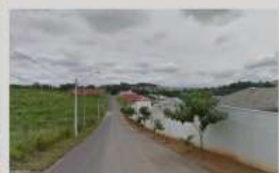
Foto 2: Muro de Fechamento à direita com ausência de passeio para pedestres.
