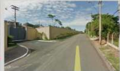
Foto 2: Entrada de serviço do núcleo e muro de fechamento.
