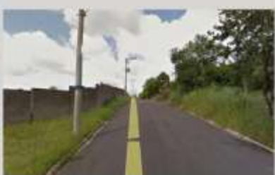
Foto 2: Muro de fechamento e ausência de passeio para pedestres na Rua João Ubialo.
