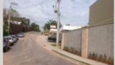
Foto 2: Muro de fechamento em alvenaria, com passeio de pedestres
