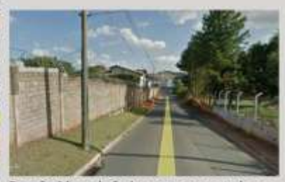
Foto 2: Muro de fechamento na testada com a Rua Agnelo Cunha; ausência de passeio para pedestres.
