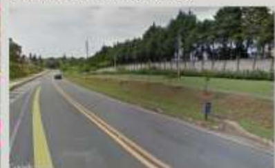
Foto 2: Muro de fechamento sem passeio para pedestres.
