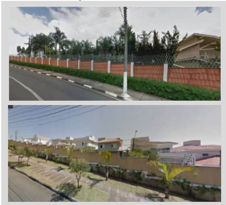
Figura 38: Muros do Setor C
