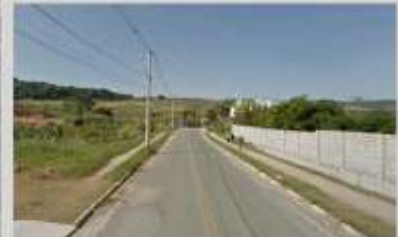
Foto 2: Muro de fechamento à direita com passeio pavimentado de pedestres. À esquerda, a APP do Ribeirão Pinheiros.
