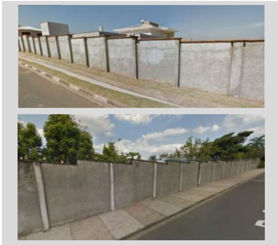
Figura 39: Muros dos Setores A, B e D
