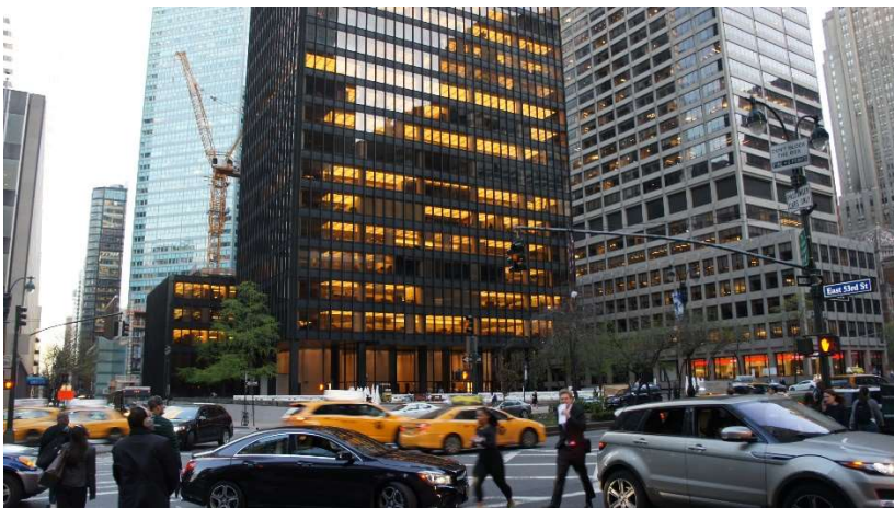
Figura 79 – Edifício Seagram, Mies van der Rohe. FONTE: Acervo do autor.
