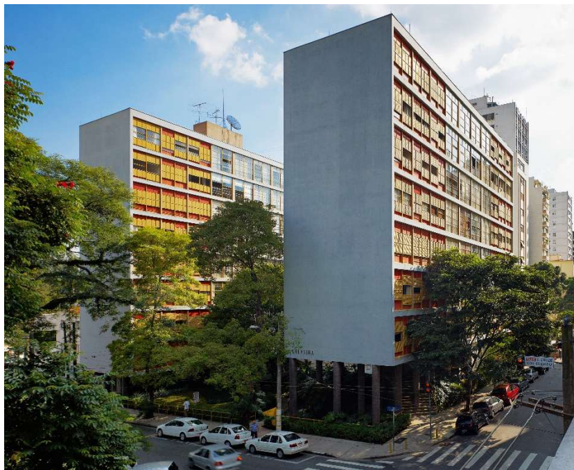
Figura 23 – Edifício Louveira. Vilanova Artigas, 1946. FONTE: Nelson Kon.
