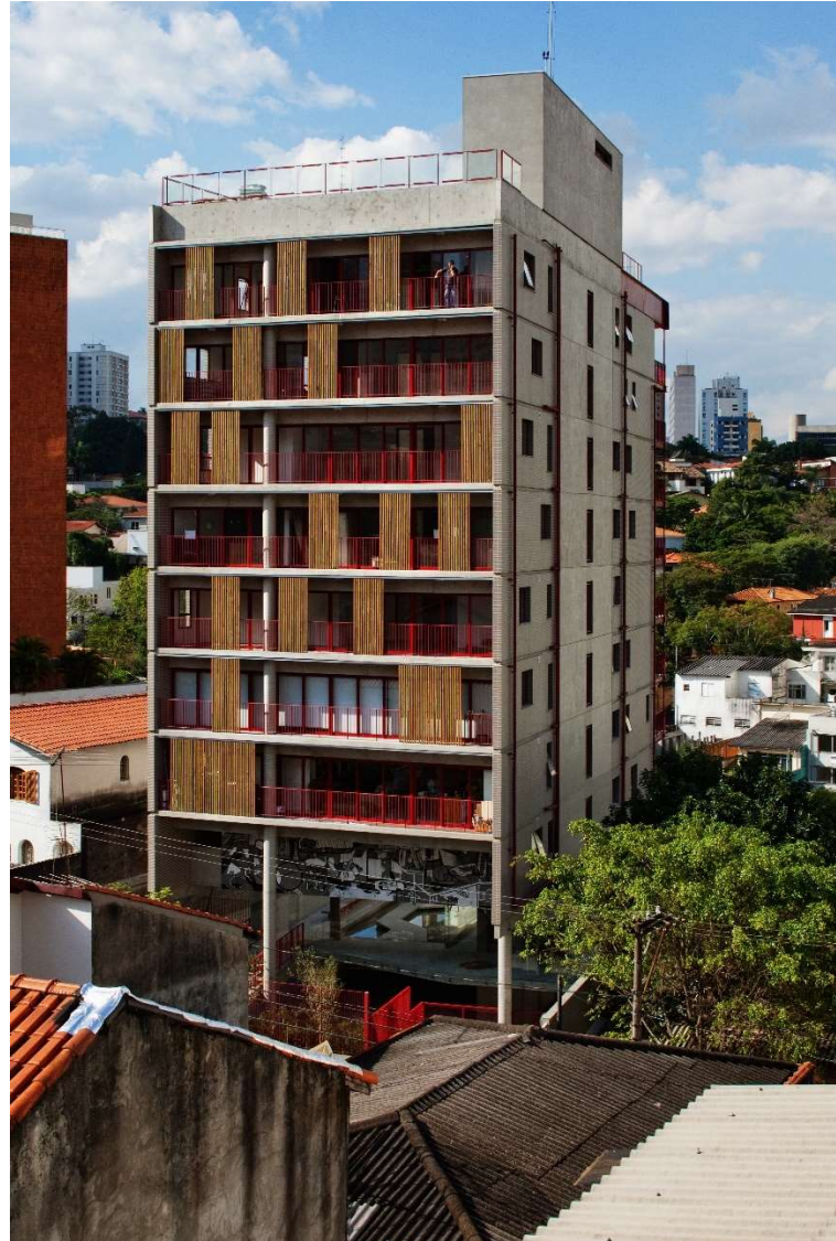
Figura 92 – Simpatia 236. Construído. Grupo SP. FONTE: Nelson Kon.
