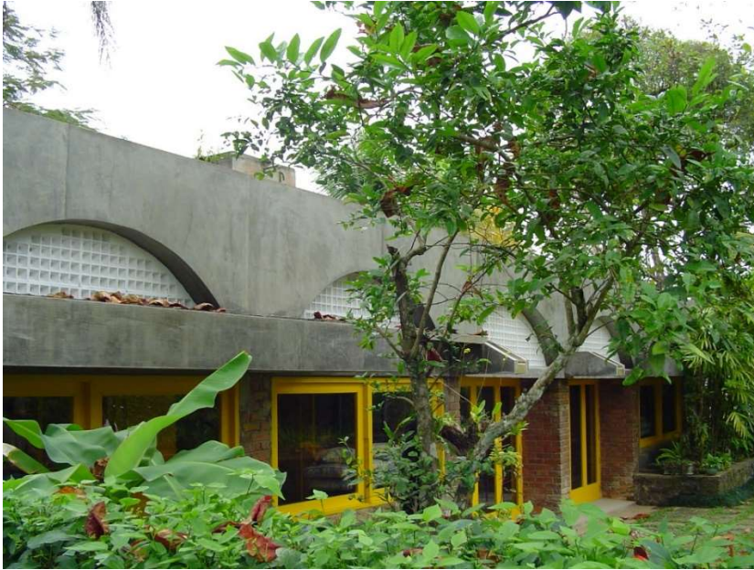
Figura 44 – Residência Simão Fausto. Arquitetura Nova, 1961. FONTE: André Scarpa.
