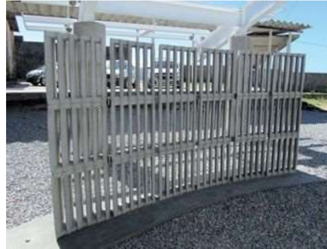
Figura 103 – Mock Up das paredes. Arena do Morro. Herzog & de Meuron, 2014. FONTE: HERZOG & DE MEURON, 2015, p. 20.
