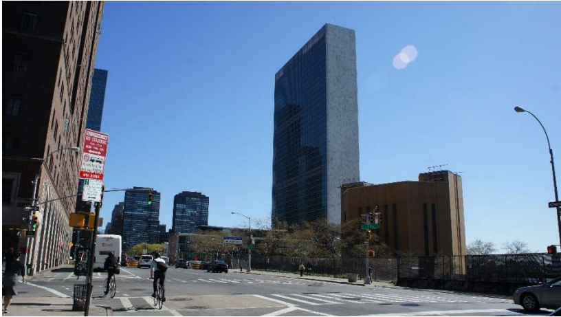
Figura 78 – Sede da ONU em Nova York. FONTE: Acervo do Autor.
