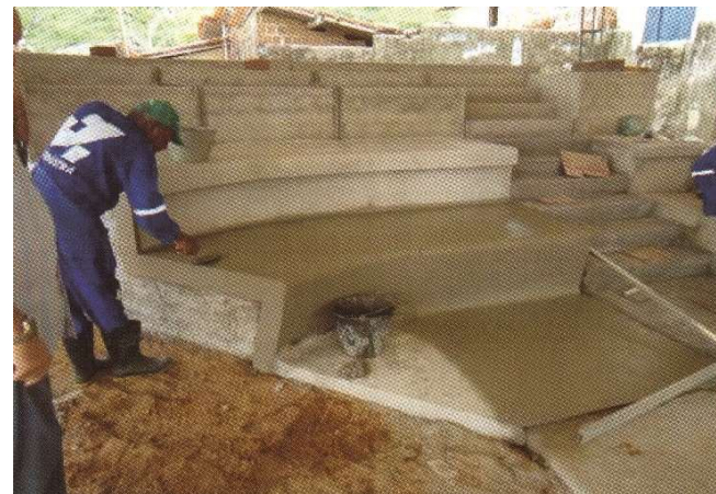
Figura 104 – Mock Up do piso. Arena do Morro. Herzog & de Meuron, 2014. FONTE: HERZOG & DE MEURON, 2015, p. 16.
