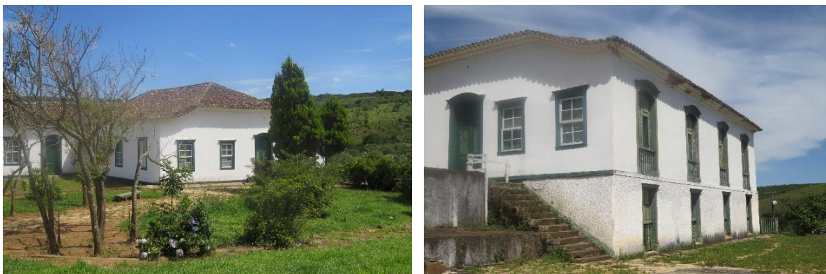
Figura 76: Fazenda Favacho em Cruzília. Caminho de chegada à fazenda, voltado para a fachada principal, de apenas um pavimento. À direita, vista da fachada lateral com porão, uma solução tradicional para as edificações implantadas a meia encosta. A fazenda apresenta linhas tipicamente portuguesas, com telhados com beira sobre beira, paredes brancas e portas e janelas pintadas de cores escuras, um fato que se deve à dificuldade de encontrar-se pigmentos de tonalidades variadas. É possível verificar as alterações feitas no corpo principal por meio das janelas quadrangulares (fachada principal), típicas do século XIX, ao invés do uso da janela curva “canga de boi” (fachada lateral), típicas do século XVIII. Fonte: Fotos de Larissa S. Pereira. Acervo da pesquisa (2014).
