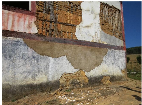
Figura 92: À esquerda, fachada principal da sede com janelas ordenadas e alinhadas, caráter simples e austero e portas e janelas muito altas, conferindo força, monumentalidade e, ao mesmo tempo, simplicidade à edificação. À direita, detalhe da construção com base de pedra e paredes de pau a pique. Fonte: Fotos de Larissa S. Pereira. Acervo da pesquisa (2016).
