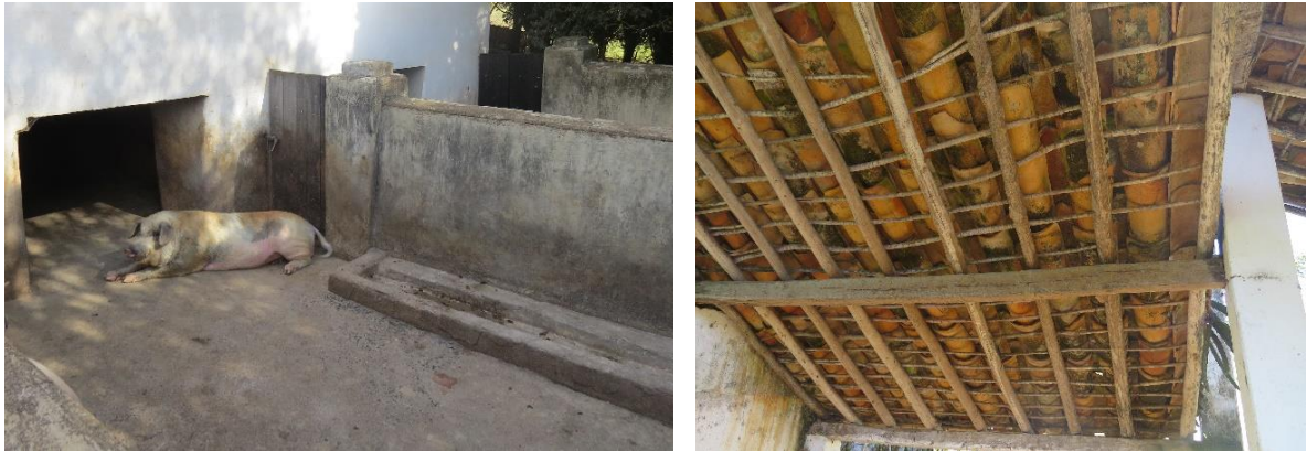
Figura 42: À esquerda, chiqueiro na Fazenda João Cota, município de São Thomé das Letras. À direita, telhado de chiqueiro com telhas de cerâmica e paus roliços, Fazenda Serra das Bicas, município de Carrancas. Fonte: Foto de Larissa S. Pereira. Acervo da pesquisa (2016).
