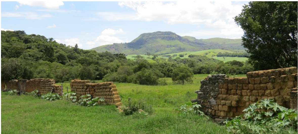
Figura 82: Fazenda Traituba. Antigo muro de adobe cercando a propriedade. Ao fundo, a Serra da Traituba, que emprestou seu nome à fazenda. Fonte: Foto de Larissa S. Pereira. Acervo da pesquisa (2014).
