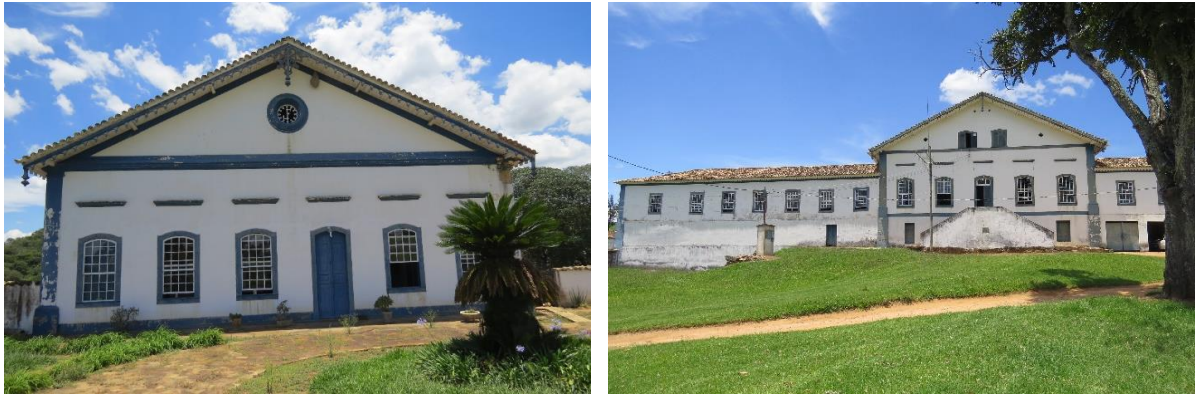
Figura 81: À esquerda, caminho que leva à entrada principal e fachada com telhado adornado por lambrequins. À direita, fachada posterior com porões e escada de acesso, demonstrando a construção em meia encosta. No alto, duas janelas que restaram da reforma feita em 1902, quando foi demolido o andar superior com mirante. A existência deste segundo pavimento demonstra a imponência da fazenda no início do século XIX, uma vez que este tipo de configuração não era nada comum em edificações rurais do período. Fonte: Foto de Larissa S. Pereira. Acervo da pesquisa (2014).
