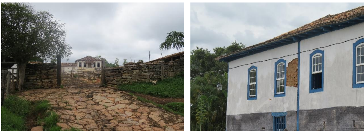
Figura 85: À esquerda, Fazenda Grão Mogol cuja sede fica implantada próxima ao Ribeirão dos Ferreira (primeiros proprietários). Observa-se a fachada principal da sede com calçamento e muros de pedra e o curral localizado antes da entrada de casa. Segundo CRUZ (2008), a fazenda Grão Mogol exibe uma arquitetura simples, de composições claras e definidas. As janelas da casa são de vergas arqueadas e não possuem caixilhos, apenas as folhas de calha interiores. Estas e os muros de pedra que cercam a sede e o curral – localizado na frente da edificação, atestam que a construção é de meados do século XVIII. À direita, a Fazenda Engenho, atualmente com função de hotel fazenda. Apesar das adaptações sofridas para receber o novo uso, o corpo principal da edificação ainda apresenta as paredes de pau a pique originais. Fonte: Fotos de Larissa S. Pereira. Acervo da pesquisa (2015).
