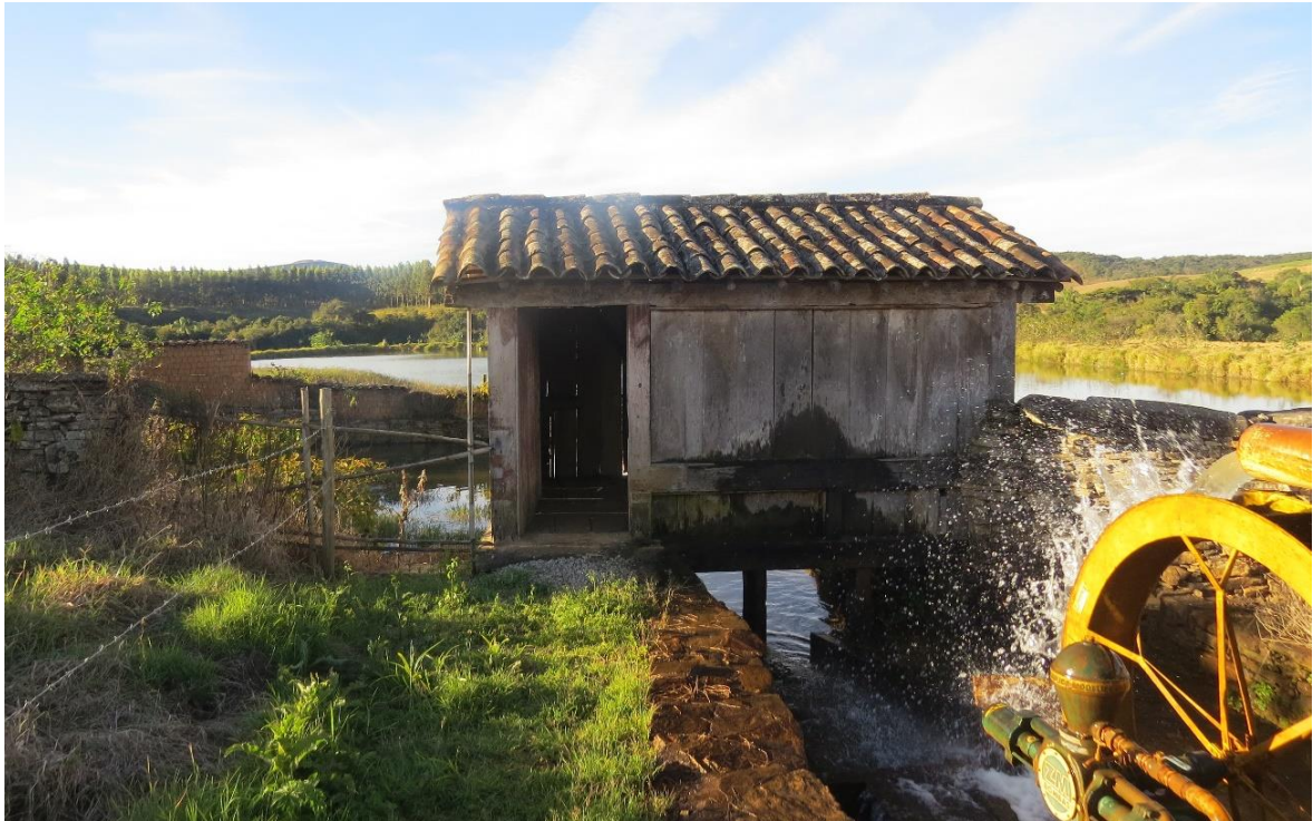
Figura 40: Fazenda Bela Cruz, município de Cruzília. Antigo moinho e roda d'água, agora, mecanizada. À esquerda, podemos observar o muro de pedras e, mais ao fundo, o muro de tijolos de adobe. Também à esquerda, ao fundo, é possível verificar a plantação de eucaliptos que começa a fazer parte da paisagem. Fonte: Foto de Larissa S. Pereira. Acervo da pesquisa (2016).
