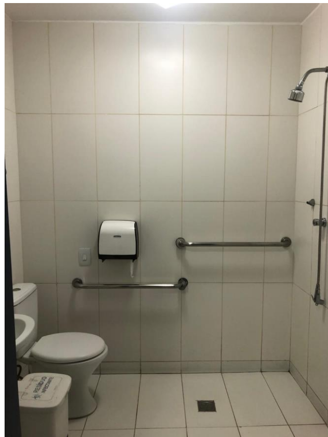
Figura 52 - Banheiro quarto de internação 16 Hospital Samaritano de Campinas – Fonte: Acervo da autora
