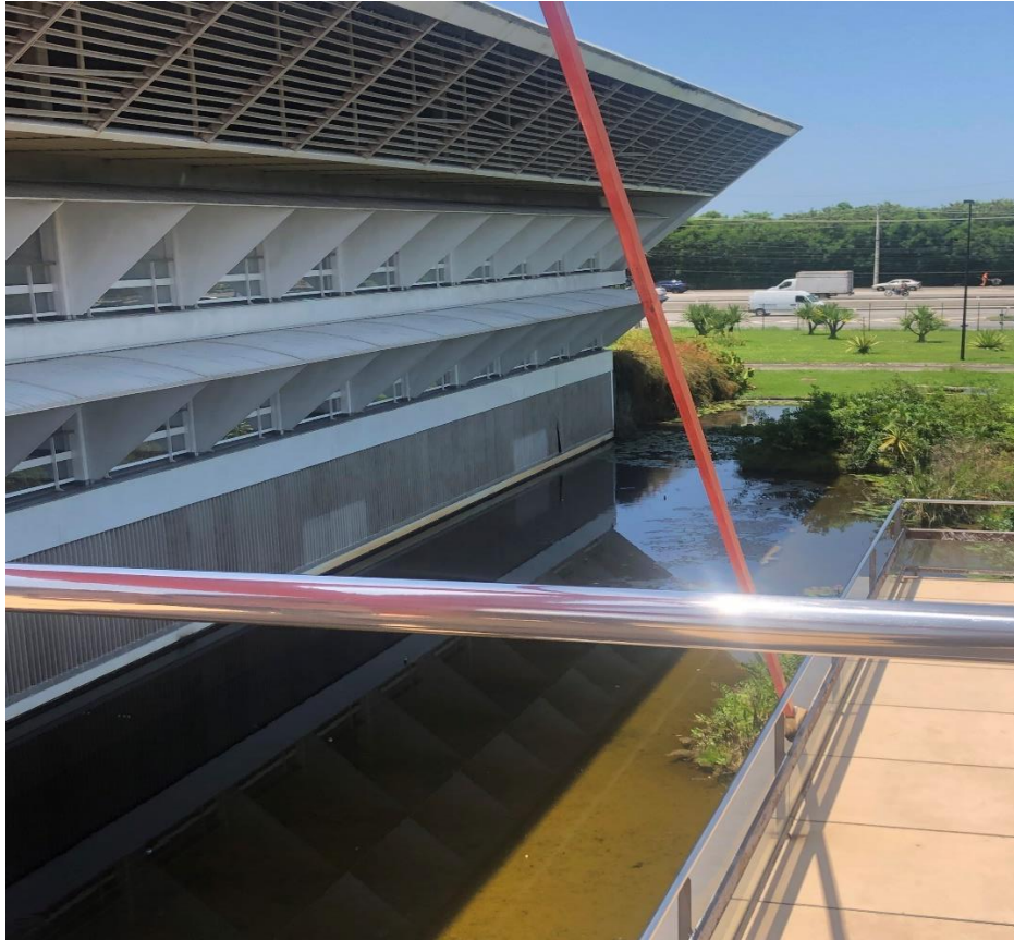
Figura 29 - Vista externa dos quartos de repouso e o Solário- hospital Sarah do Rio de Janeiro (Acervo da autora, 2020)
