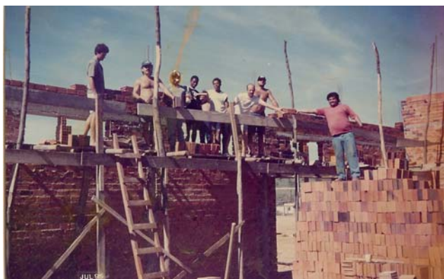
Mutirão de construção do salão comunitário Fonte: acervo Miguel Arcanjo, 1995
