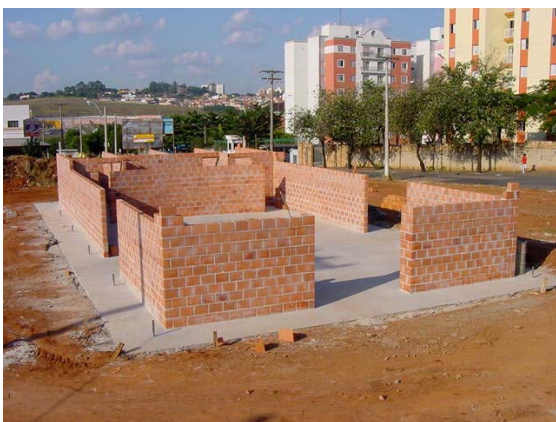
Construção do salão comunitário
