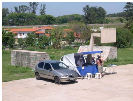
Ocupação após o abandono da obra. 2005
