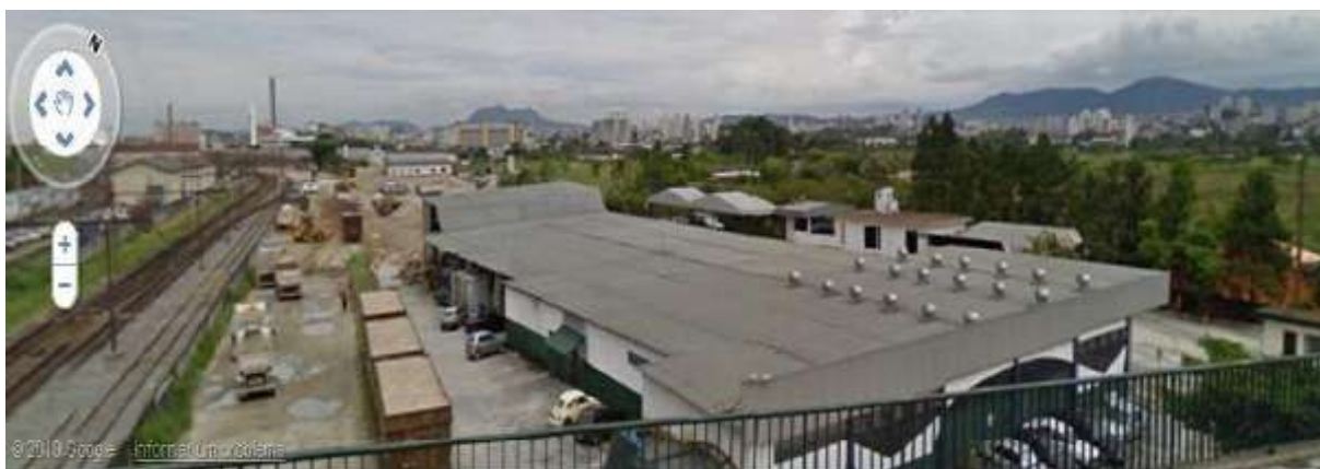
Figura 23. Linha férrea e galpões industriais na área da OU Água Branca
