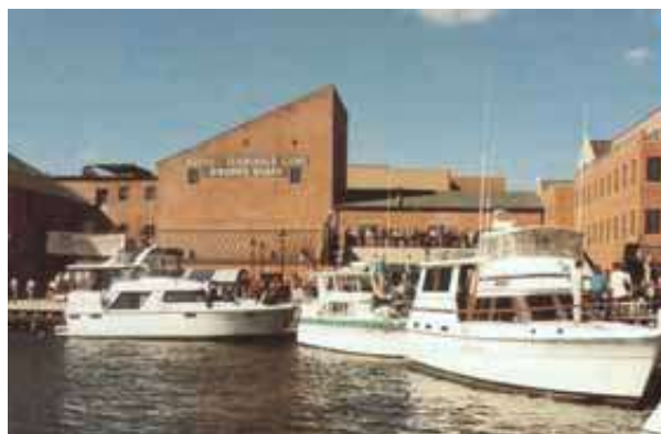
Figura 7. Área revitalizada de Fells Point, Baltimore, mostrando as edificações novas integradas às antigas e o pier público para barcos de passeio e parada do water-taxi . Projeto urbano: Vicente del Rio. Fonte: Del Rio, 2007
