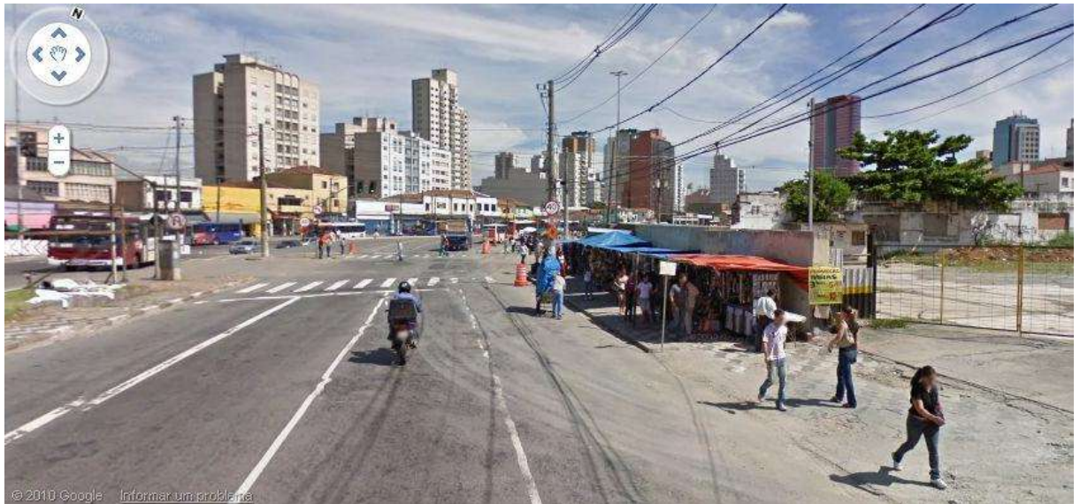
Figura 19. Situação atual da região do Largo da Batata
