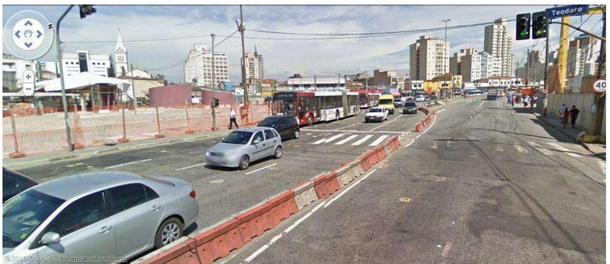
Figura 18. Situação atual da região do Largo da Batata
