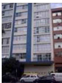
Instalação do Departamento Jurídico Fiscal (DEPATRI) no Centro
