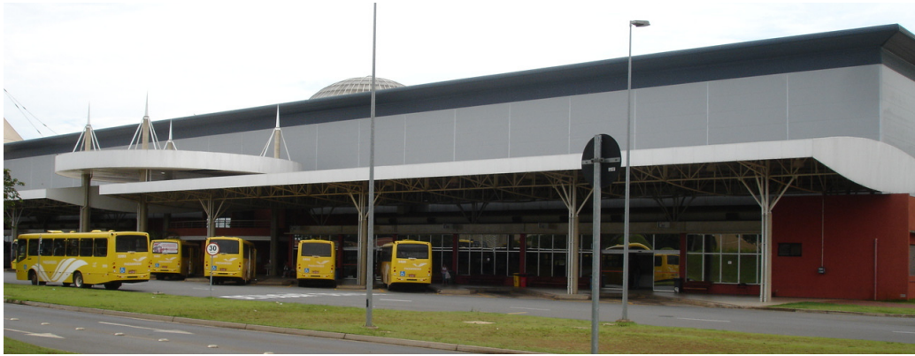
Figura 32. Foto da fachada da Rodoviária-Shopping.
