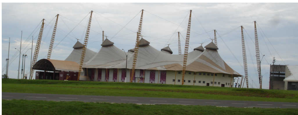
Figura 30. Foto do Pavilhão de Eventos do Complexo Cultural.
