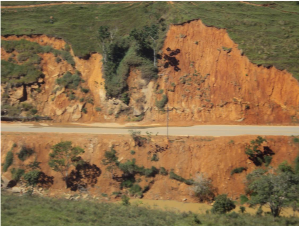
Figura 14 – Trecho de deslizamento de terra em um dos acessos à São Luiz do Paraitinga, foto de janeiro de 2010. Nota-se na foto a superfície acima do barranco com vegetação rasteira, usada para a atividade pecuária que, sem a presença de vegetação, é prejudicial ao solo, diminuindo sua permeabilidade e resistência. Fonte: Relatório Técnico do DAAE. Disponível em: http://www.sobrade.com.br/Apresentacoes%20seminario/Apresenta%C3%A7%C3%A3o%20-Marli%20Reis%20-%20DAAE.pdf Acesso em: 06/05/2013.
