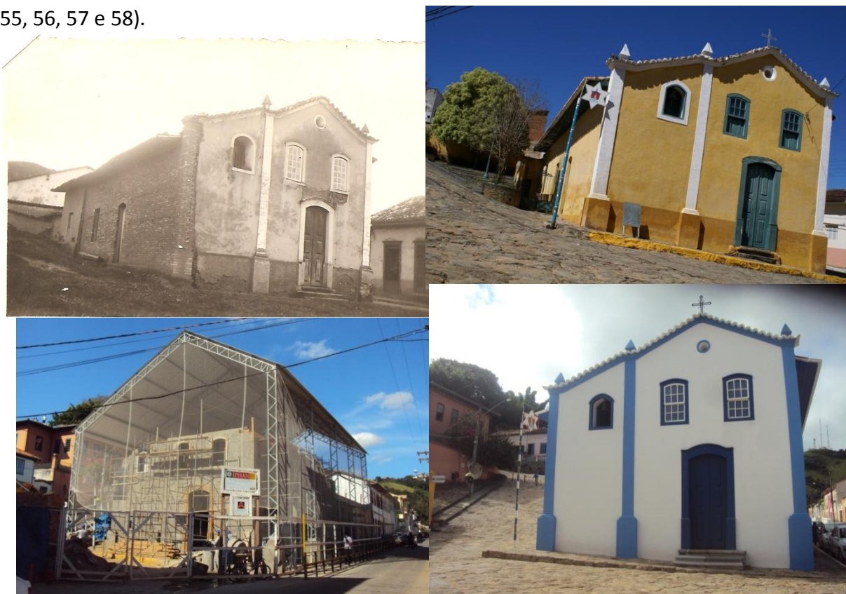
Figuras 55, 56, 57 e 58 – Capela de Nossa Senhora das Mercês em 4 momentos: em foto antiga (esq. em cima); poucos anos antes da enchente de 2010 (dir. em cima); durante o trabalho de restauro (esq. em baixo); e após o processo de restauro em 2011 (dir. em baixo). Fotos disponíveis em: http://www.saoluizdoparaitinga.sp.gov.br/site/patrimonio-arquitetonico/ Acesso em: 06/05/2013.
