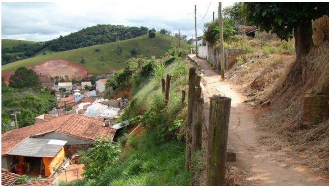
Figura 27. Área de circulação em situação de risco identificada pelo IPT em vistoria na cidade. Fonte: Relatório Técnico do IPT, disponível em: http://www.saoluizdoparaitinga.sp.gov.br/site/a-cidade/planejamento-ceresta/parceiros-da-reconstrucao/ Acesso em: 06/05/2013.
