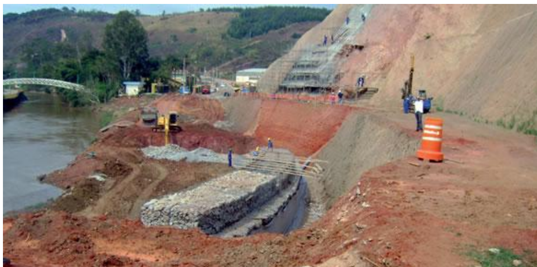
Figura 24 – Execução de muros de gabião acompanhando o rio. Fonte: Relatório Técnico do DAEE, disponível em: http://www.saoluzdoparaitinga.sp.gov.br/site/a-cidade/planejamento-ceresta/parceiros-da-reconstrucao/ Acesso em: 06/05/2013.
