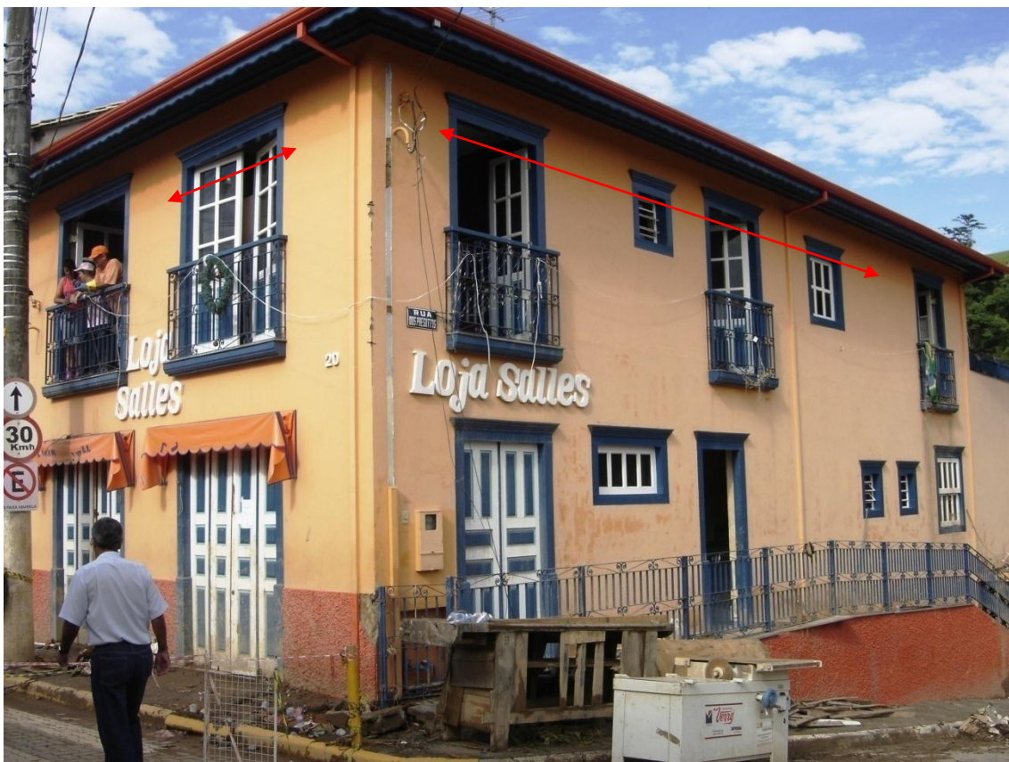
Figura 18 – Sobrado próximo à Praça Oswaldo Cruz em que é possível ver na parede a mancha (destaque em vermelho) provocada pelo Rio Paraitinga. Fonte: Levantamento próprio, janeiro de 2010.
