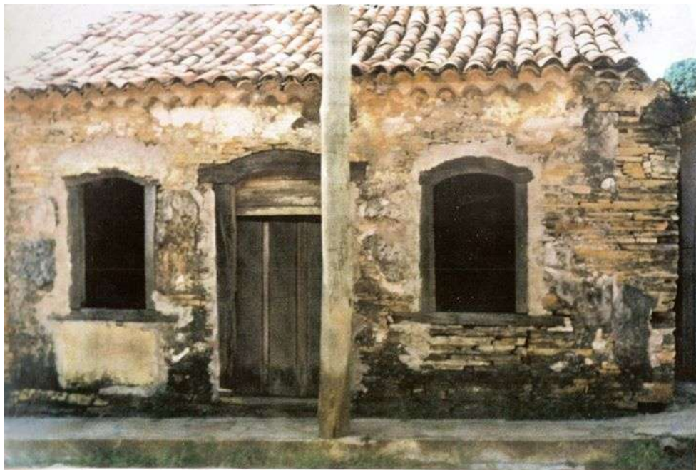
Figura 25 Uma das primeiras casas construídas da Cachoeira de Cima, já demolida.
