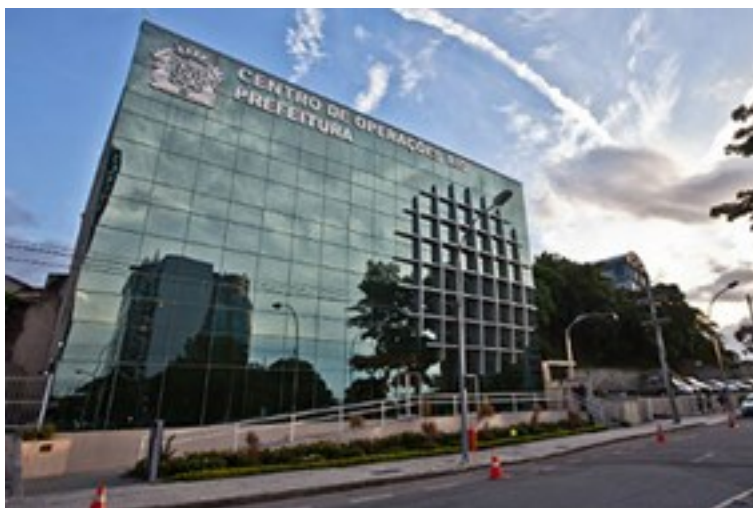
Figura 4 - Prédio do COR
