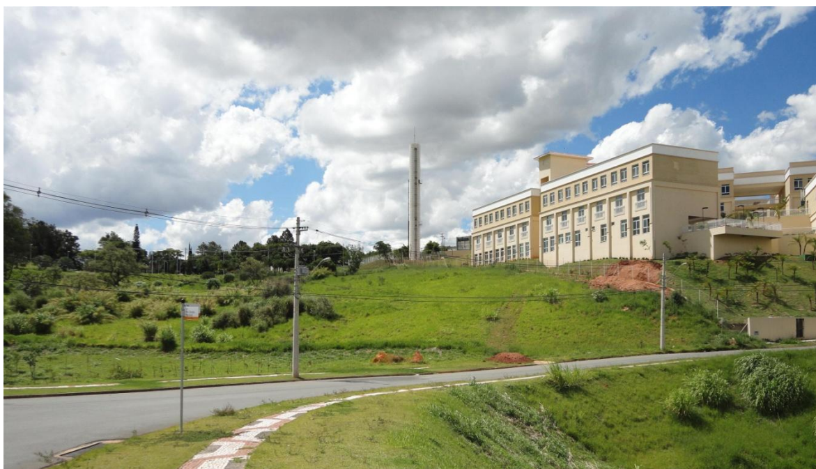
Figura 52 - Área institucional 1 do loteamento Ville Sainte Helene vista desde a rua 3. A dificuldade de acesso em função da topografia e da pequena testada é evidente. Fonte: Elaboração Própria.
