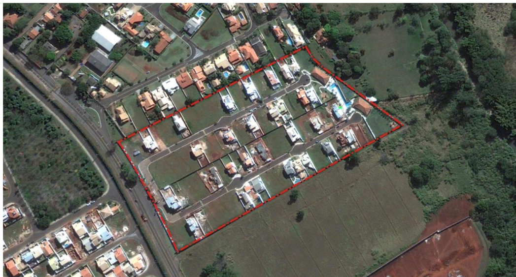
Figura 13 - Condomínio Espaço Verde, no distrito de Barão Geraldo. Fonte: Google Earth. Apesar de se tratar de um condomínio horizontal, e não de um loteamento, é possível perceber que o produto imobiliário real é o lote livre de edificações.
