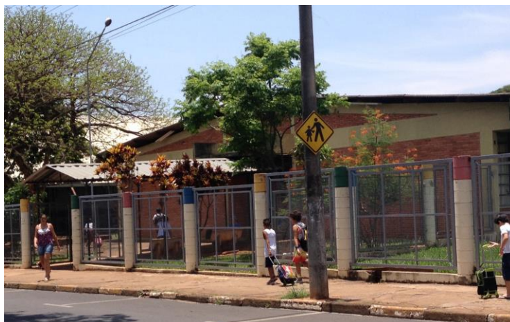
Figura 45. Registro fotográfico da fachada da atual Escola Francisco Cardona.
