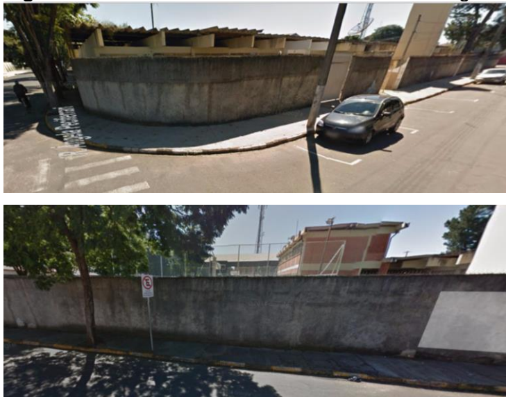
Figura 42. Fachadas da Escola José Amaro Rodrigues.
