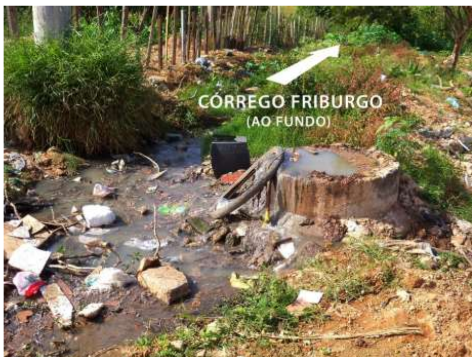
Figura 49: Esgoto a céu aberto, localizado sobre o espaço destinado ao Pq. Linear do Córrego Friburgo. (Fonte: Angélica Dayane S. O. Lima – Julho de 2015)
