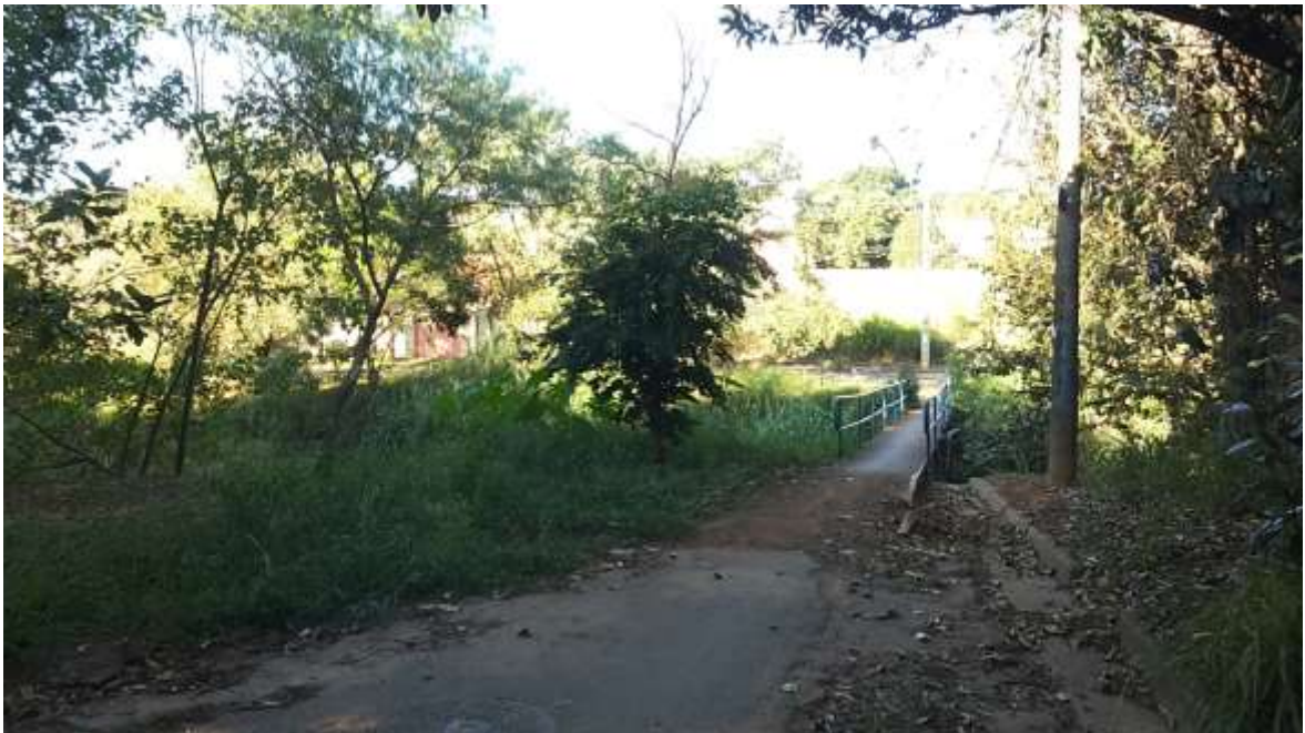
Figura 25: Parque Linear do Ribeirão das Pedras - Ponte sobre Ribeirão das Pedras, Rua Osvaldo Antunes Vasconcelos. (Fonte: Angélica Dayane S. O. Lima – Julho de 2015)
