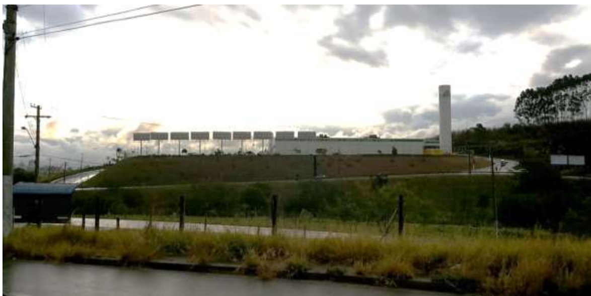
Figura 61: Aspectos da macrozona 8. Loja da Leroy Merlin. (Fonte: Angélica Dayane S. O. Lima – Julho de 2015)
