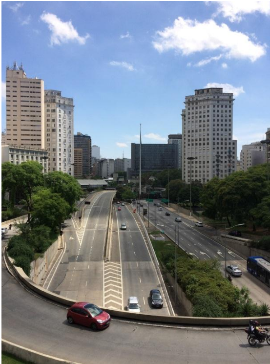
Figura 139. Vista do Viaduto do Chá em direção à Praça das Bandeiras, antigo Largo da Memória, totalmente desconectado para a travessia em nível pelo pedestre. [Acervo da autora, 2018].
