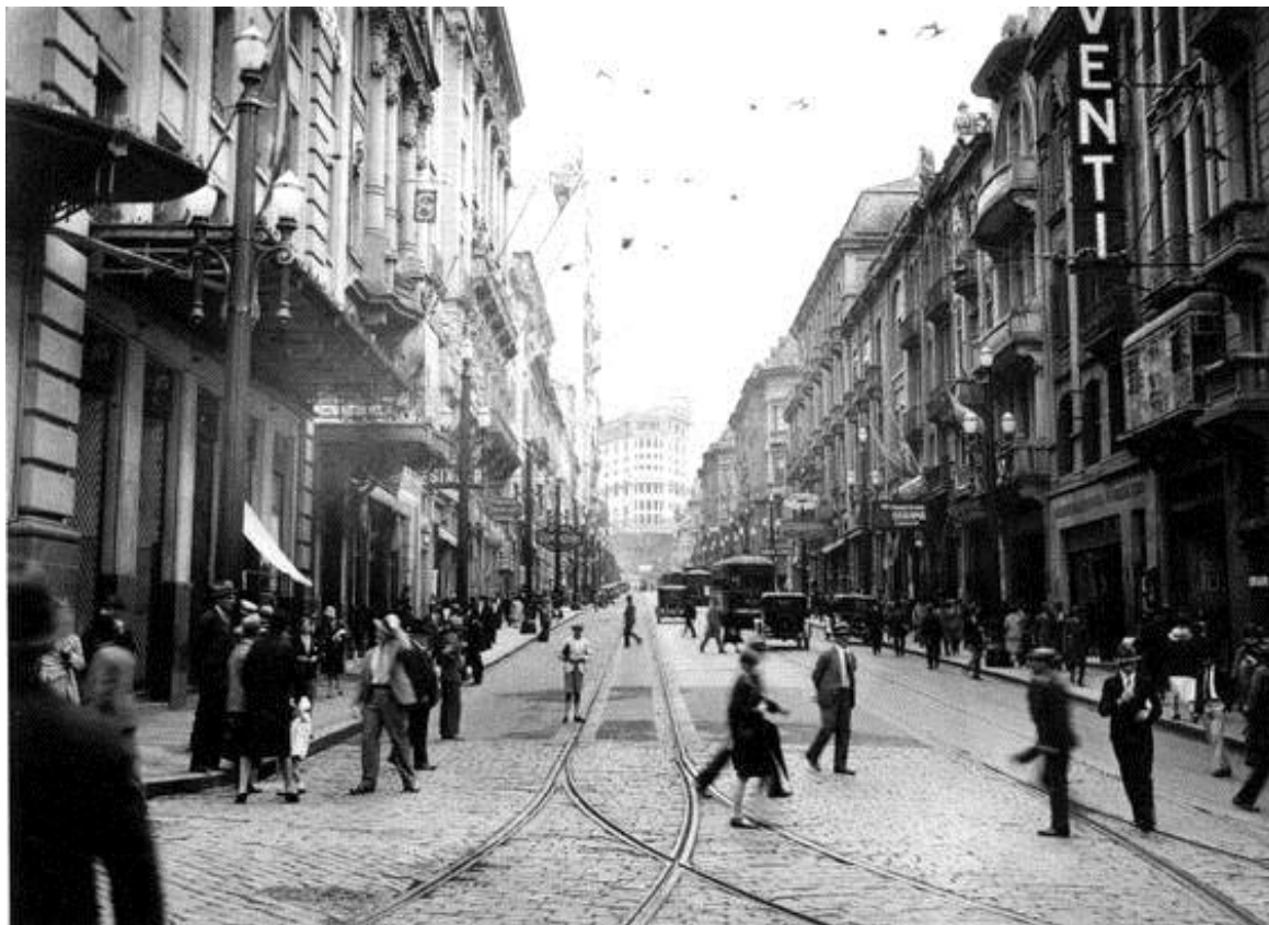
Figura 86. Edifício Saldanha Marinho na década de 1930. Observa-se o conjunto arquitetônico eclético da Rua Líbero Badaró e o contraste com o Edifício no fim da via. [Disponível em: São Paulo do passado – http://www.hagopgaragem.com ].
