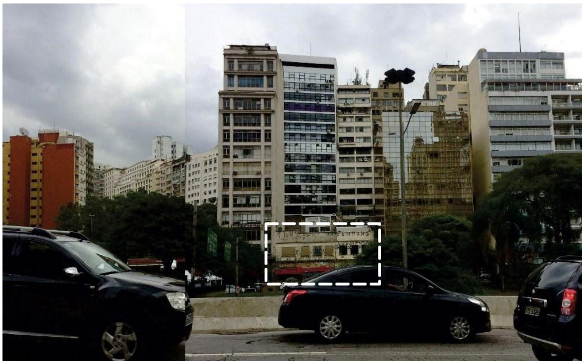
Figura 58. Foto dos edifícios da Rua Formosa, em destaque o único casario remanescente. [Montagem realizada pela autora, foto tirada em 2018].
