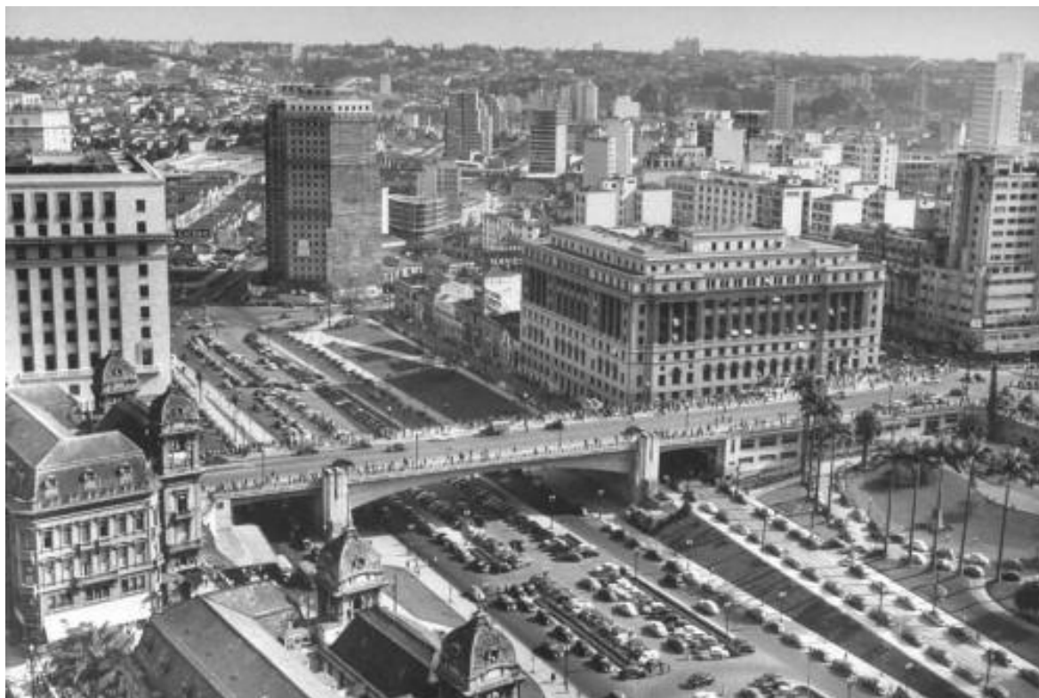
Figura 105. Vista da construção do Edifício Brasil na década de 1950. Foto tomada, provavelmente, do Edifício Martinelli; na parte inferior da imagem, pode-se observar os Palacetes Prates configurando a paisagem eclética do Vale e, ao fundo, a enorme quantidade de arranha-céus presentes no Centro Novo da cidade. [Disponível em: São Paulo do passado – http://www.hagopgaragem.com ].
