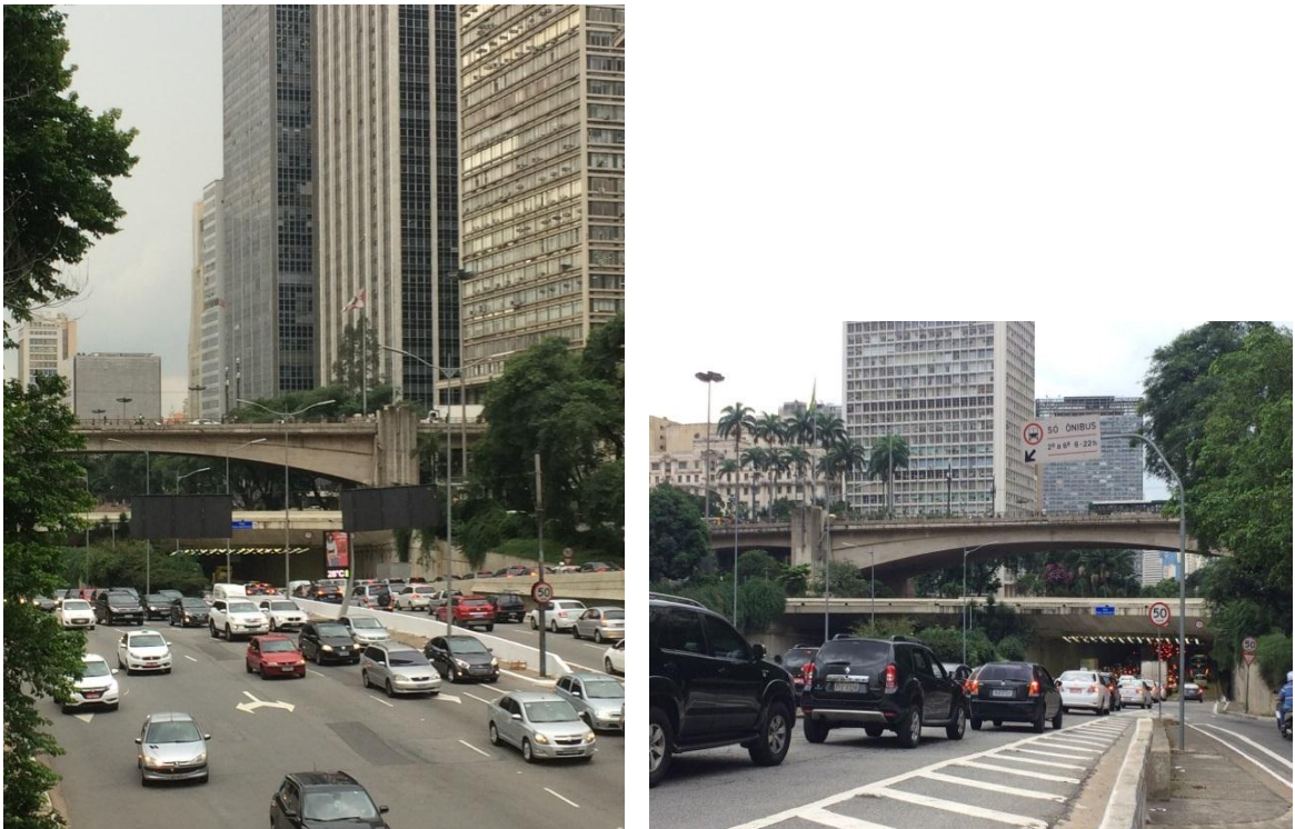
Figura 121. As imagens acima apresentam os níveis intermediários no Vale, sendo eles o túnel, a laje no nível intermediário e acima o Viaduto do Chá (conectando as cotas mais altas da encosta). As tomadas de foto são nas proximidades dos acessos à estação Anhangabaú em direção ao túnel da Avenida Prestes Maia. [Acervo da autora].
