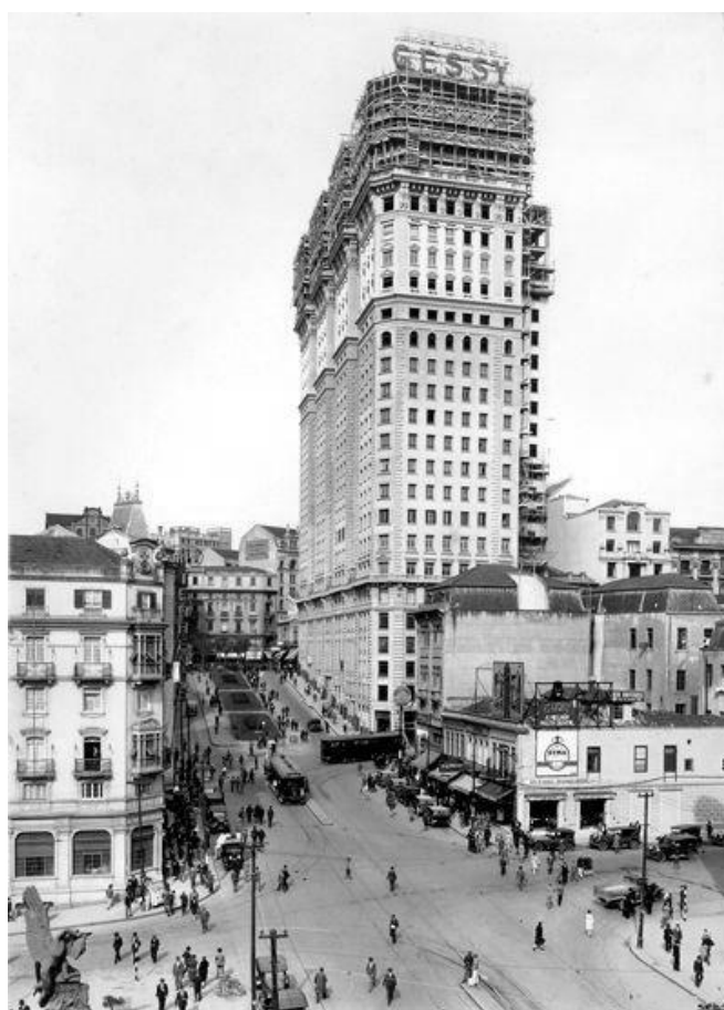
Figura 85. Edifício Martinelli em construção no final da década de 1920 e Avenida São João, já com as obras de alargamento executadas. Podem ser observadas as edificações em primeiro plano, no cruzamento da Avenida São João com a Praça do Correio. Elas permanecem até os dias de hoje na paisagem do Vale. [Disponível em: São Paulo do passado – http://www.hagopgaragem.com ].
