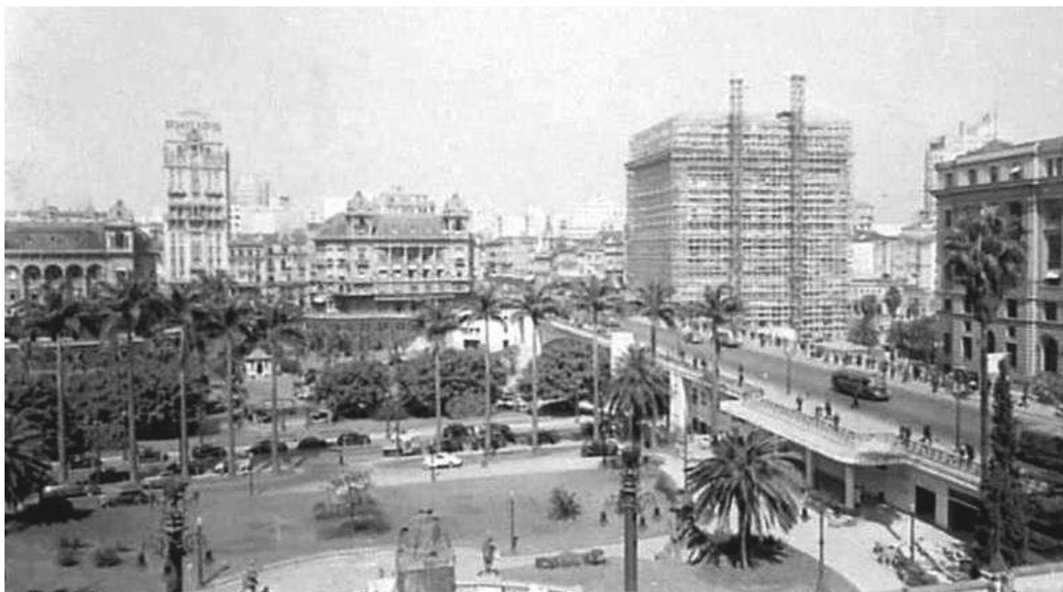
Figura 56. Após a demolição do Hotel o edifício Matarazzo sendo construído. [Disponível em: São Paulo do passado – http://www.hagopgaragem.com ].
