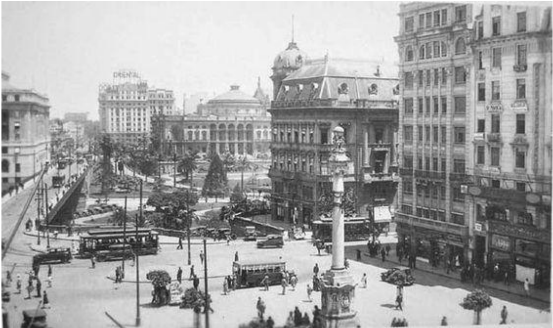
Figura 42. Abertura da Praça do Patriarca, que implicou na demolição parcial do quarteirão. Observar o ‘primitivo’ Viaduto do Chá alinhado à esquerda com a Rua Direita e, ao fundo, a Praça Ramos de Azevedo com seu desenho simétrico, emoldurando o teatro Municipal. [Cartão postal. TOLEDO, 2004, p. 92].
