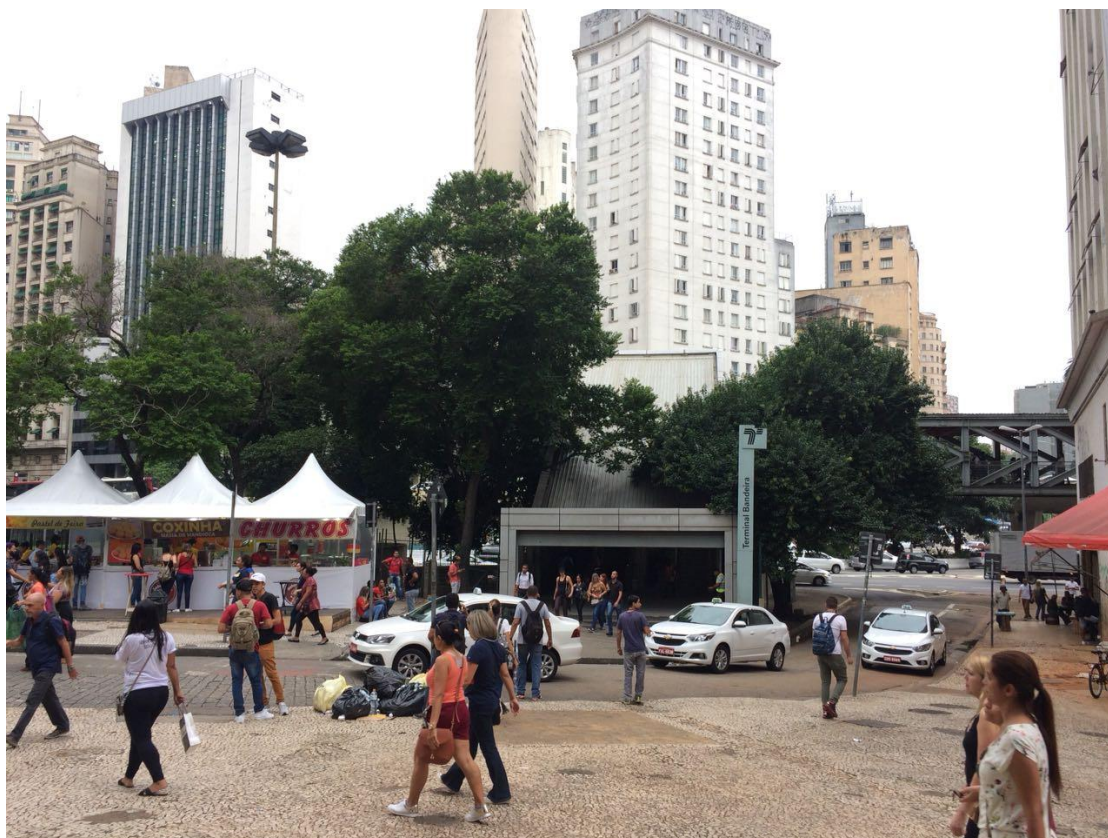
Figura 136. Saída da passarela do Terminal Bandeiras à Rua Formosa. [Acervo da autora].
