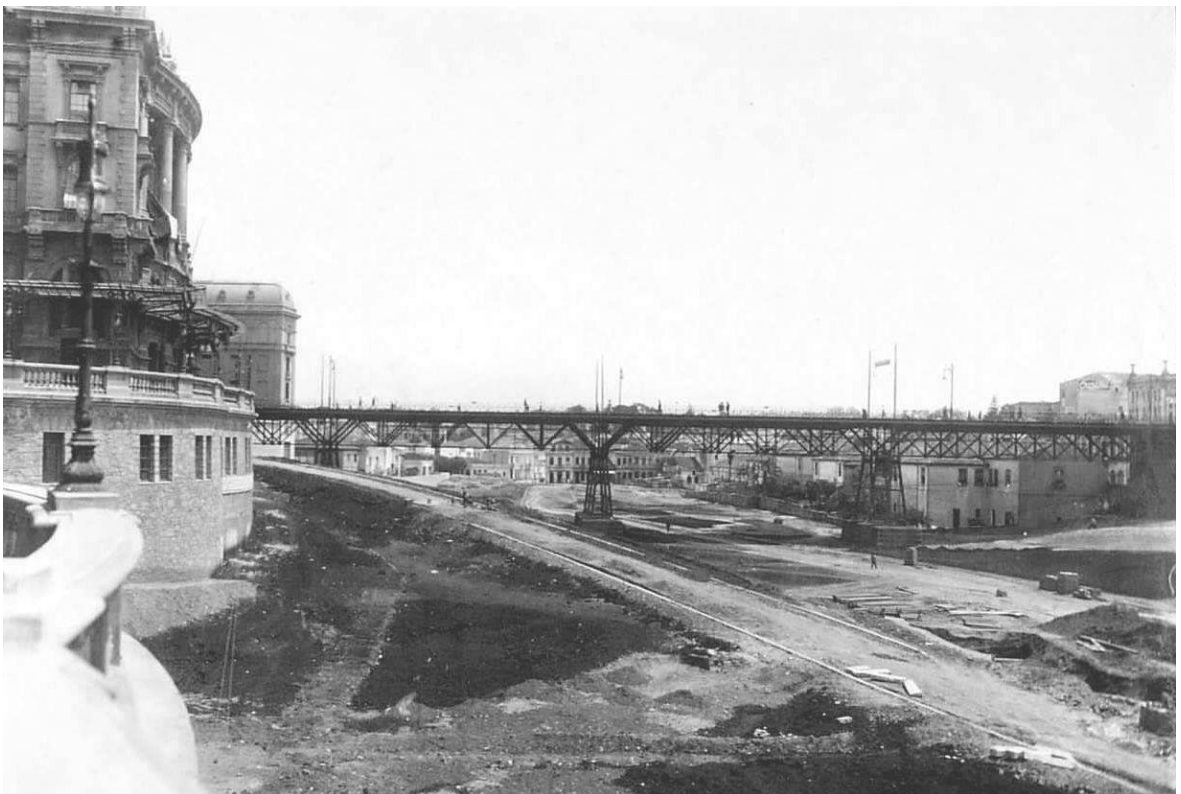
Figura 37. Viaduto do Chá e Parque Anhangabaú em construção. 1916. [Disponível em: Álbum Comparativo da Cidade de São Paulo, 1916, organizado pelo Exm o . Sr. Dr. Washington Luiz Pereira de Souza - http://www.hagopgaragem.com/sp_comparativo3.html ].
