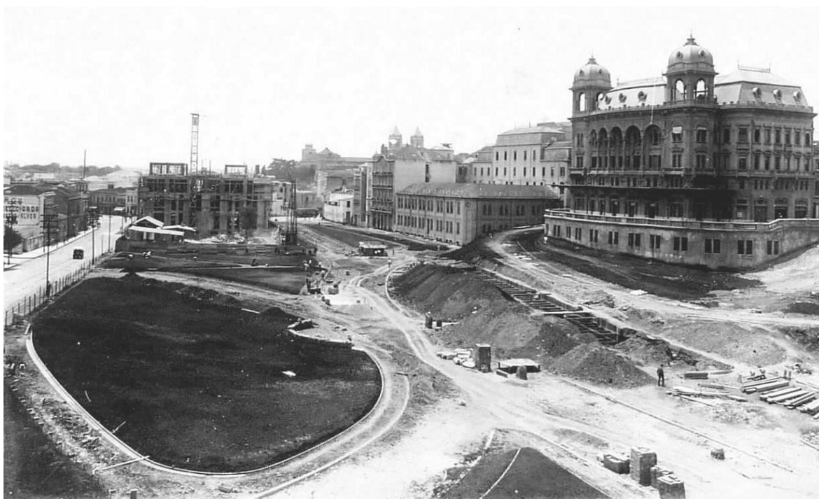
Figura 38. Edifício Prates ou Palácio da Prefeitura e Parque do Anhangabaú em construção. Ao fundo a construção do Edifício da Delegacia Fiscal em frente à Praça do Correio. 1916. [Disponível em: Álbum Comparativo da Cidade de São Paulo, 1916, organizado pelo Exm o . Sr. Dr. Washington Luiz Pereira de Souza – http://www.hagopgaragem.com ].
