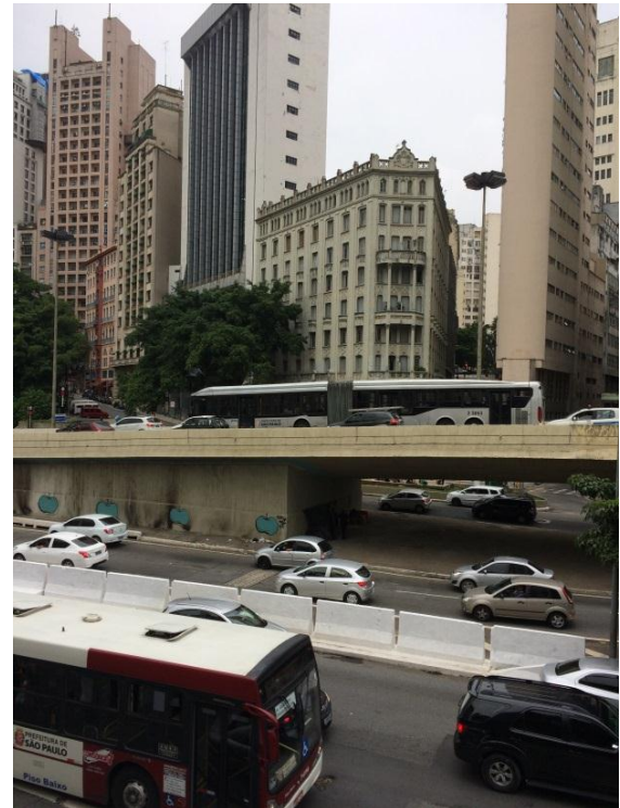
Figura 140. Vista da passarela que liga o Terminal Bandeiras com a Ladeira Largo da Memória, desconexão com os lados da cidade. [Acervo da autora, 2018].
