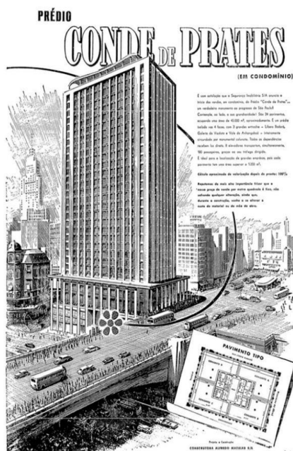
Figura 109. Propaganda do Prédio Prates, verticalização na área central da cidade. [ saopauloantiga.com.br/palacete-prates/ ].
