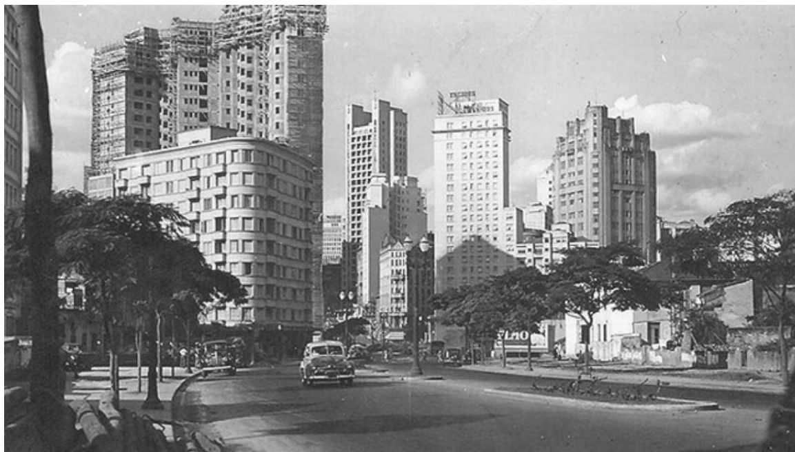
Figura 103. Construção do Edifício Brasilar na década de 1950. Vista da Avenida Anhangabaú. No centro da imagem, pode-se observar o Othon Palace, o Rodhia, o Palácio Riachuelo e o Hotel São Paulo. [Disponível em: São Paulo do passado – http://www.hagopgaragem.com ].
