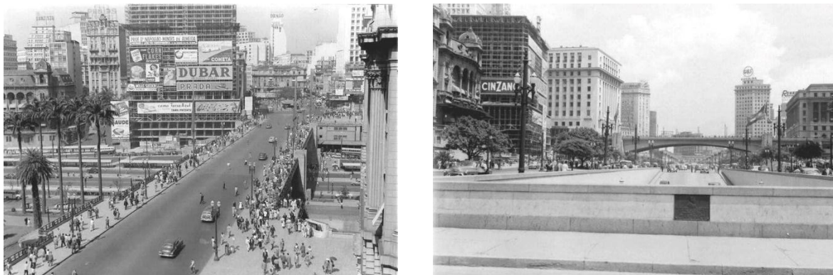
Figura 108. Imagens da construção do Edifício Conde de Prates. [Disponível em: São Paulo do passado – http://www.hagopgaragem.com ].
