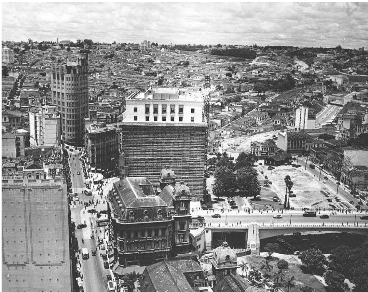
Figura 87. Edifício Conde Matarazzo sendo construído no final da década de 1930. Observar a Avenida Anhangabaú traçada no fundo da imagem e a consolidação do Edifício Saldanha Marinho no final da Rua Líbero Badaró. [Disponível em: São Paulo do passado – http://www.hagopgaragem.com ].
