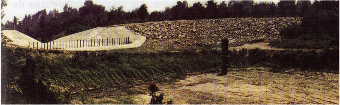
**Figura 30** – Bacia de detenção e controle de (*debris*) detritos (Califórnia). Canholi, 2005.
