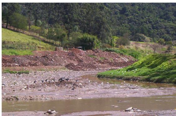
**Figura 67** – Assoreamento do reservatório do Bananal.
