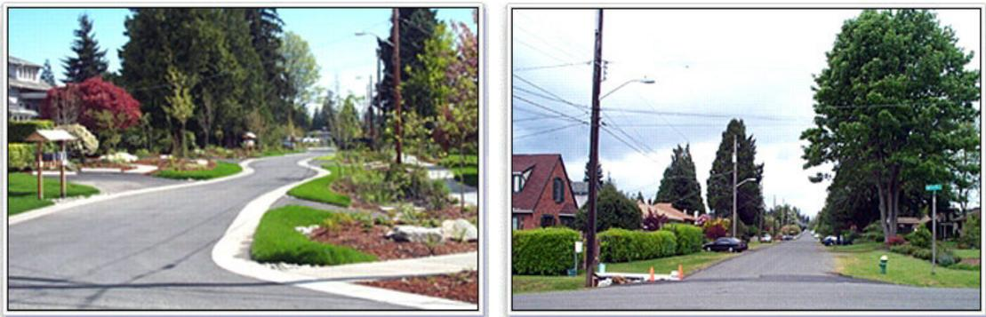
**Figura 10** – Ruas com superfícies de infiltração. Tucci, 2005.
