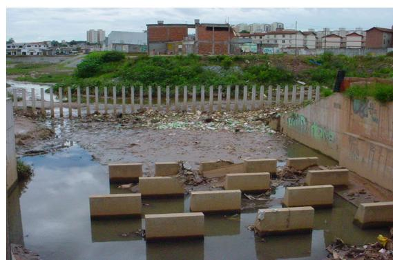
**Figura 68** – Assoreamento do reservatório do Guarau. EPUSP, 2005.
