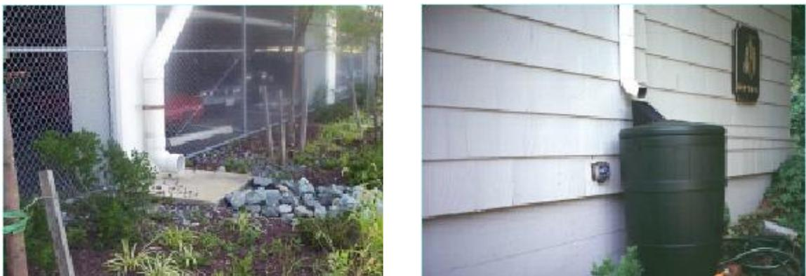
**Figura 17** – Controle de entrada nos telhados com reservatório para posterior uso. Tucci, 2005.
