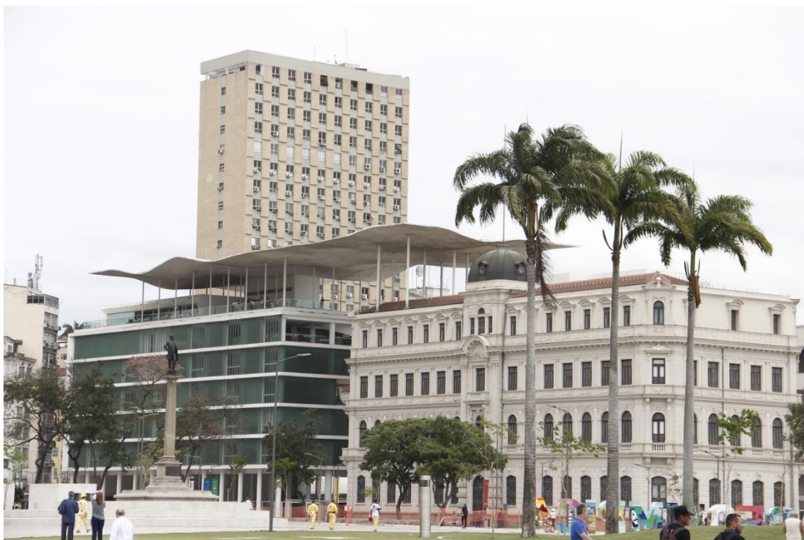
Figura 3. Museu de Arte do Rio (MAR). Fonte: Porto Maravilha. Disponível em: portomaravilha.com.br . Acesso em: 04/08/2020.
