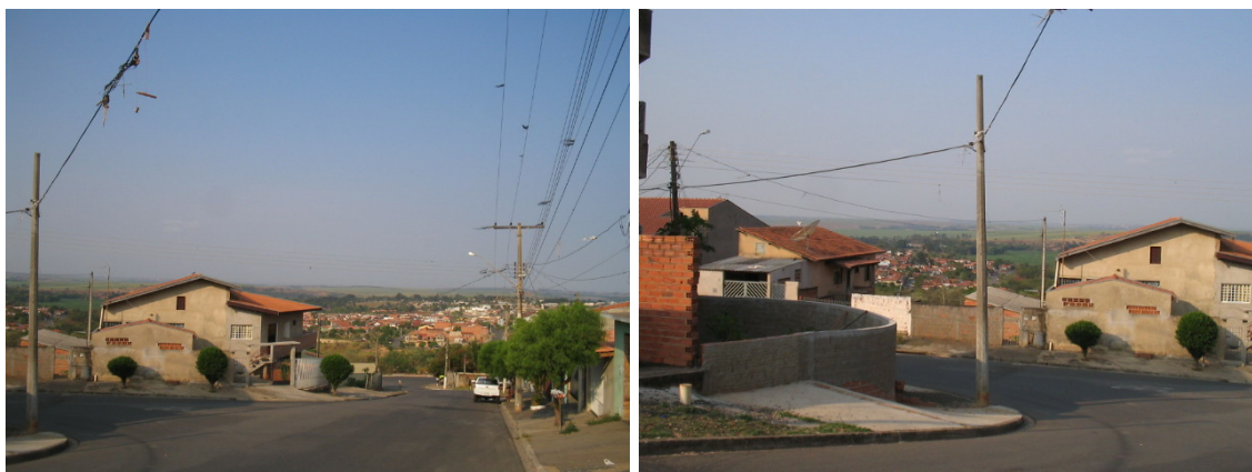
Fotos 27 e 28: Bairros novos, muitas casas com acabamento incompleto e ruas asfaltadas há pouco tempo. Fonte: Tatiane de Aguiar Feliciano (2007)
