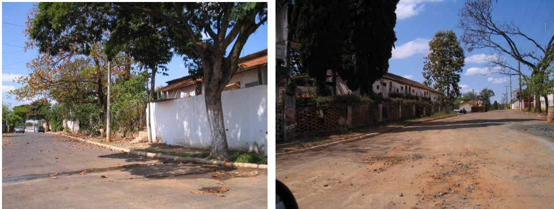
FOTOS 36 e 37: Observa-se as calçadas danificadas, acúmulo de terra sobre o asfalto e o aspecto de abandono. Fonte: Tatiane de Aguiar Feliciano (2008)
