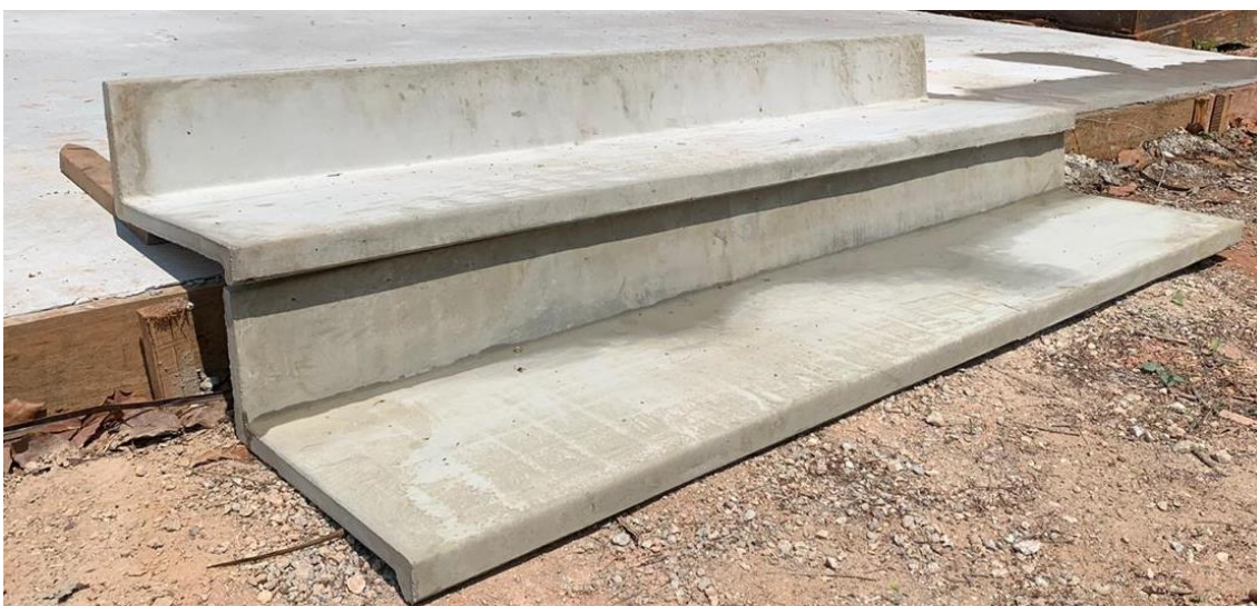
Figura 101 – Peças prontas de degraus em argamassa armada. Fonte: peça e imagem realizadas pelo autor.
