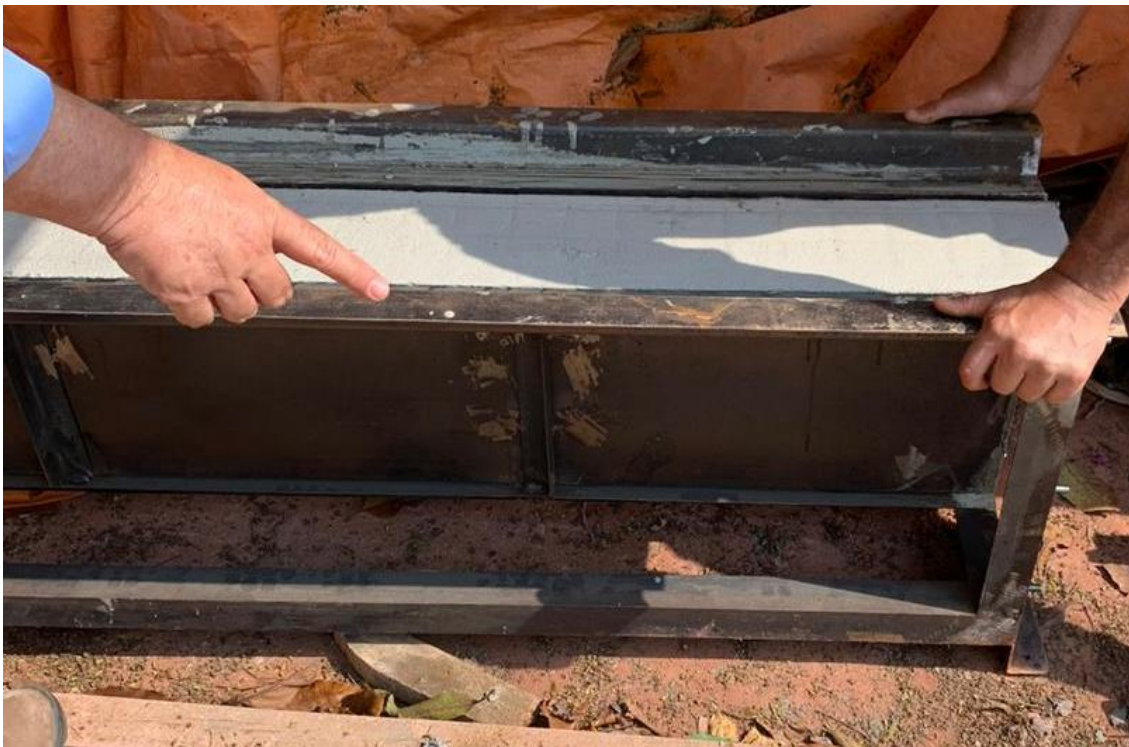
Figura 100 – Processo de desforma de degrau em argamassa armada, a partir de forma metálica. Fonte: peça e imagem realizadas pelo autor.
