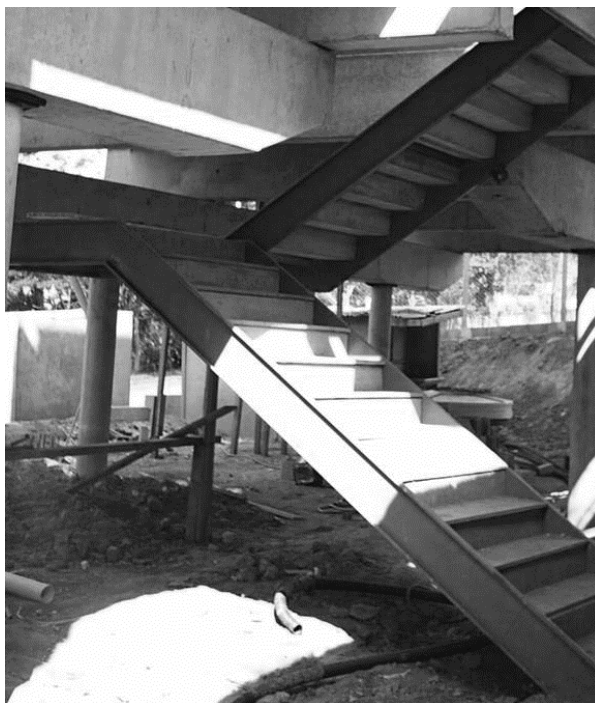
Figura 90 – Elemento de piso/espelho em argamassa armada, para degraus de escadas, associado a perfil metálico como estrutura; é passível de ser transportado manualmente por uma pessoa (20 kg). Fonte: peça e imagem realizadas pelo autor.
