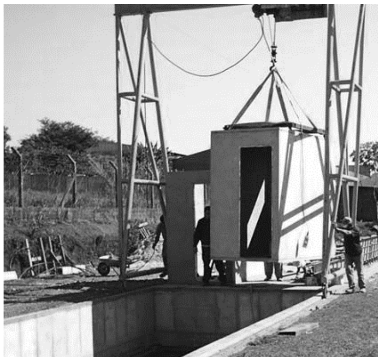
Figura 91 – Cápsula em argamassa armada para utilização como banheiro. Dimensões internas aproximadas: c=2,5m l=1,3 h=2,50m . Peso = 2200kg; passível de montagem com pórtico de pequenas dimensões. Fonte: peça e imagem realizadas pelo autor.
