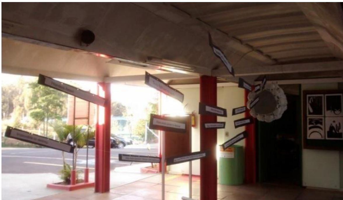
Figura 50 – Vigas e forro no trecho de pátio coberto. Imagem do autor, 2018.
