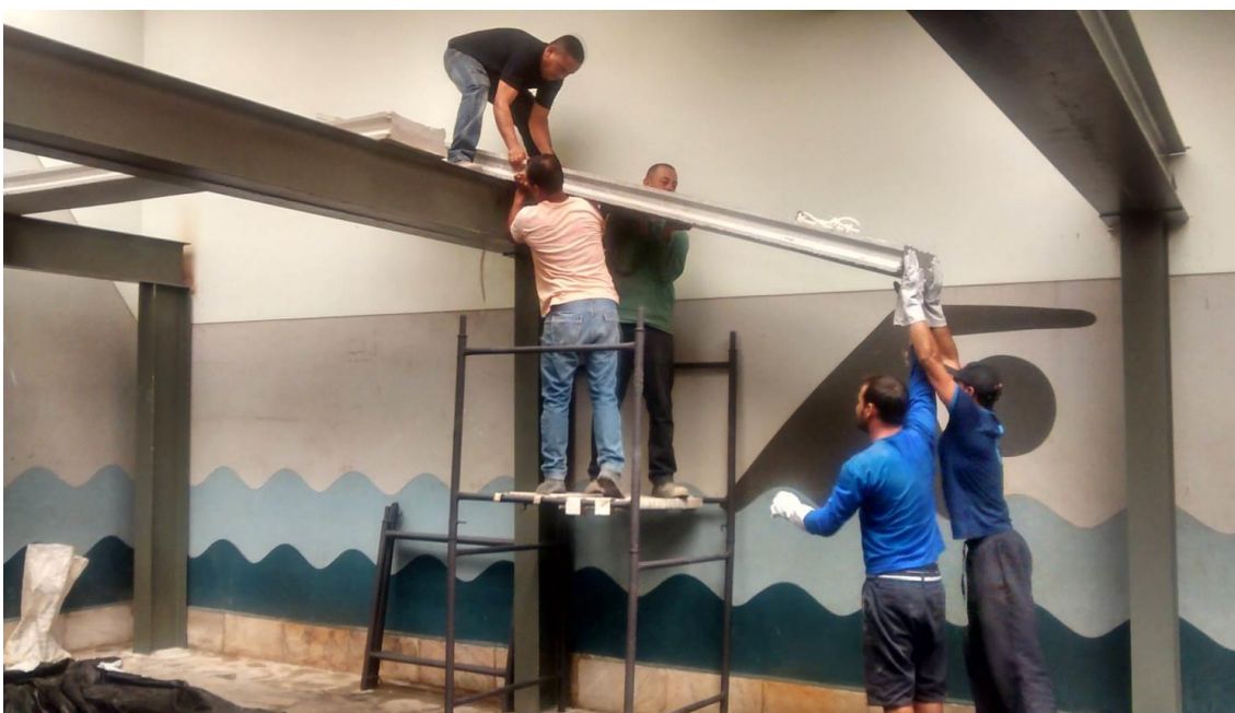
Figura 93 – Lajes em argamassa armada submetidas a montagem manual para uso interno, associadas a estrutura metálica. Fonte: peça e imagem realizadas pelo autor.
