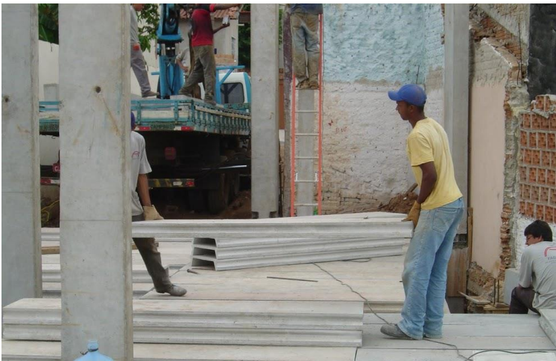
Figura 92 – Lajes em argamassa armada submetidas a montagem manual para uso externo. Fonte: peça e imagem realizadas pelo autor.
