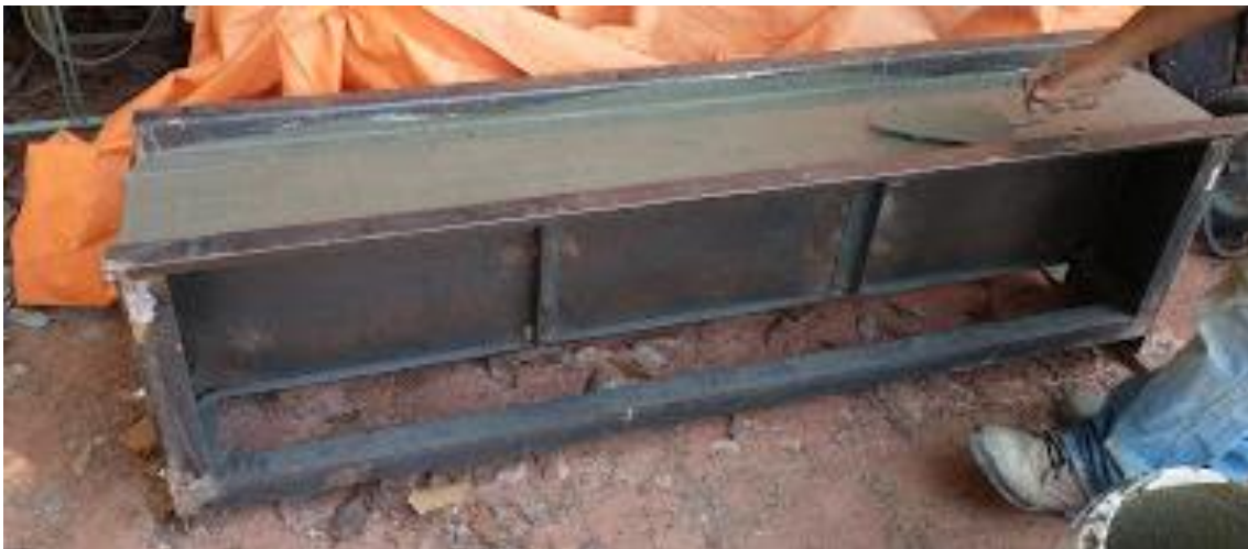
Figura 99 – Processo de fundição de degrau em argamassa armada sem vibração pela adição de hiperplastificante, a partir de forma metálica. Fonte: peça e imagem realizadas pelo autor.
