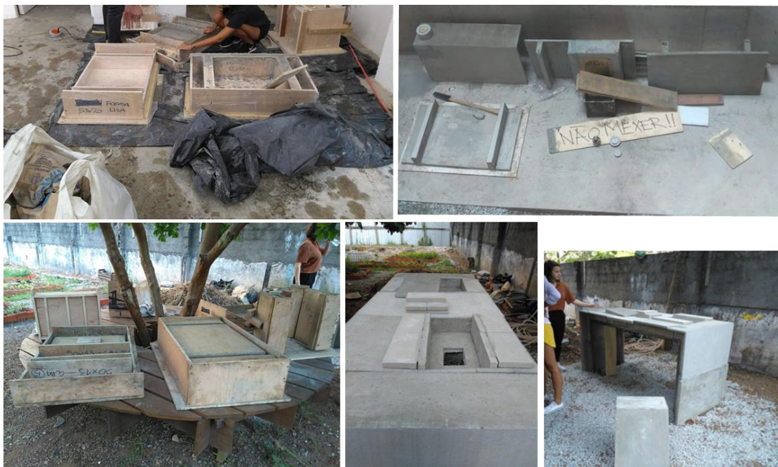
Figura 106 – Mobiliário urbano para área de lazer: bancada para churrasqueira e cuba. Na sequência da esquerda para a direita e cima para baixo: componentes fundidas em forma de madeira, componentes desformados, formas dispostas no local de implantação para discussão com a comunidade, visão superior e externa da peça montada apresentada à comunidade. Fonte: imagens realizadas pelo autor.
