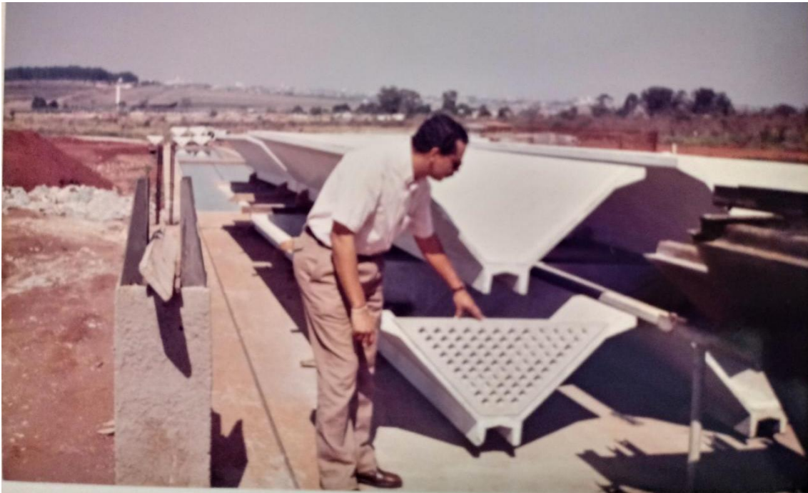
Figura 29 - Waldir Silveira testando encaixe da peça de arremate na VS8 (Viga Seccionada 8 mod.). Imagem: José Carlos Brito, 1992.
