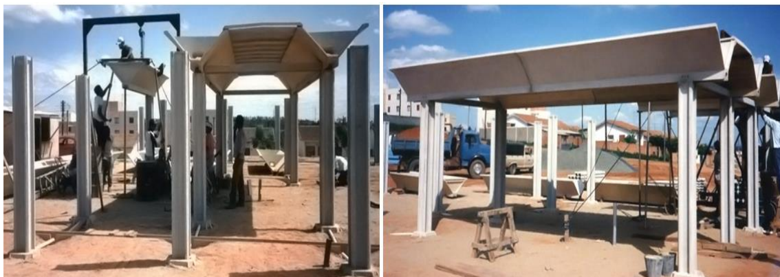
Figura 09 – Obra em andamento em ritmo lento durante a decisão da interrupção. Imagem José Carlos Brito, 1992.
