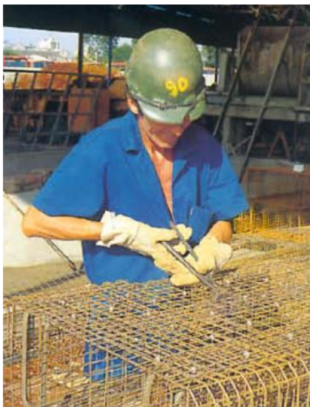
Figura 25 - Aplicação com torquês de espaçadores plásticos na armação. Fonte: CAMPOS, 1994, p.18.
