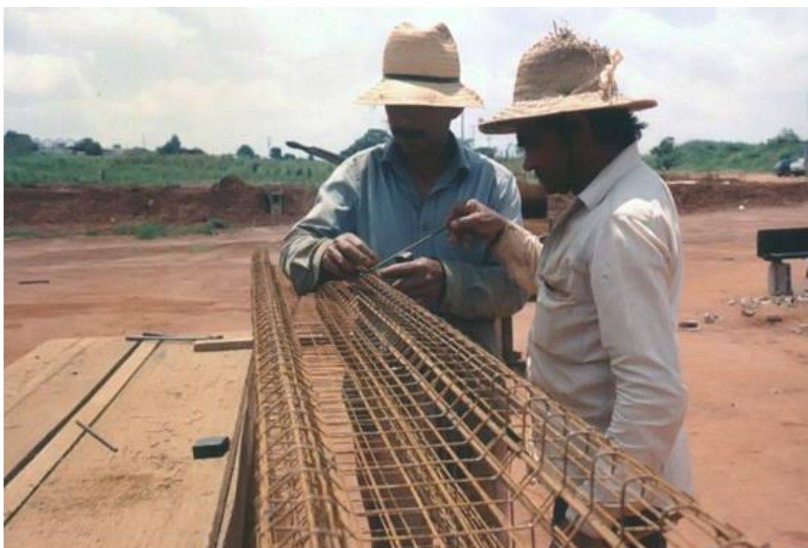
Figura 22 - Montagem da armação do PLT- pilar tipo. Imagem José Carlos Brito, 1992.
