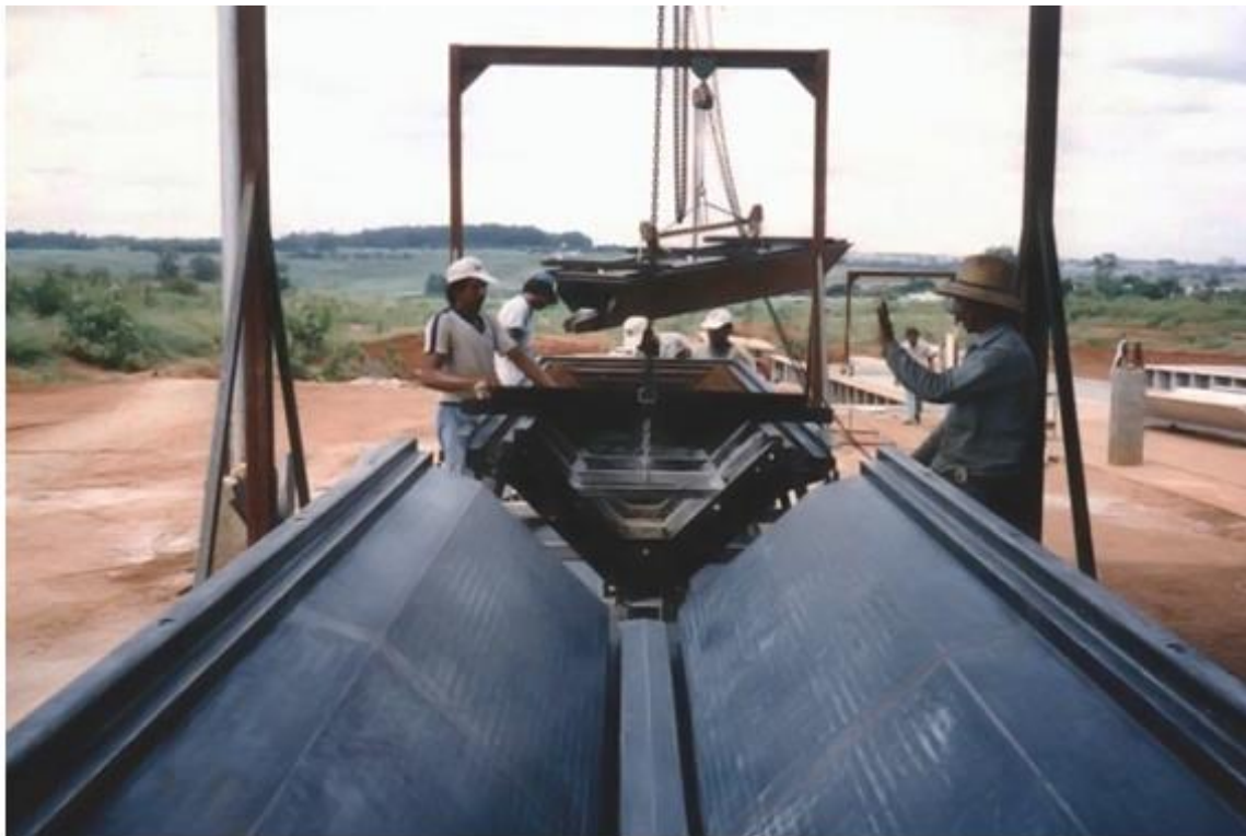
Figura 18 - Forma de viga sobre o tanque de primeira cura. Imagem: José Carlos Brito, 1992.
