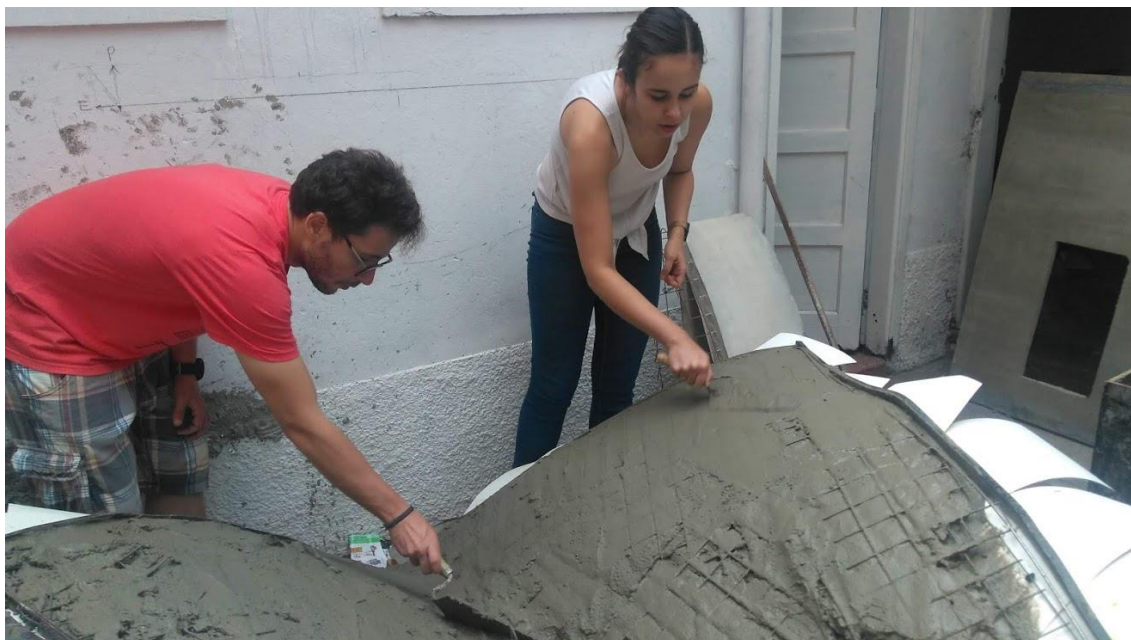
Figura 108 – Cobertura modular de argamassa armada para espaços públicos. Moldagem da peça, no curso Conceber e construir. Fonte: imagem realizada pelo autor.
