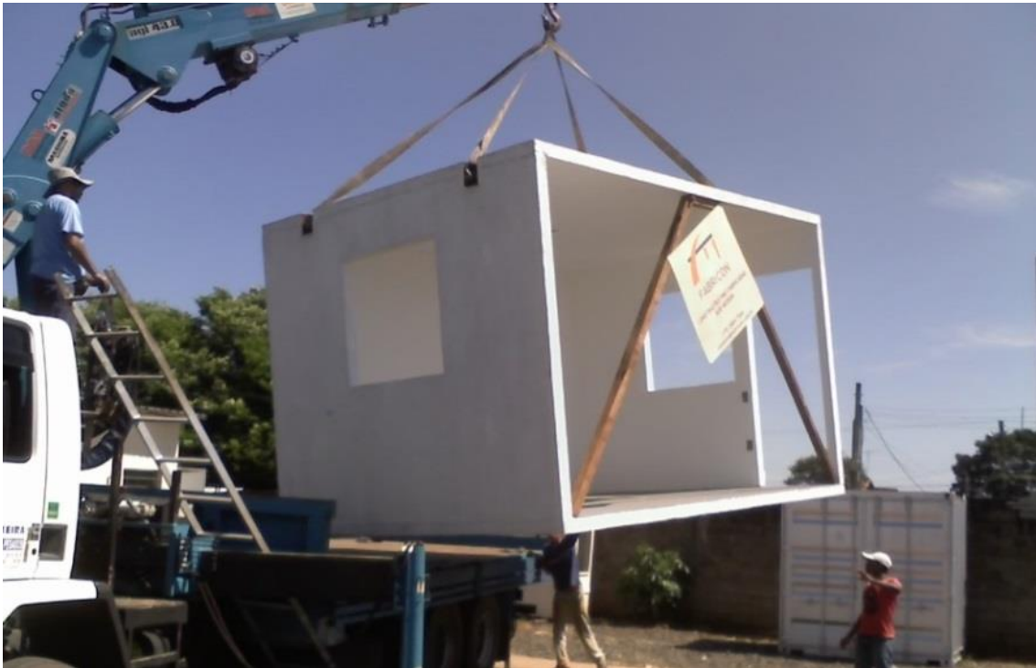
Figura 94 – Habitáculo modular em argamassa armada para usos diversos; içamento por guindauto. Dimensões internas: c=4\text{m} ; l=2,70\text{m} ; h=2,5\text{m} . Fonte: peça e imagem realizadas pelo autor.
