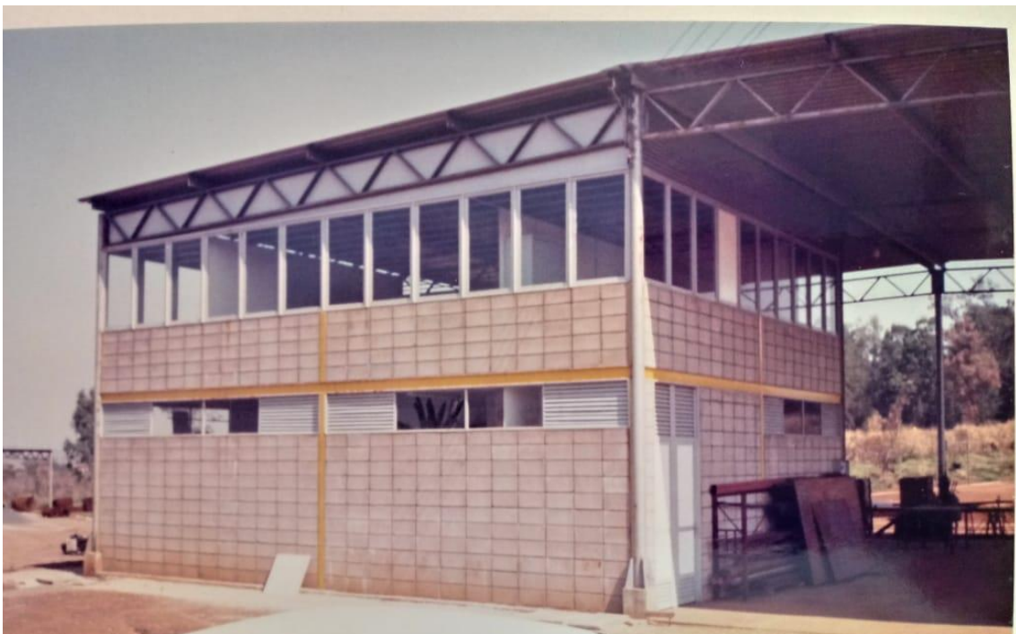
Figura 30 – Imagem do almoxarifado, vestiário no pavimento térreo e escritório no pavimento superior da FAC. Imagem: José Carlos Brito, 1992.
