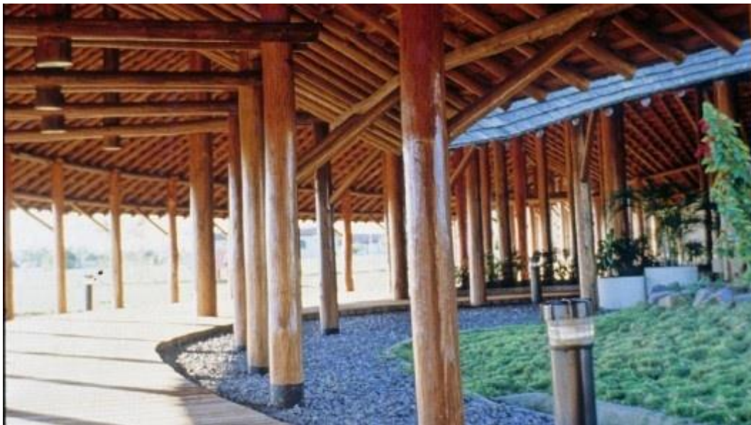
Figura 52-Centro Ambiental de Balbina. Espaços de terraços com utilização de madeira roliça para estrutura da cobertura. Arq Severiano Porto.
