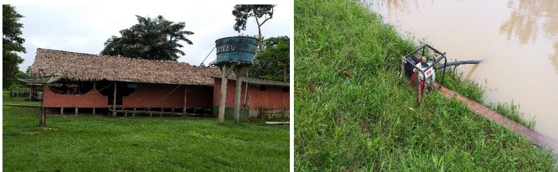
Figura 27- Estrutura da caixad'água e bomba Fonte: Vera Luz, 2019.
