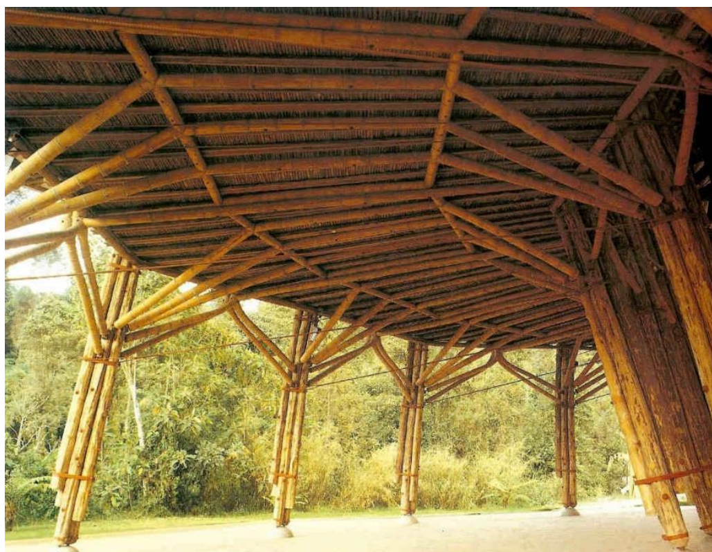
Figura 62- Estrutura do Pavilhão Zeri.
