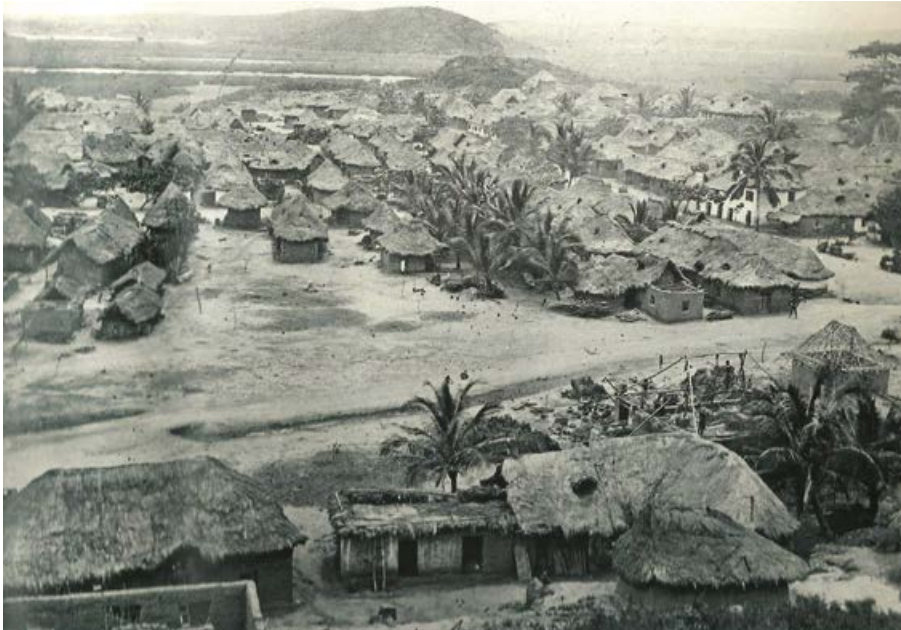
17. Para as obras da Serra Nova (1897) foi instalado um acampamento caiçara em taipa de mão, como canteiro de trabalhadores, no pé da Serra. (Reis Filho, 1989, p.27)
