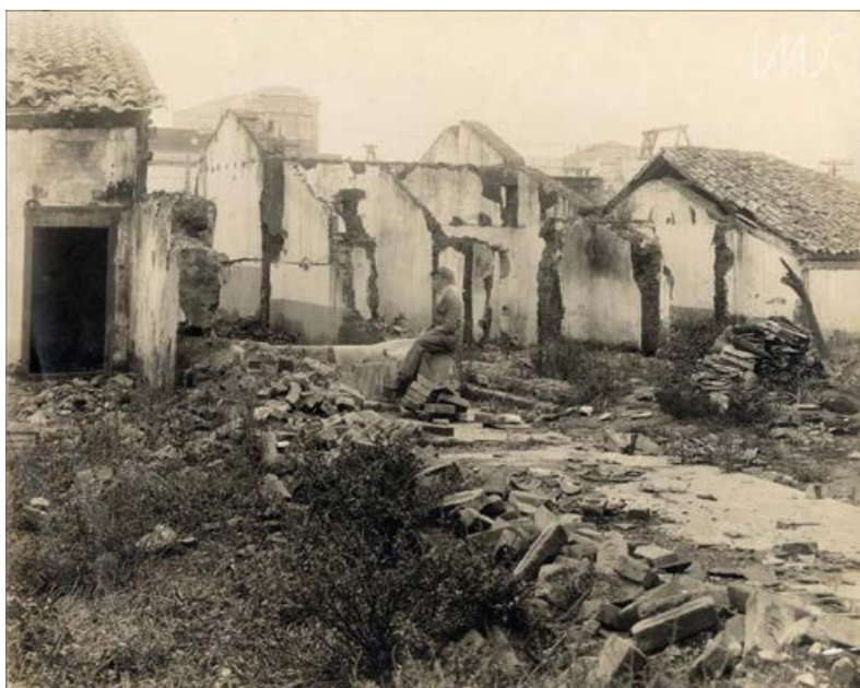
33. Inúmeras quadras seriam demolidas próximas à Sé, no início do século XX. Foto do casario em pé e em demolição na Rua da Esperança, 1911. Vincenzo Pastore. IMS
