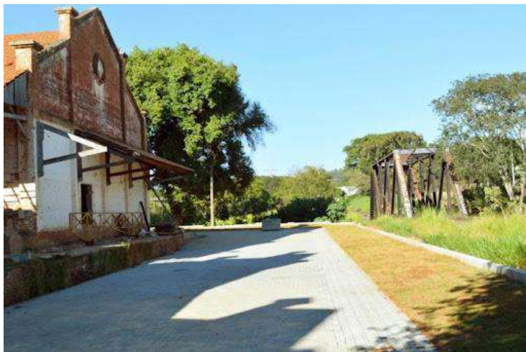
Figura 94. Barracões da antiga CEAGESP, já em processo de reforma.
