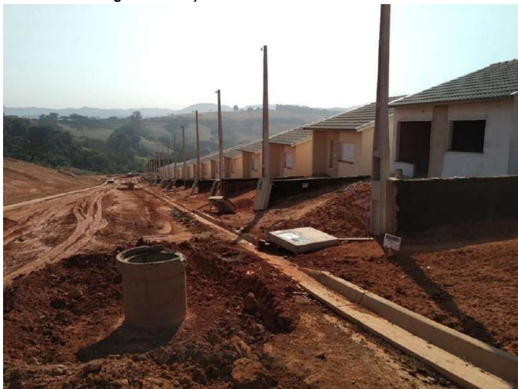
Figura 72. Conjunto Habitacional Jardim Nova União.
