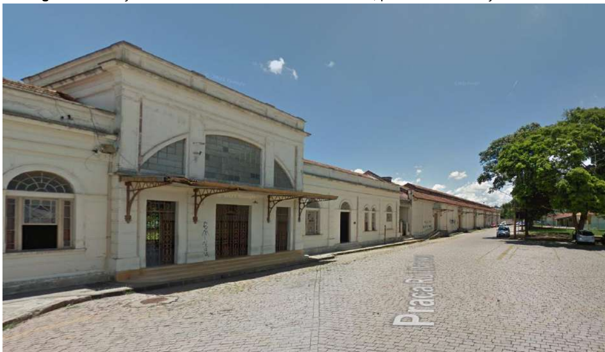
Figura 87. Estação Ferroviária antes da reforma. À direita, parte da atual Praça Rui Barbosa.
