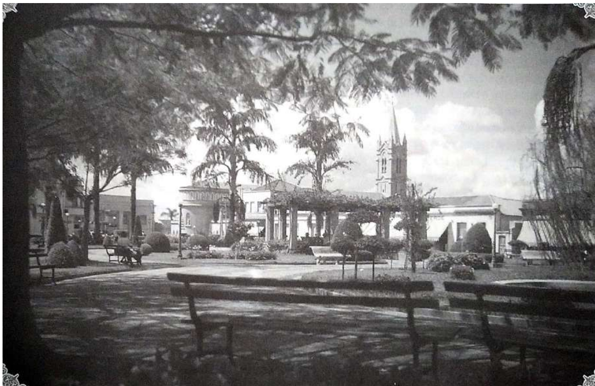
Figura 51. Praça Joaquim José localizada na Av. Dona Gertrudes, ao fundo o Igreja Matriz (Catedral), em meados da década de 1940.
