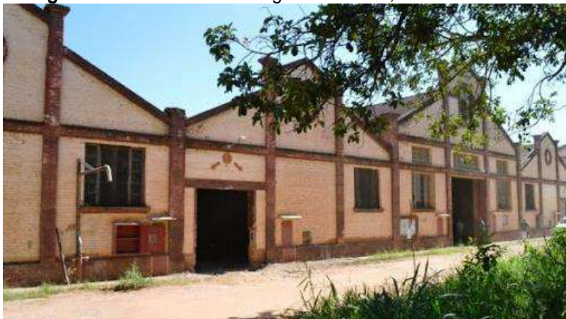
Figura 92. Barracões da antiga CEAGESP, antes da reforma.
