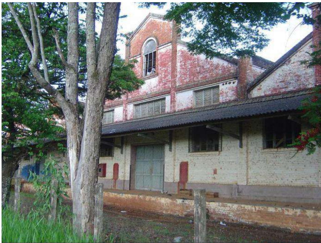
Figura 93. Barracões da antiga CEAGESP, antes da reforma.
