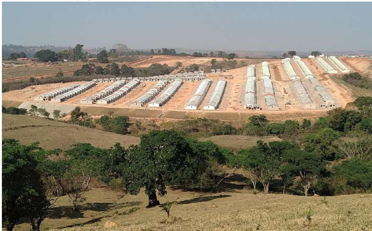
Figura 71. Conjunto Habitacional Jardim Nova União visto da Estrada que liga São João da Boa Vista/SP à Andradas/MG. Atenção para a grande movimentação de terra necessária para a execução deste projeto, necessitando concretar uma parte do talude (à esquerda).
