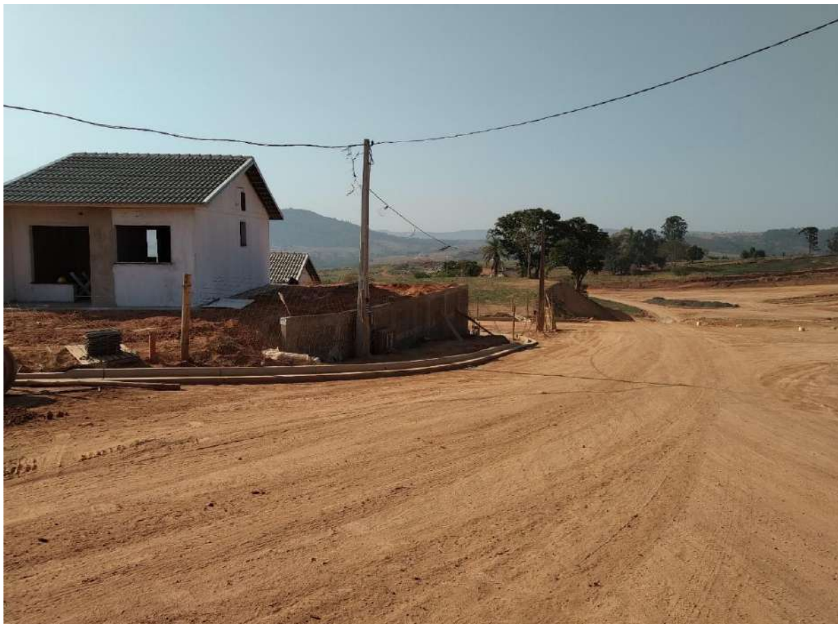
Figura 73. Ao lado do Conjunto Habitacional Jardim Nova União, novos loteamentos populares serão abertos.
