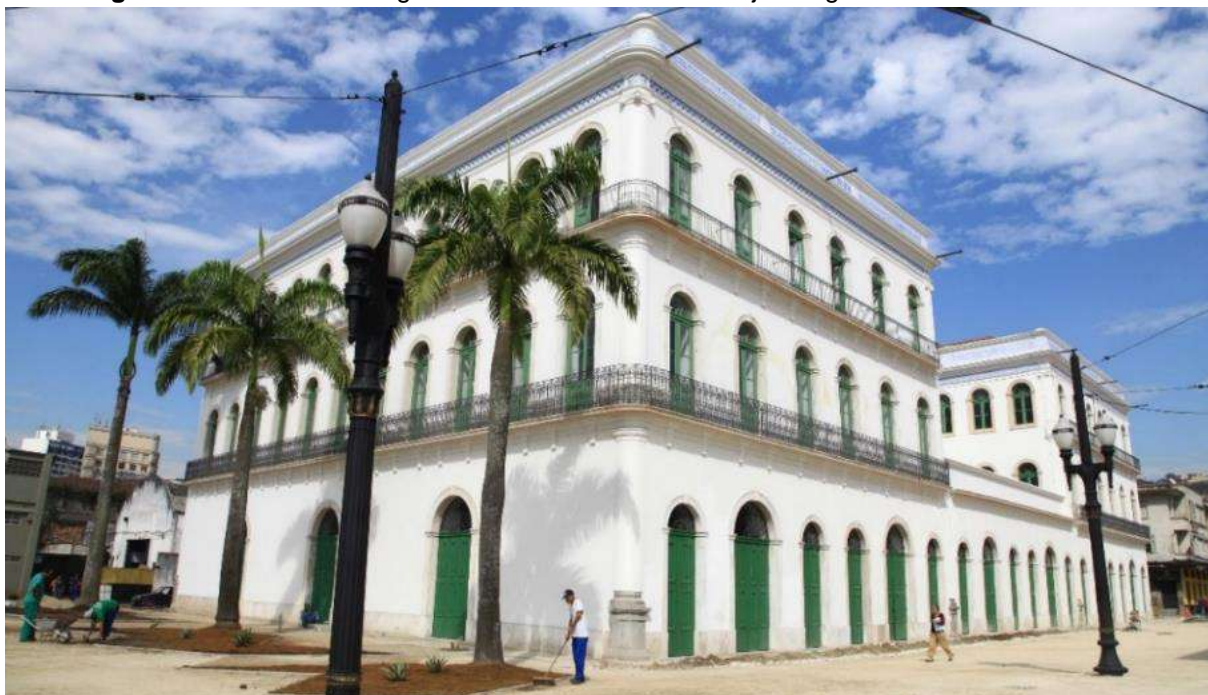
Figura 18. Casarão Valongo reconstruído em 2014 e hoje abriga a sede do Museu Pelé.
