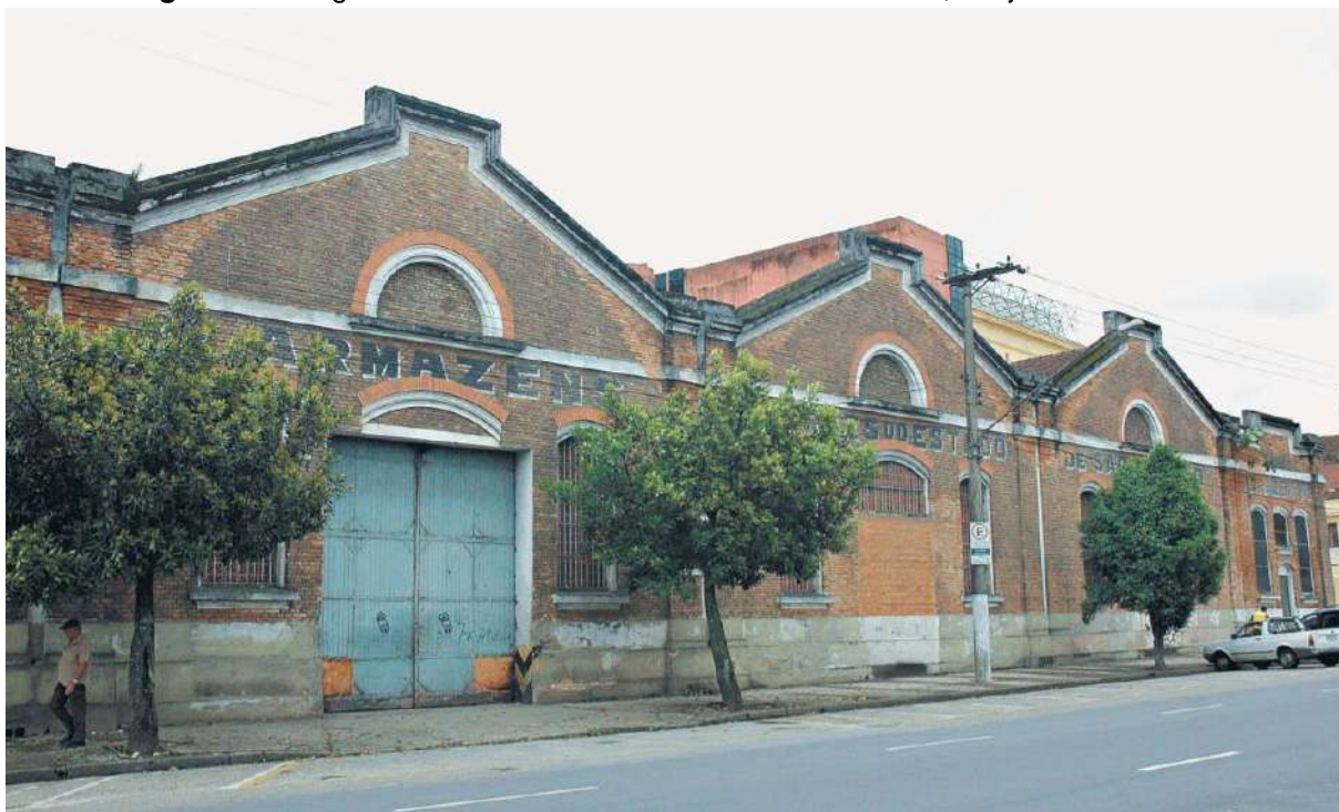
Figura 19. Antigos barracões da CEAGESP antes da reforma, em janeiro de 2008.
