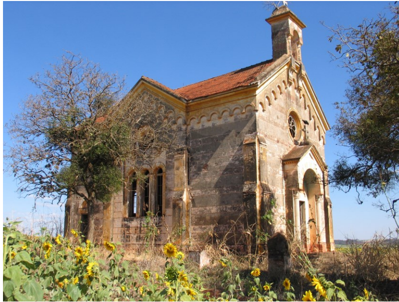
Figura 31 – Capela da Fazenda Santa Veridiana. Foto de Adolpho Legnaro Filho (2007).
