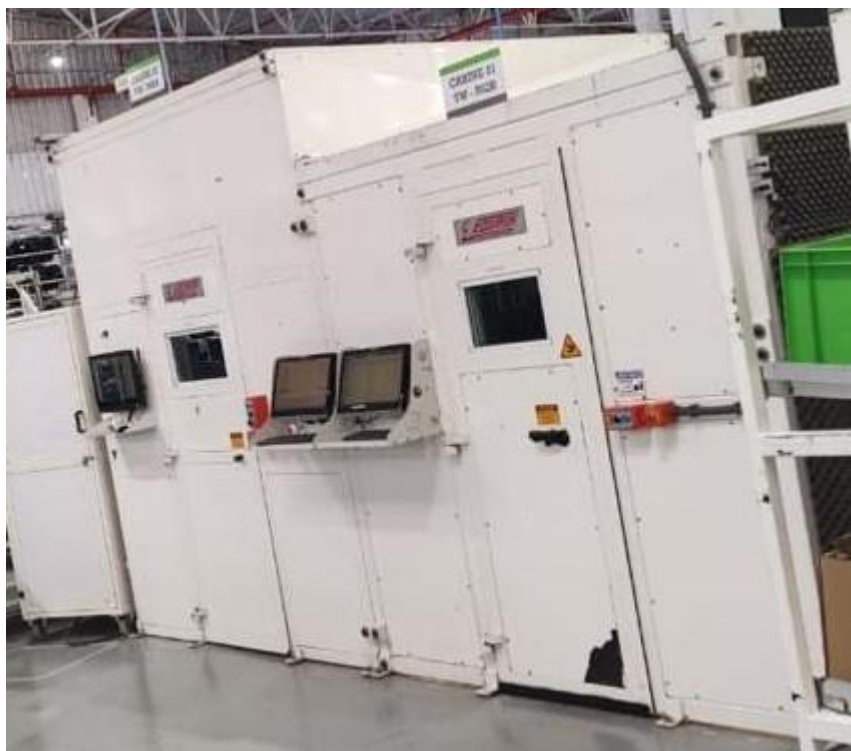
Figura 21. Posto 10 e 11 (Cabine 1 e 2)
