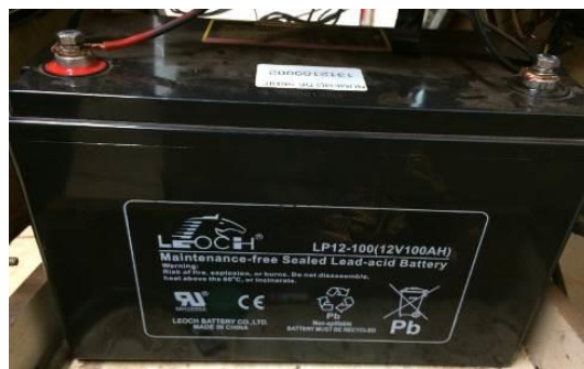
Figura 9 – Bateria Estacionaria
