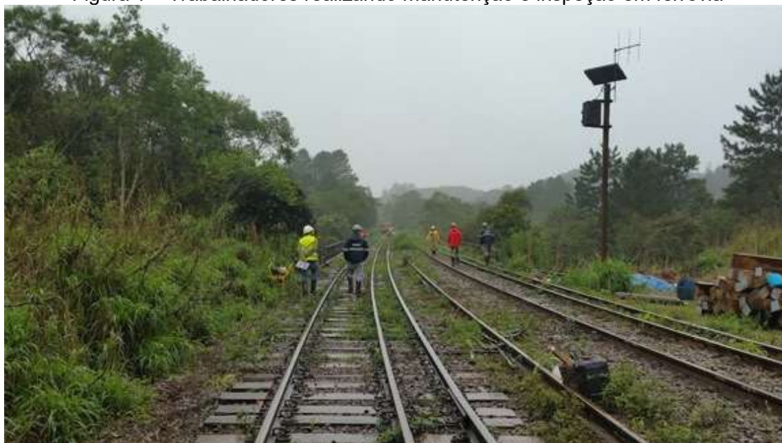
Figura 1 – Trabalhadores realizando manutenção e inspeção em ferrovia
