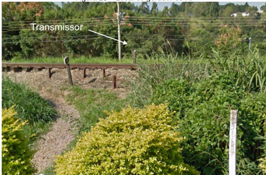
Figura 25 – Local do gerador de RF
