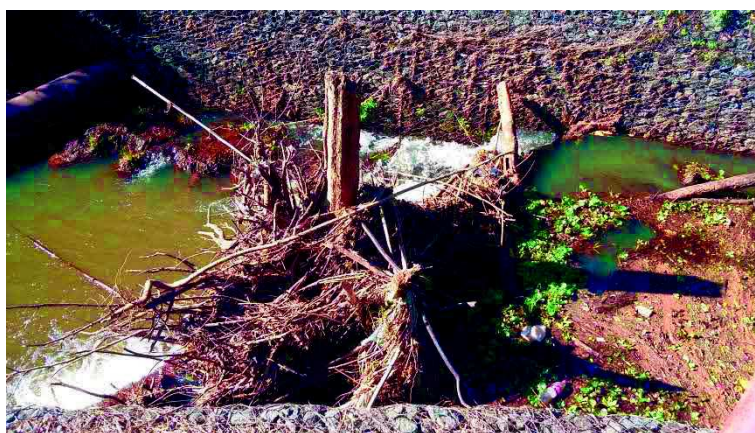
Figura 23. Ponto de coleta 5 (P05) com resíduos depositados, represamento da água por árvore carregada na enxurrada e surgimento de espécies aquáticas.
