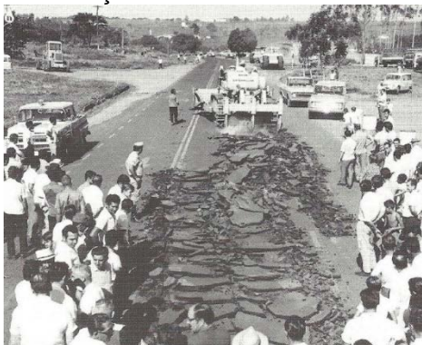
Figura 7 – Demolição com trator sobre esteira com ripper
