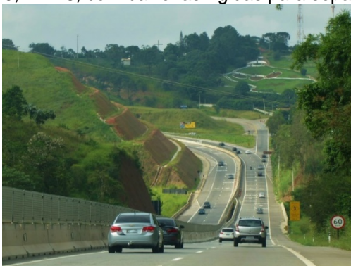
Figura 54 - Rodovia SP 099, km 18, com barreiras rígidas para separação das pistas de tráfego
