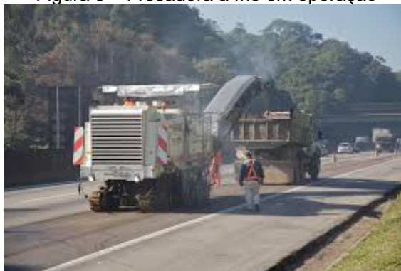
Figura 9 – Fresadora a frio em operação
