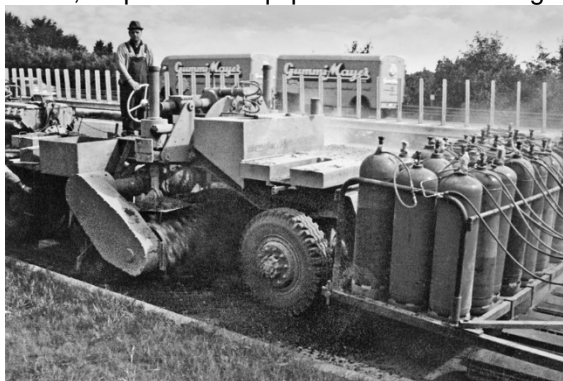
Figura 8 – 1970, os primeiros equipamentos de reciclagem a quente
