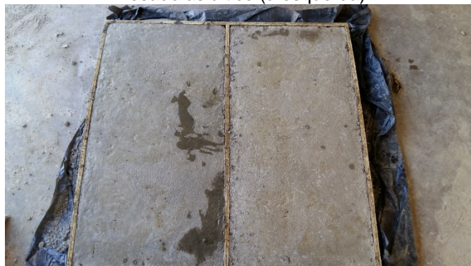
Figura 48 – Lajes de fundo das valetas moldadas com concreto convencional (à direita) e com fresado asfáltico (à esquerda)
