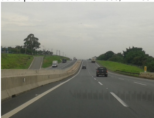
Figura 56 - Separação de pistas na Rodovia SP 330, km 139 com barreiras rígidas
