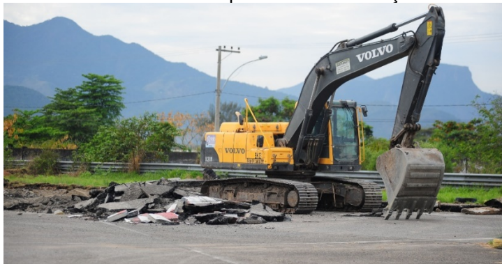
Figura 5 – Escavadeira hidráulica no processo de demolição da camada asfáltica
