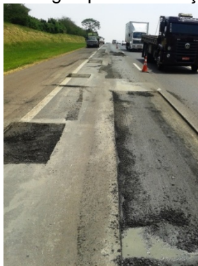
Figura 11 – Situação local logo após intervenção com fresadora a frio
