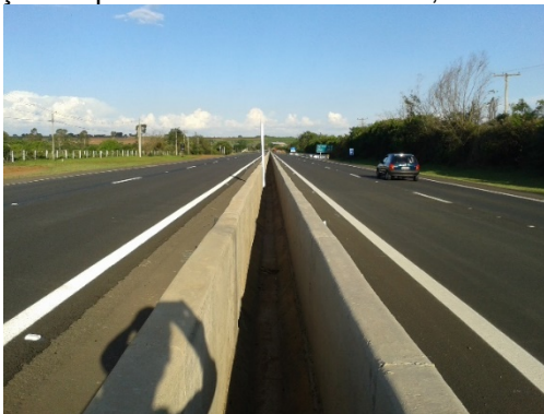
Figura 55 – Separação de pistas na Rodovia SP 147, km 85 com barreiras rígidas
