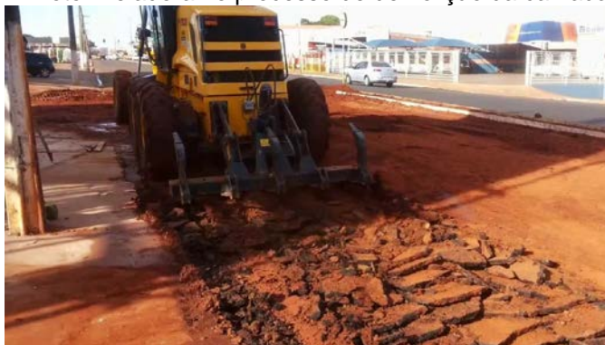
Figura 6 – Motoniveladora no processo de demolição da camada asfáltica
