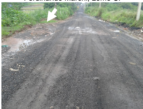
Figura 3 – Carreamento de fresado asfáltico para sistema de drenagem superficial Rua Ferdinando Marchi, Leme-SP
