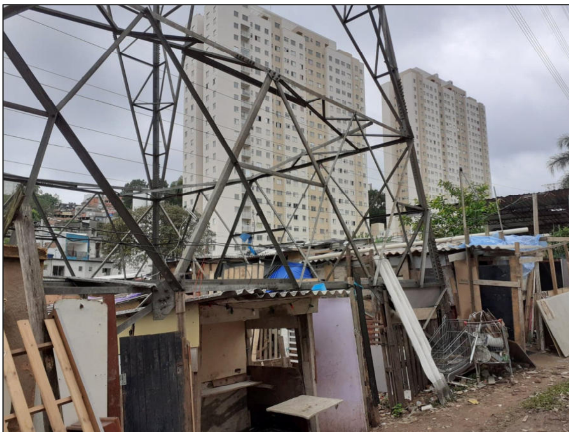
Figura 26 - Registro fotográfico do autor em ação emergencial da TETO Brasil em comunidade na zona sudeste de São Paulo, SP. Registro feito 16 nov 2019.
