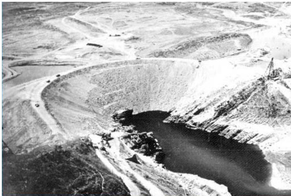
Figura 9: Barragem do açude Orós, em fase final de construção, no ano de 1960
