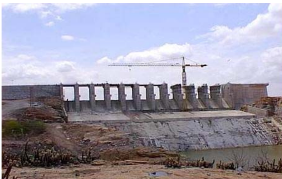
Figura 12: Construção da barragem Castanhão. Fonte: DNOCS, 1999
