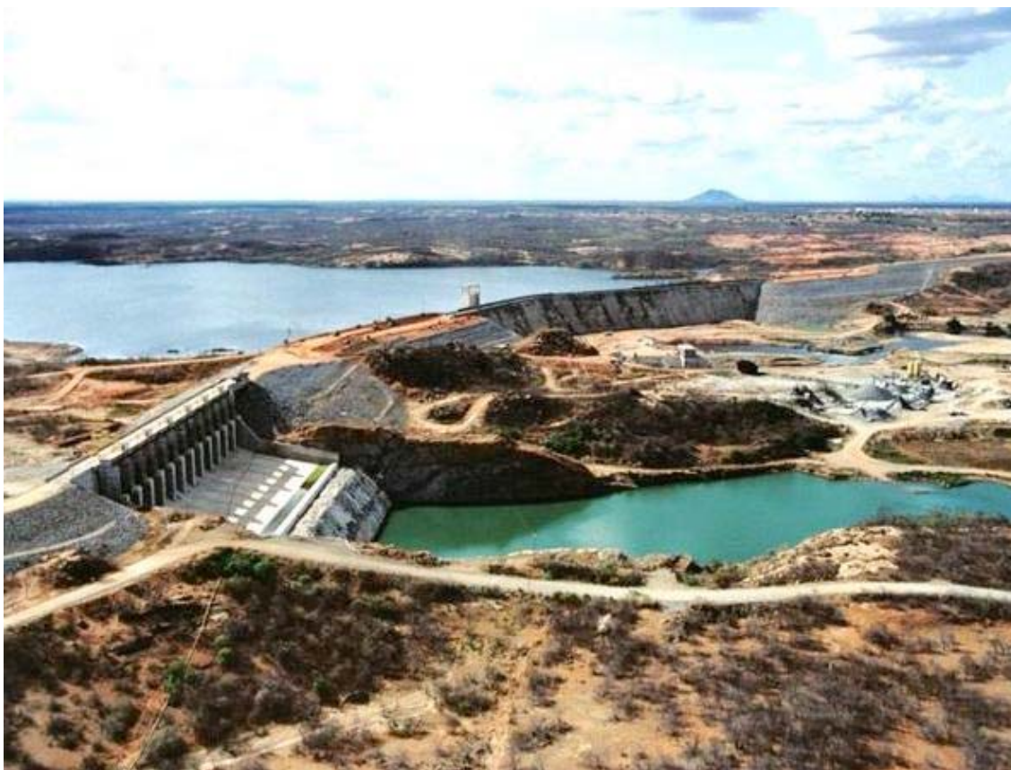
Figura 16: Barragem Castanhão. Fonte: DNOCS, 2003
