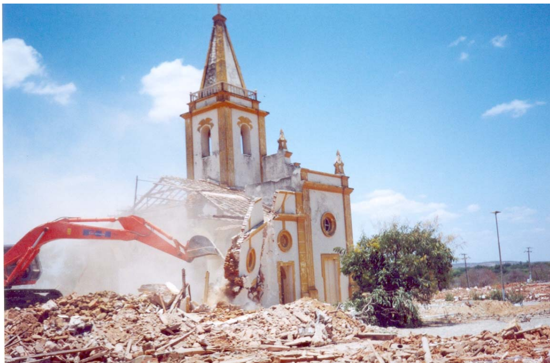
Figura 76: Demolição da Igreja Matriz de Jaguaribara
