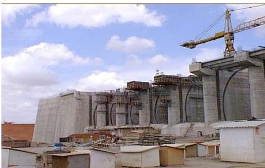
Figura 13: Construção Barragem Castanhão. Fonte: DNOCS, 1999
