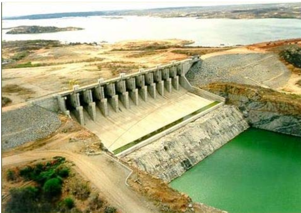
Figura 14: Barragem Castanhão. Fonte: DNOCS, 2002
