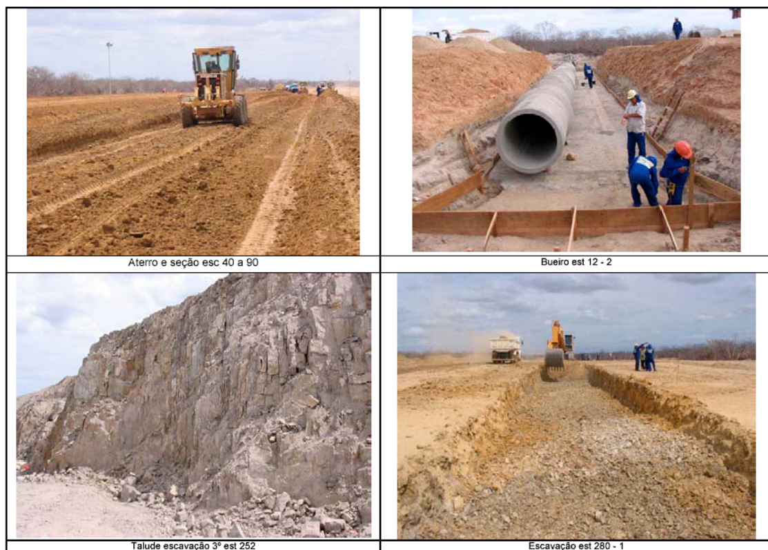
Figura 26: Canal da Integração. Trecho III. Fonte: SRH, dez 2005
