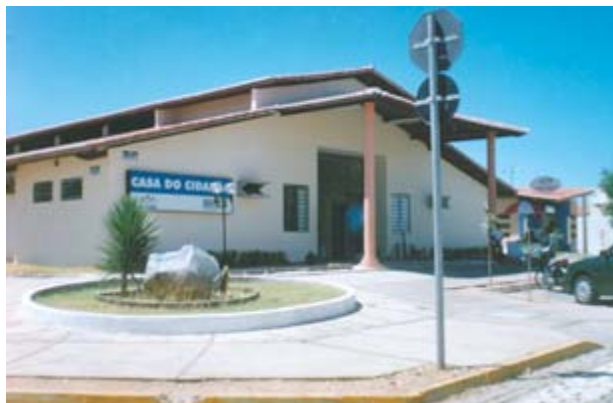
Figura 67: Casa do Cidadão
