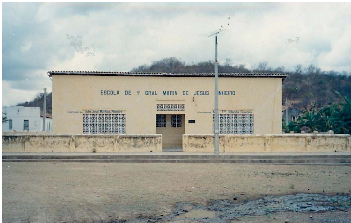
Figura 41: Antigo Distrito de Poço Comprido. Grupo Escolar do Distrito de Poço Comprido. Fonte: DNOCS. Açude Público Castanhão. Relatório de Impacto no Meio Ambiente. V.3. Foto 25/69
