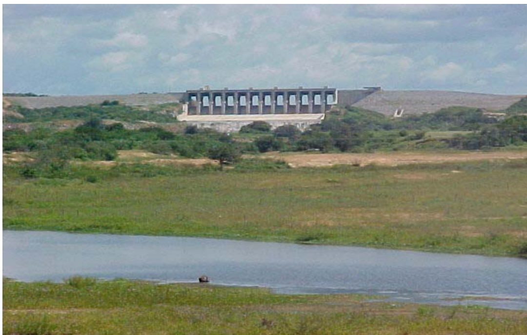
Figura 19: Barragem do Castanhão Fonte: DNOCS, 2004
