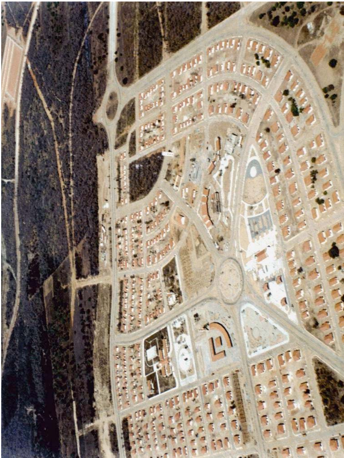
Figura 52: Foto aérea núcleo central de Nova Jaguaribara. Fase de construção. Fonte: SEINFRA 2001
