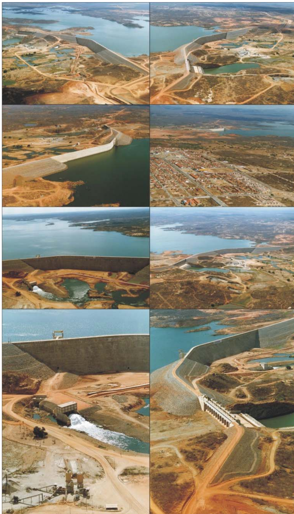
Figura 17: Barragem Castanhão. Fonte: DNOCS,2004
