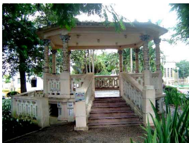
Figura 167. Coreto da Praça Central de Monte Alto - 2005
