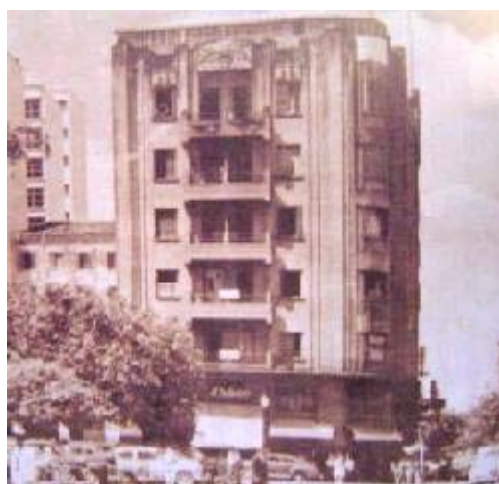
Figura 20. Edifício Diederichsen – década de 30
