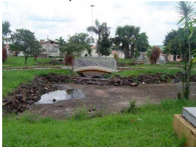
Figura 83. Vista interna da Praça José Pizarro – Ponte de concreto ao fundo
