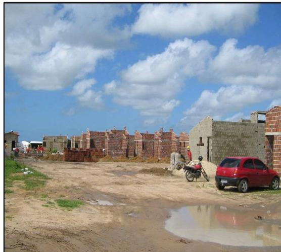
Imagem 15: À esquerda, avenida principal com canteiro e iluminação pública, à direita, casas ainda na fase de alvenaria.
