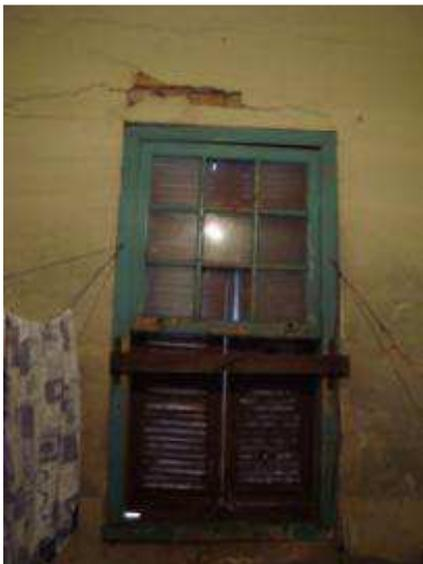
Figura 43 – Foto do interior de residência situada à Rua João Pessoa. Nota-se o mau estado de conservação, com rachaduras próximas às vergas.
