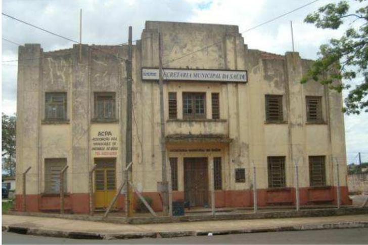
Figura 34 – Foto da fachada principal do CCI (Centro de Convivência do Idoso). Percebe-se que além da substituição das esquadrias e do gradil, o imóvel não recebe outros cuidados externos há algum tempo.
