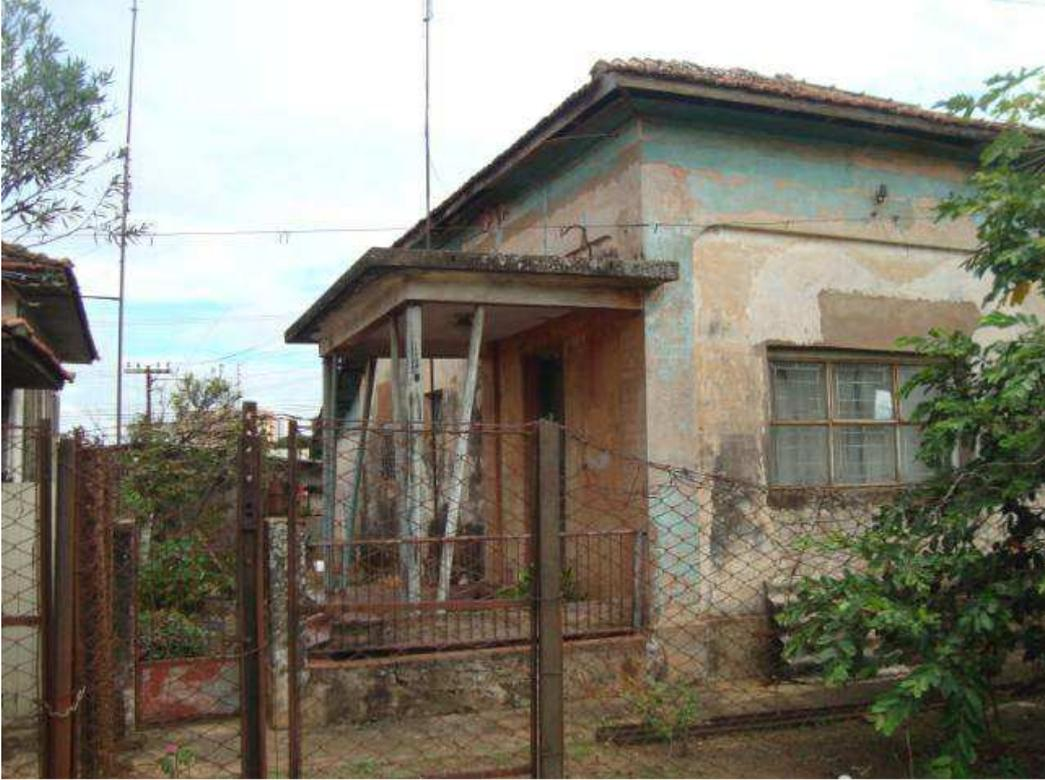
Figura 46 – Foto da fachada de residência localizada à Rua João Pessoa. Nota-se a substituição das esquadrias e a falta de manutenção no imóvel
