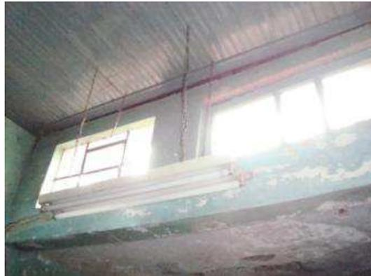
Figura 47 – Foto do interior de residência situada à Rua João Pessoa. Nota-se as rachaduras entre o forro e as janelas na foto à direita e as ferragens da estrutura aparente nas fotos à esquerda
