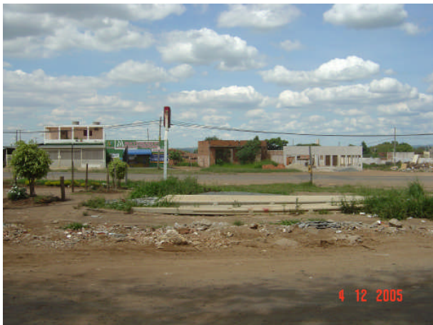
Vista da rodovia Miguel Melhado Campos
