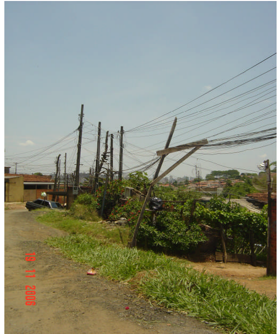
Instalação de rede elétrica.
