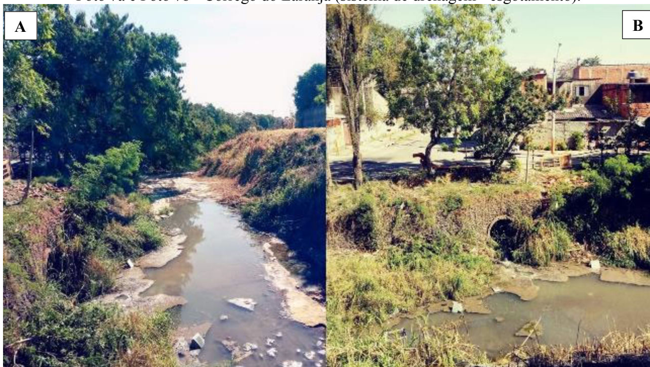
Foto 7a e Foto 7b - Córrego do Laranja (sistema de drenagem - esgotamento).
