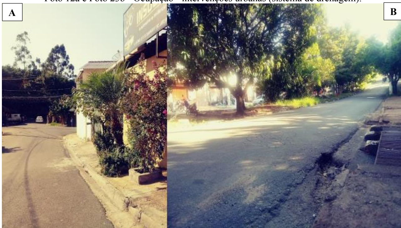
Foto 12a e Foto 23b - Ocupação - intervenções urbanas (sistema de drenagem).
