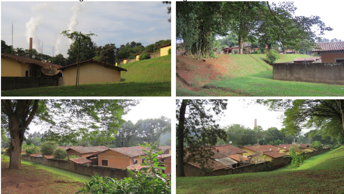
Figura 72 – Levantamento fotográfico Colônia 2: taludes
