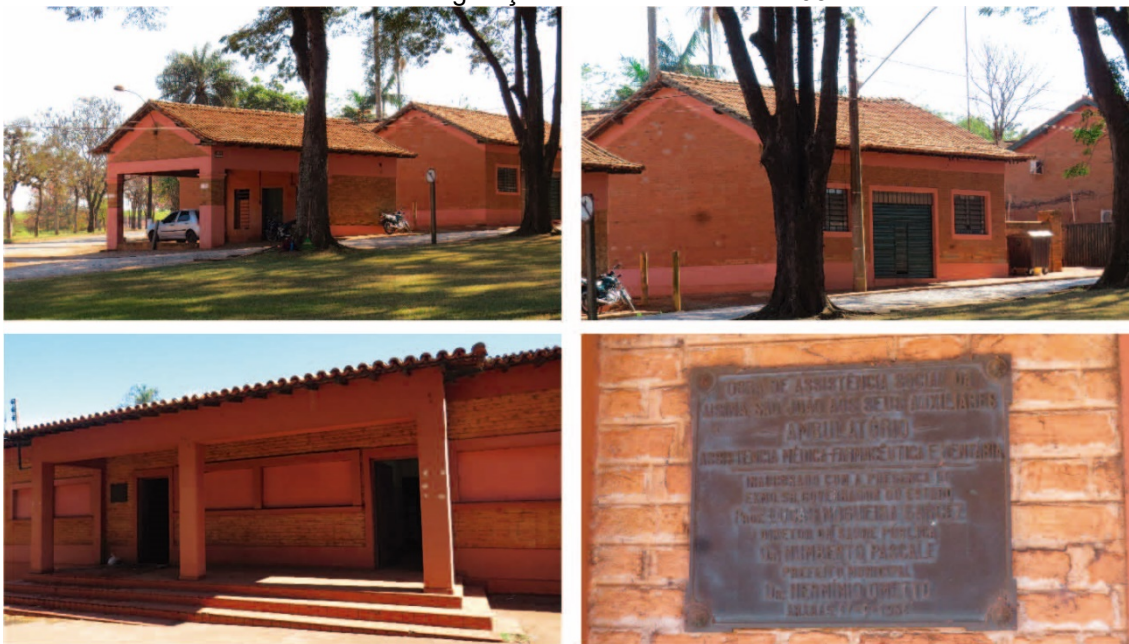
Figura 40 - Levantamento fotográfico Equipamentos coletivos: antigo posto de combustível, hoje residência; antigo armazém, hoje almoxarifado, ambulatório e farmácia, hoje arquivo. Placa de inauguração do ambulatório em 1954.
