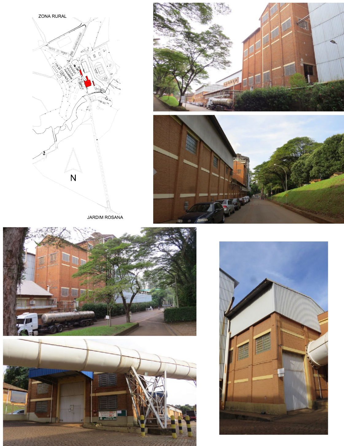
Figura 65 - Conjunto fabril original em tijolos e as ampliações em estruturas e fechamentos metálicos na USL
