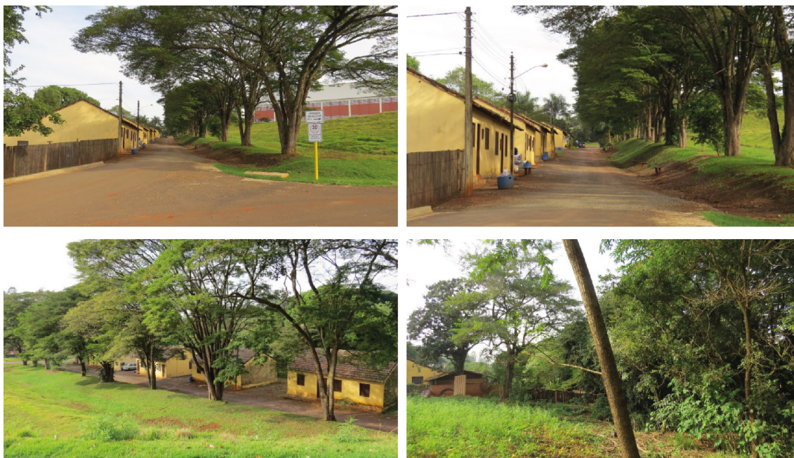
Figura 77 – Levantamento fotográfico Colônia 03, implantação: rua, talude e APP
