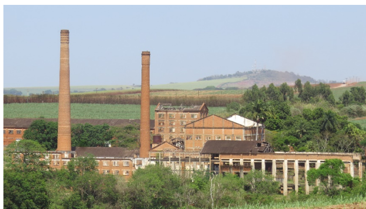
Figura 89 - Levantamento fotográfico Usina Palmeiras: conjunto industrial
