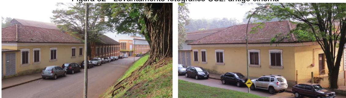
Figura 82 - Levantamento fotográfico USL: antigo cinema
