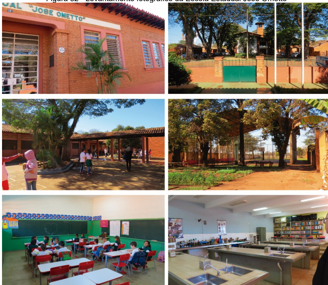
Figura 52 - Levantamento fotográfico da Escola Estadual José Ometto
