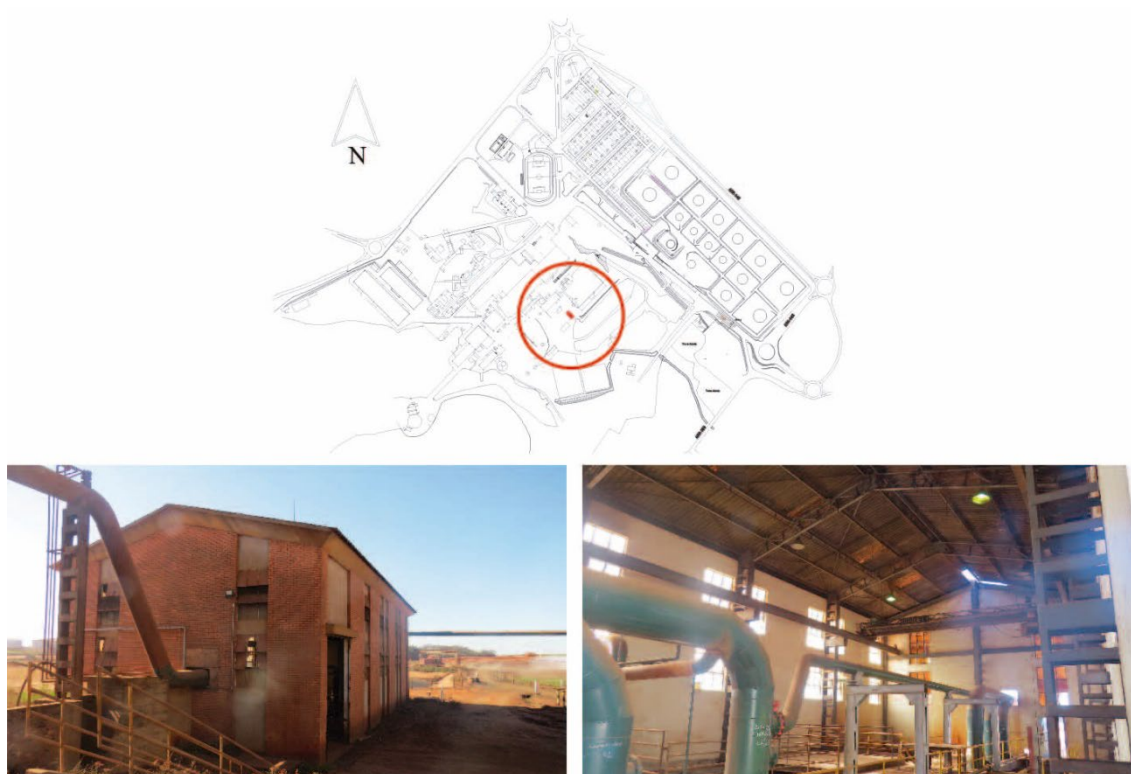
Figura 35 - Localização e levantamento fotográfico dos elementos arquitetônicos industriais 03 – antigo abastecimento das caldeiras
