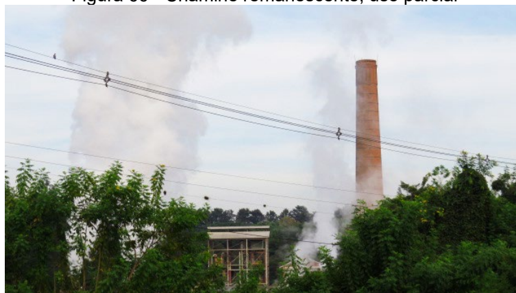
Figura 66 - Chaminé remanescente, uso parcial
