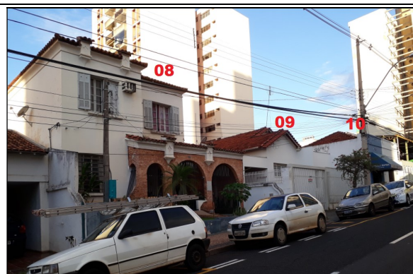
E. Edificações 08, 09 e 10
