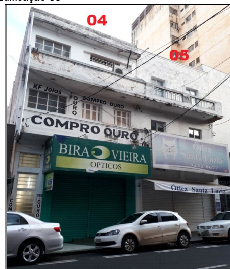
D. Edificação 04 e 05
