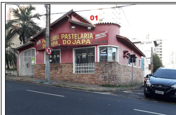
A - Edificação 01- Neocolonial
