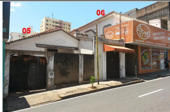
C. Edificações 05 e 06
