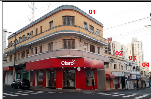
A. Edificações 01, 02, 03 e 04.
