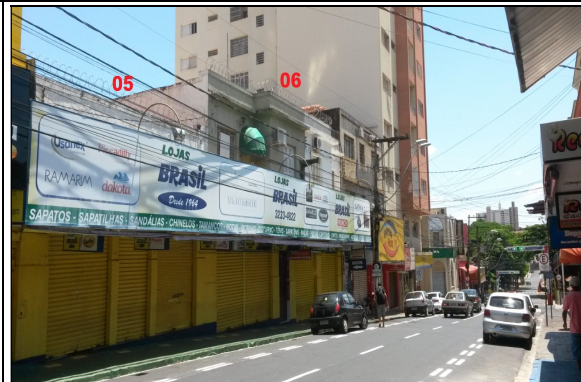
C. Edificações 05 e 06
