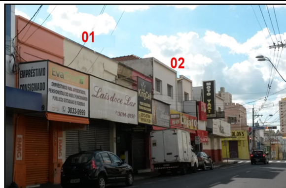
A. Edificações 01 e 02
