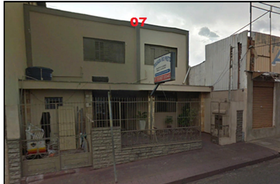
D. Edificação 07- Fonte: Google Earth
