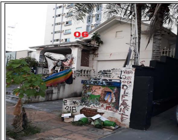
E. Edificação 06- Neocolonial
