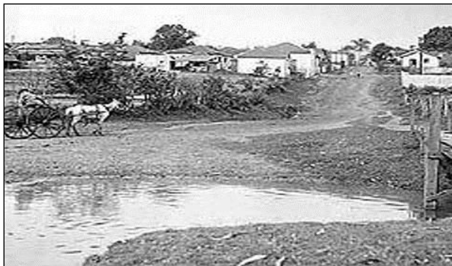
Foto 02: À direita, ponte de madeira que servia como travessia do Centro Tradicional para o Patrimônio de Nossa Senhora do Carmo pelo córrego Borá.
