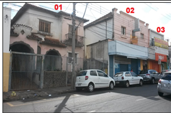
A. Edificações 01, 02 e 03
