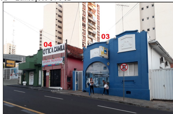
B. Edificações 03 e 04
