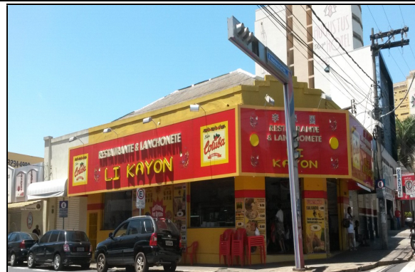
A. Edificação que apresenta Simplificação formal do Art Déco
