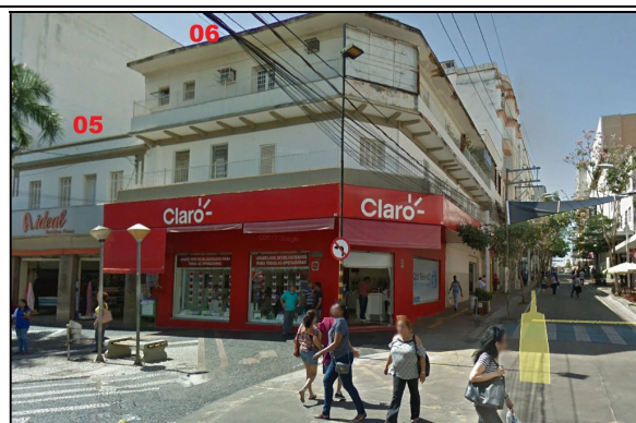
E. Edificações 05 e 06
