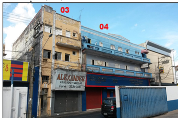
B. Edificações 03 e 04
