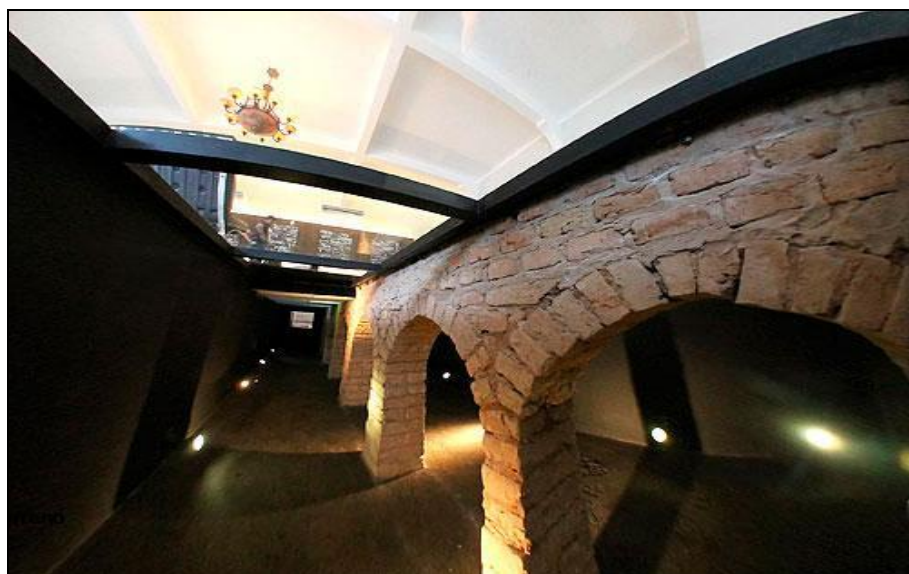
Foto 28: Sistema construtivo da fundação do Prédio da ACIRP Fonte: acervo de Hamilton Pavam, gentilmente cedida
