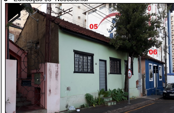
E - Edificação 05 e 06- Neocoloniais Vernaculares
