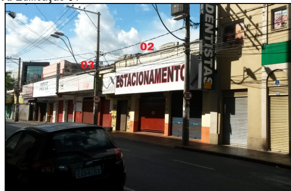
B. Edificações 02 e 03
