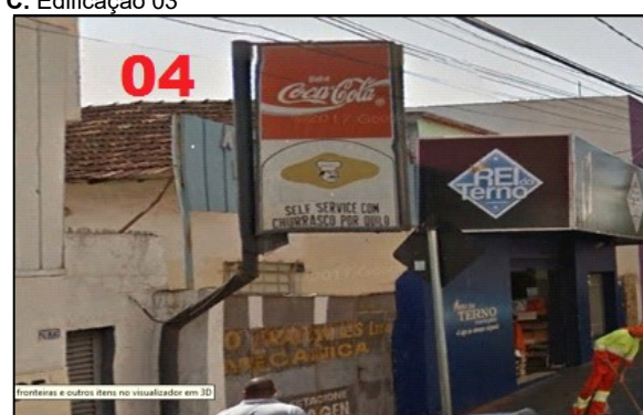
D. Edificação 04 (Fonte: Google Earth)
