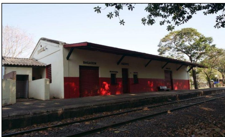
Foto 53: Estação Ferroviária de Engenheiro Schmidt Fonte: Thiago Silva (2016) 37
