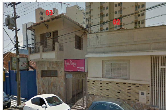
B. Edificação 02 e 03 – Fonte: Google Earth
