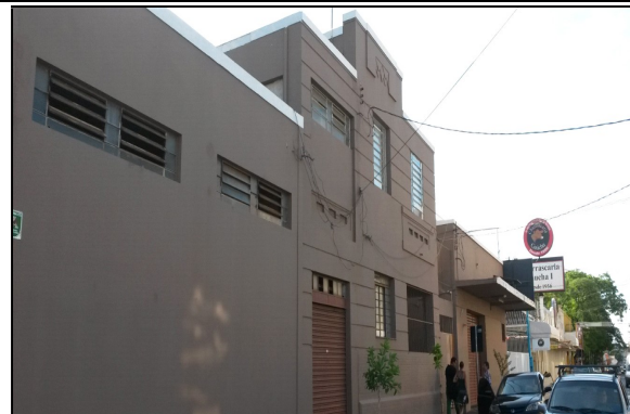
B. Edificação Art Déco
