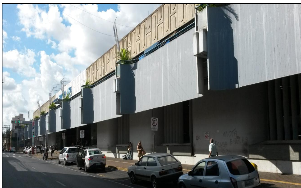
Foto 40: A Estação Rodoviária, projeto do arquiteto José Carlos de Lima Bueno
