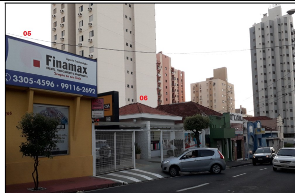
C. Edificações 05 e 06
