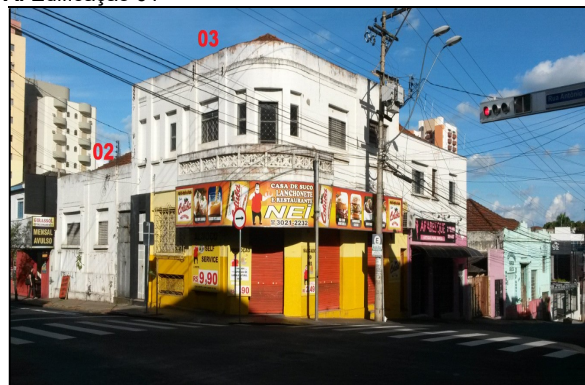
B. Edificações 02 e 03
