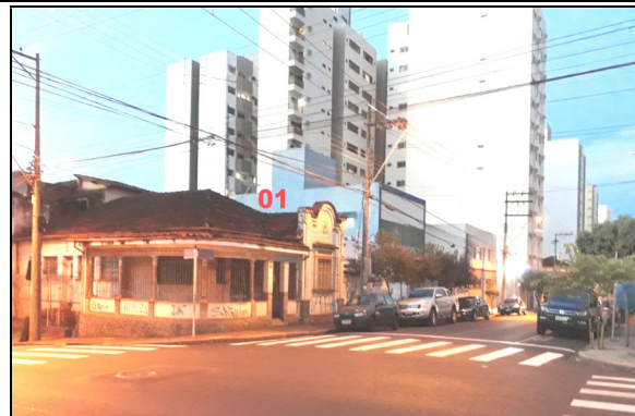
A. Edificação 01 – Neocolonial
