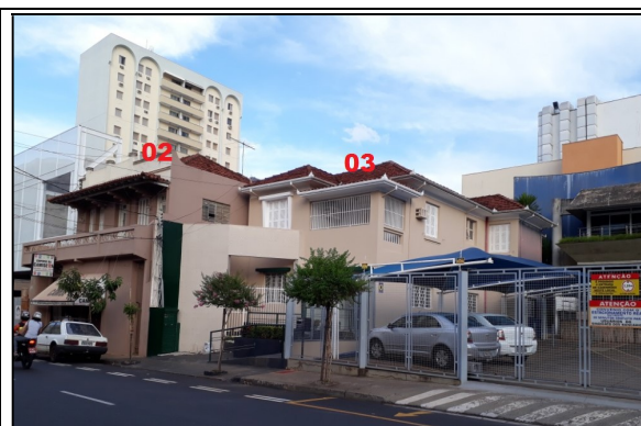
B. Edificações 02 e 03
