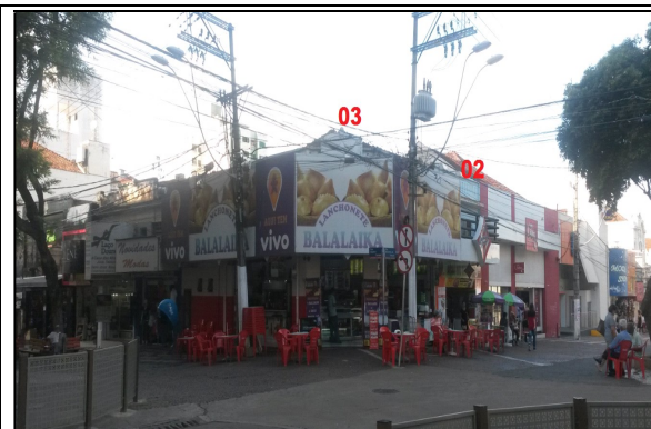
B. Edificações 02 e 03
