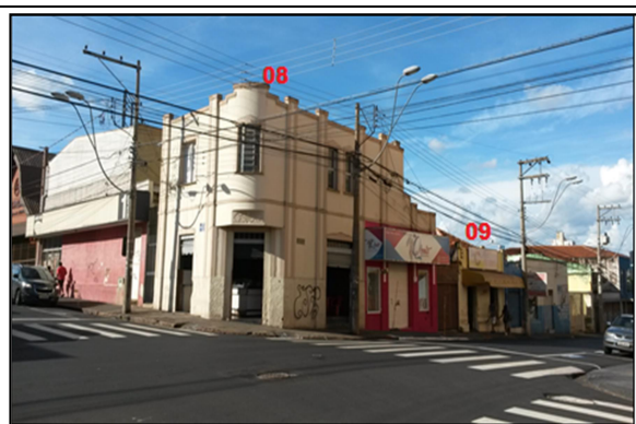
E. Edificações 08 e 09
