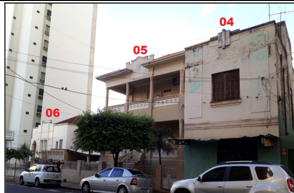
C. Edificações 04, 05 e 06
