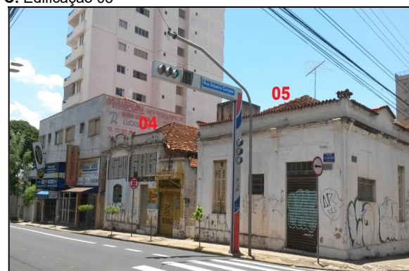
D. Edificação 04 e 05
