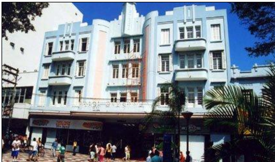
Foto 45: Edifício Zini (atual Praça Shopping), inaugurado em 1944 para abrigar o Cine-Teatro Rio Preto
