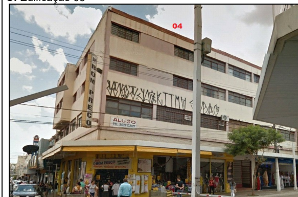
D. Edificação 04 – Fonte: Google Earth
