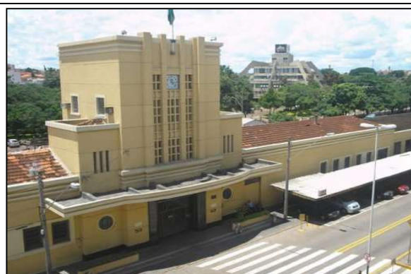
A. Estação Ferroviária
