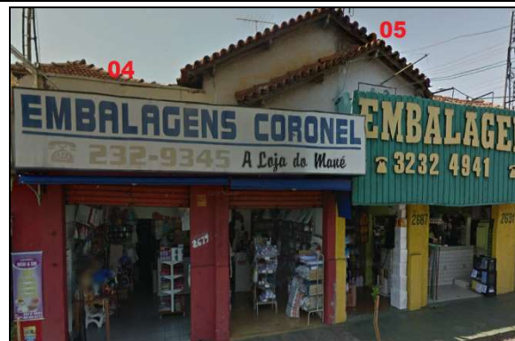
D. Edificações 04 e 05
