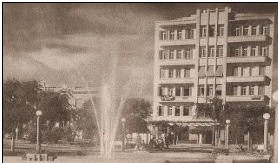
Foto 08: Edifício Caramuru, com frente para o Jardim Novo (atual Praça Ruy Barbosa) Fonte: Instituto Histórico Geográfico e Genealógico de São José do Rio Preto (2017)
