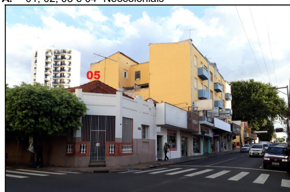
B. Edificação 05- Art Déco
