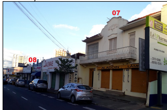
D. Edificação 07 e 08
