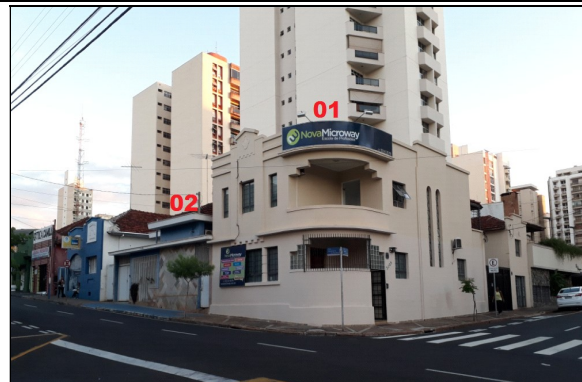
A. Edificações 01 e 02
