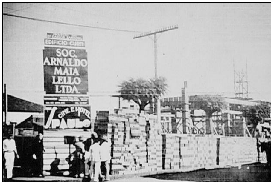
Foto 24: Tapume da Construção do Edifício Curti, com a placa da Sociedade Arnaldo Maia Lello Ltda, construtora do Prédio Fonte: Marques (2015)
