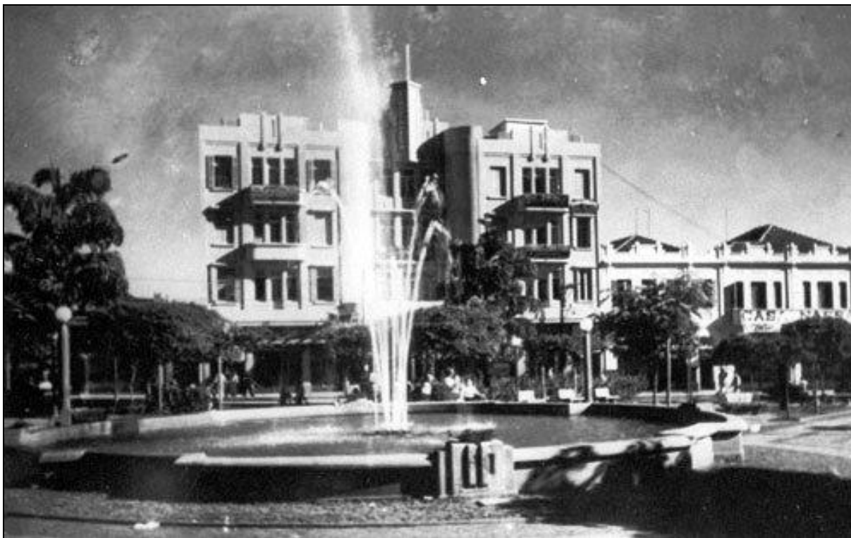
Foto 20: Fonte de água construída em frente ao edifício, com motivos Déco Fonte: acervo particular de Agostinho Brandi, gentilmente cedida
