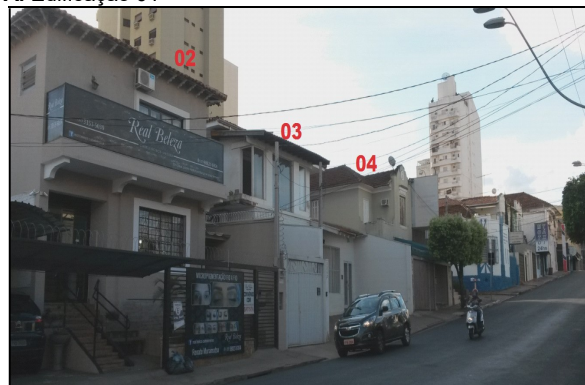
B. Edificações 02, 03 e 04
