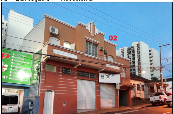
B. Edificação 02 – Art Déco
