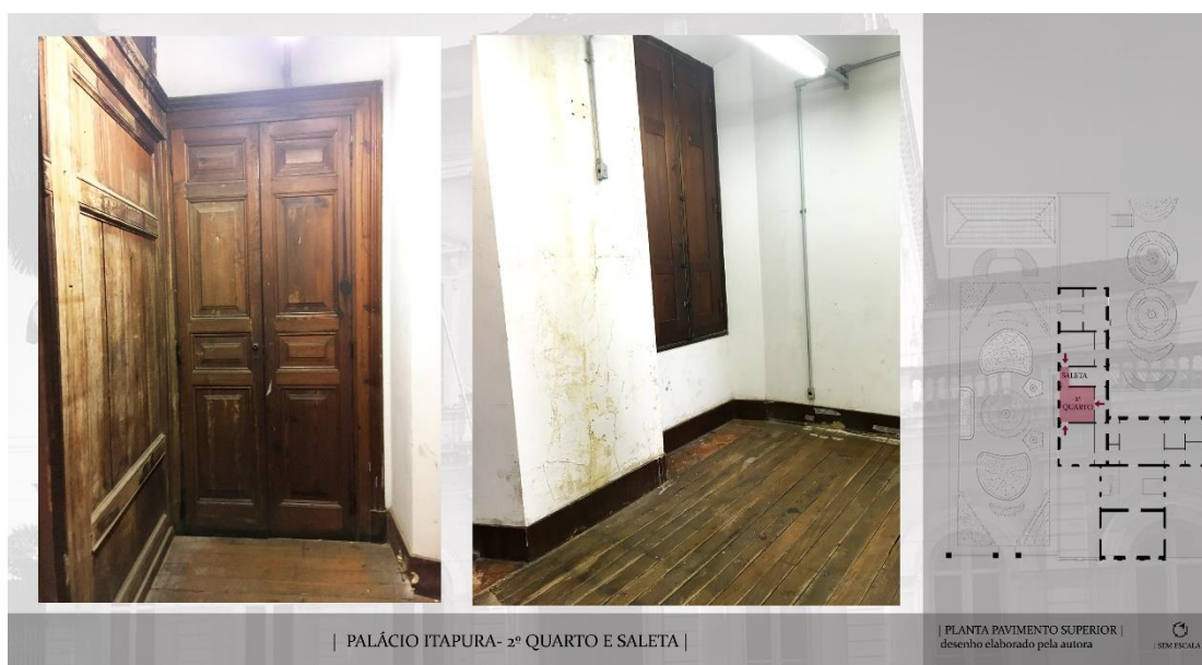
Figura 58- Fotografias do 2º quarto e saleta do Palácio Itapura- pavimento superior, 2019. Fonte: Acervo autoral da Autora. Fotos tiradas em 15 de janeiro de 2019.
