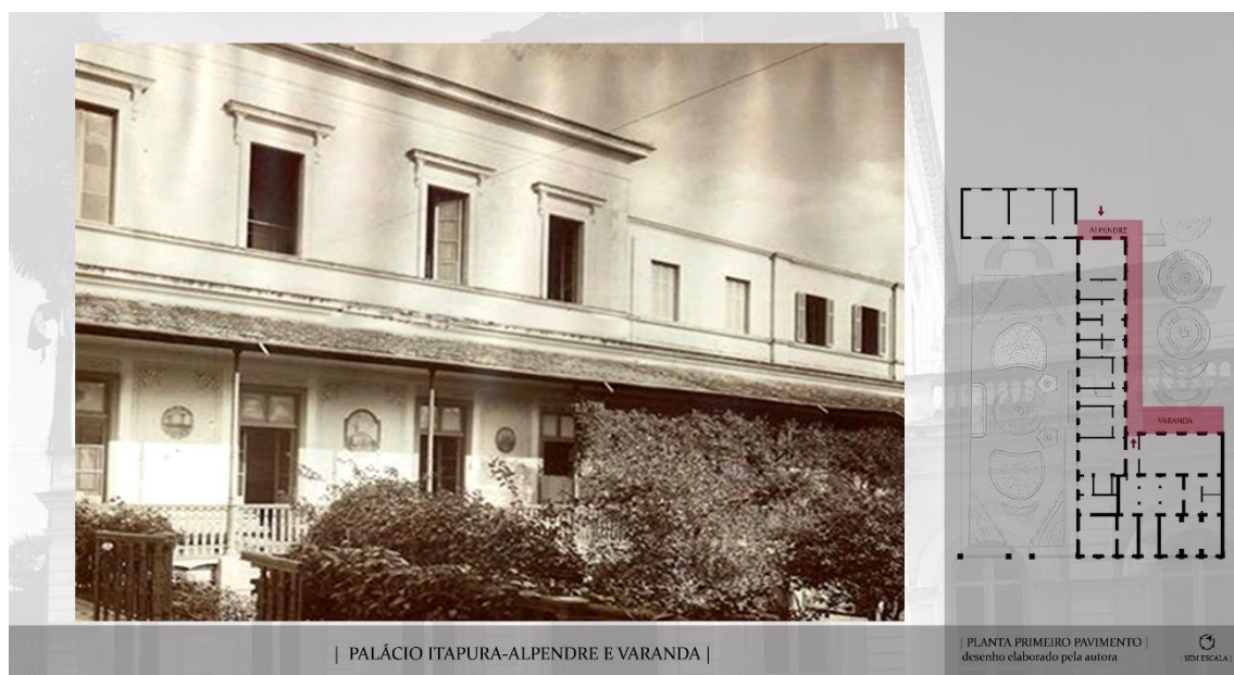
Figura 45- Fotografia tirada a partir da varanda do Palácio Itapura. Observa-se parte do jardim interno e parte do alpendre. Disponível em:
