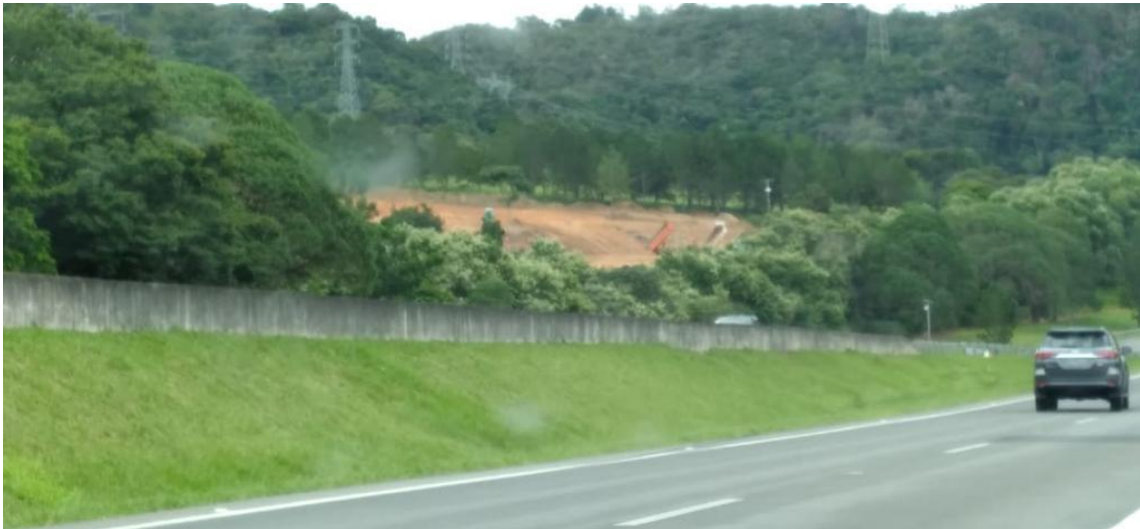
Figura 14 – Obras na Fazenda Santana dos Cuiabanos vista pela Rodovia Dom Pedro I, sentido Itatiba-Valinhos, a margem do Rio Atibaia. Autoria: desconhecida.
