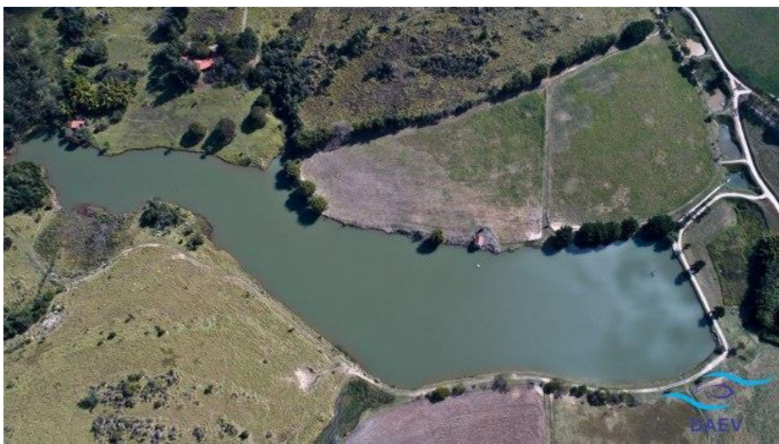
Figura 13 – Barragem do DAEV na Fazenda Santana dos Cuiabanos em Valinhos. Fonte: DAEV.
