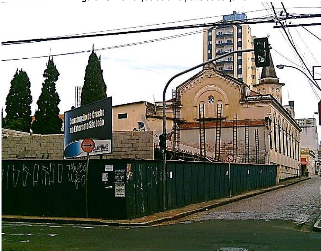
Figura 46: Demolição de uma parte do conjunto.
