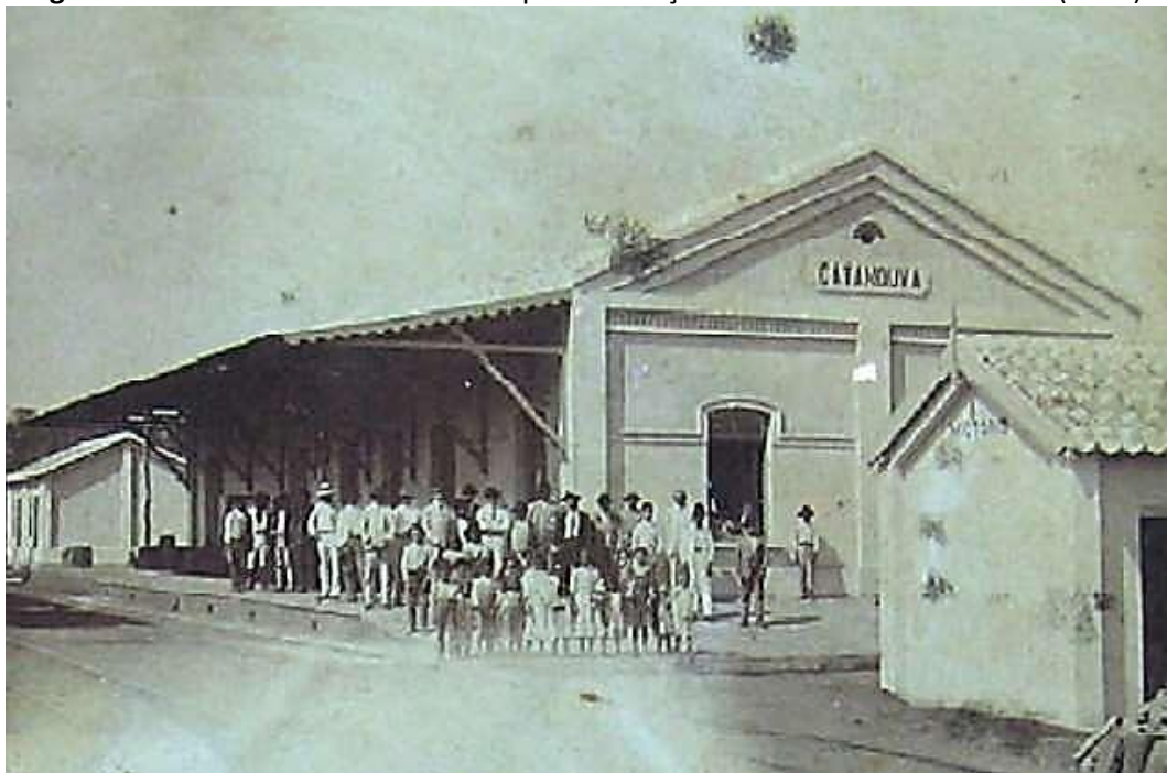
Figura 8: Primeiro edifício construído para a Estação Ferroviária de Catanduva (1910).
