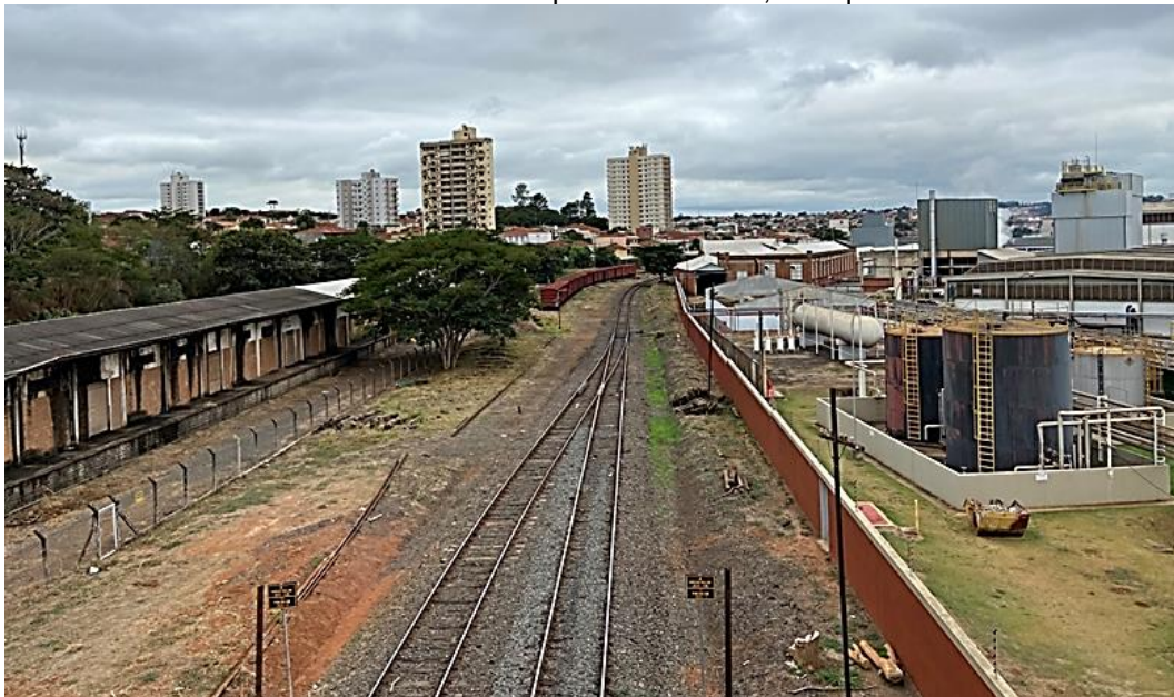
Figura 23: Vista 2– Sobre o Viaduto Miguel Pachá. Cocam (antiga Indústria Matarazzo), à direita, e remanescentes do complexo ferroviário, à esquerda.
