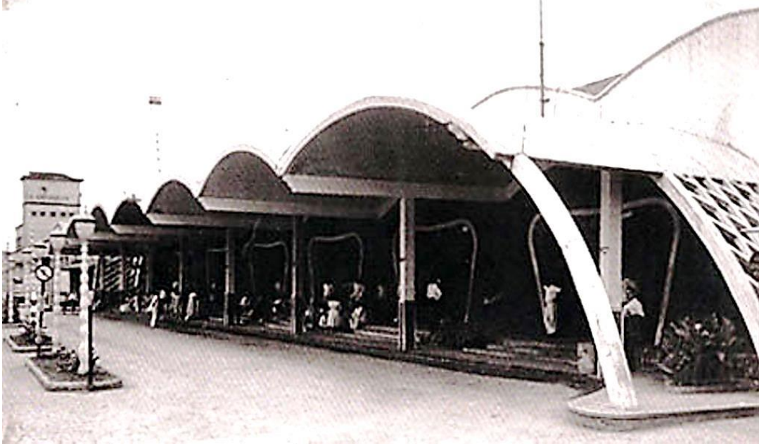
Figura 17: Estação Rodoviária de Catanduva, à época da inauguração (1959).
