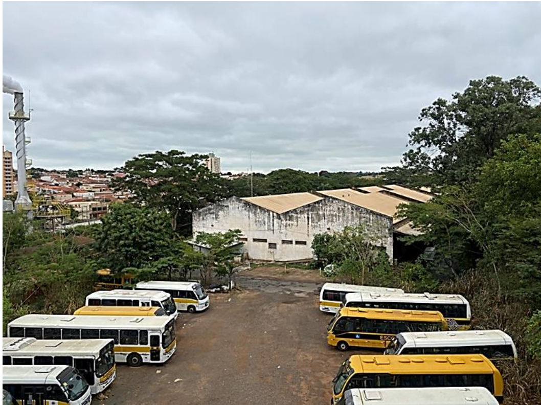
Figura 24: Vista 3 – Sobre o Viaduto Miguel Pachá, com vista para remanescentes do complexo ferroviário.
