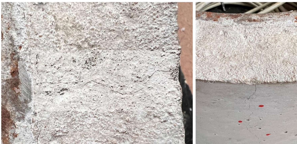
Figura 36: Fissuração radial na amostra 'CS – Anel 02'
